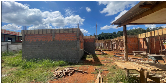
4 | FORMAS, ALVENARIA, CHAPISCO, VERGAS, CONTRA VERGAS
