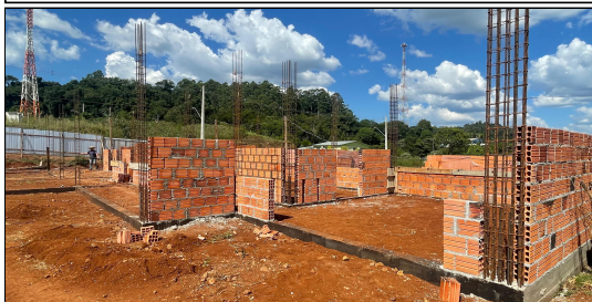
8 | ALVENARIA, ARMADURAS PILARES CONTRAVERGAS
