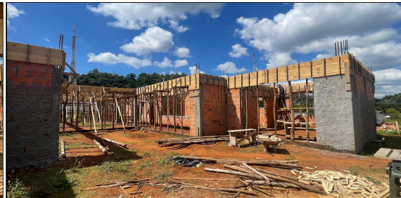
5 | FORMAS, ALVENARIA, CHAPISCO, VERGAS, CONTRA VERGAS
