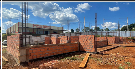
7 | ALVENARIA, ARMADURAS PILARES CONTRAVERGAS
