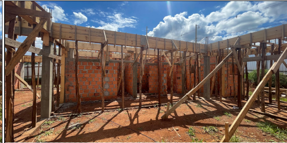
3 | FORMAS, ALVENARIA, CHAPISCO, VERGAS, CONTRA VERGAS
