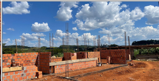
5 | ALVENARIA, ARMADURAS PILARES CONTRAVERGAS
