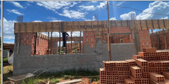
7 | FORMAS, ALVENARIA, CHAPISCO, VERGAS, CONTRA VERGAS
