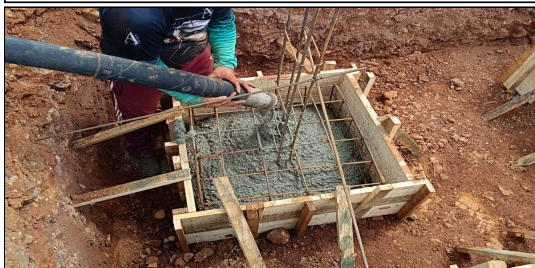
8 | CONCRETAGEM DOS BLOCOS
