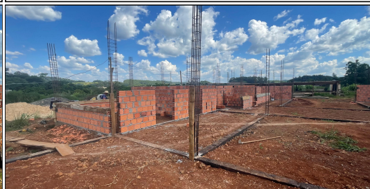
9 | ALVENARIA, ARMADURAS PILARES CONTRAVERGAS
