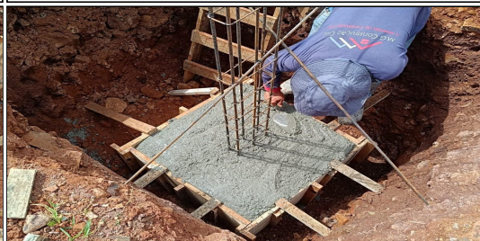
9 | ACABAMENTO SUPERFICIAL DOS BLOCOS
