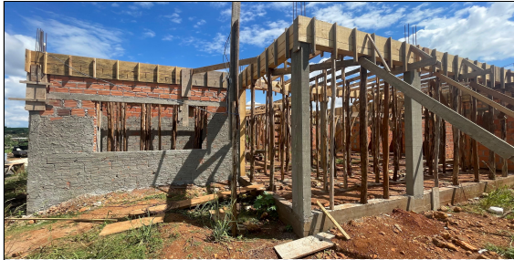
2 | FORMAS, ALVENARIA, CHAPISCO, VERGAS, CONTRA VERGAS
