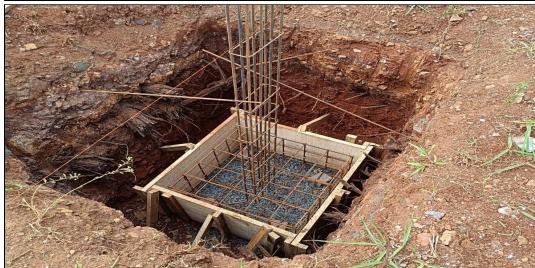
6 | CONFERENCIA DAS ARMADURAS DOS BLOCOS E FORMAS PARA CONCRETAGEM
