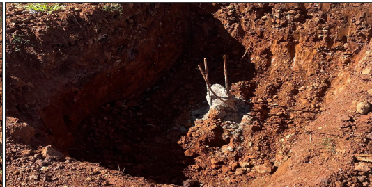
5 | ESCAVAÇÃO DOS BLOCOS APOS A CONCRETAGEM DAS ESTACAS
