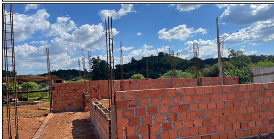
6 | ALVENARIA, ARMADURAS PILARES CONTRAVERGAS
