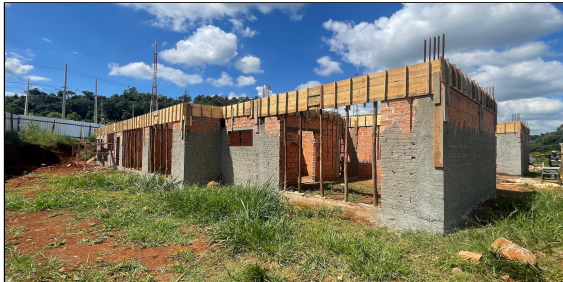
6 | FORMAS, ALVENARIA, CHAPISCO, VERGAS, CONTRA VERGAS
