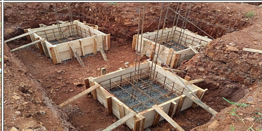
7 | CONFERENCIA DAS ARMADURAS DOS BLOCOS E FORMAS PARA CONCRETAGEM
