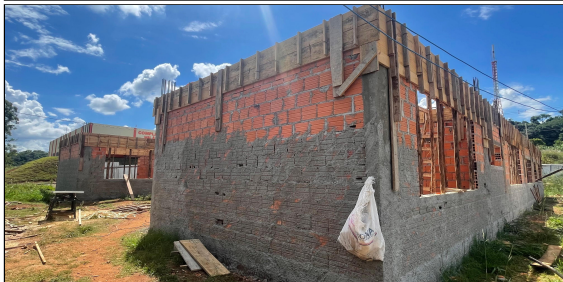
8 | FORMAS, ALVENARIA, CHAPISCO, VERGAS, CONTRA VERGAS
