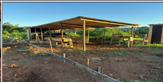
11 | CENTRAL DE ARMADURAS, DEPOSITO E SANITARIO
