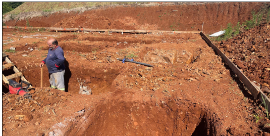
4 | ESCAVAÇÃO DOS BLOCOS APOS CONCRETAGEM DAS ESTACAS
