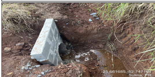
8 | ESTRADA PARA LINHA SEDE OURO - BUEIRO COM ALA
