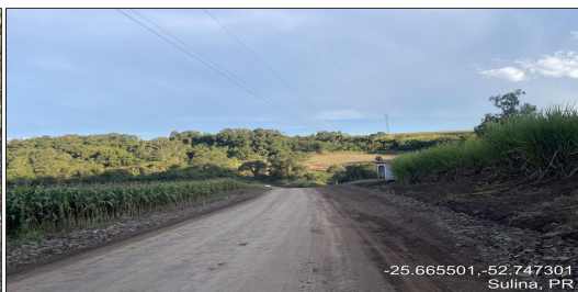
5 | ESTRADA PARA LINHA SEDE OURO - REGULARIZAÇÃO, COMPACTAÇÃO DO SUBLEITO
