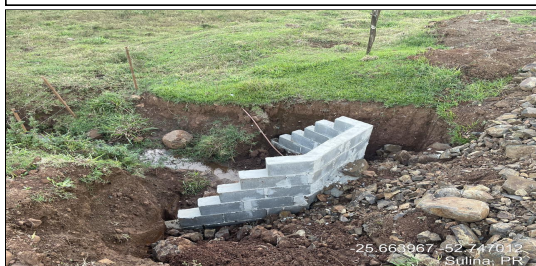
6 | ESTRADA PARA LINHA SEDE OURO - BUEIRO COM ALA
