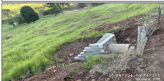
10 | ESTRADA PARA LINHA SEDE OURO - BUEIRO COM ALA
