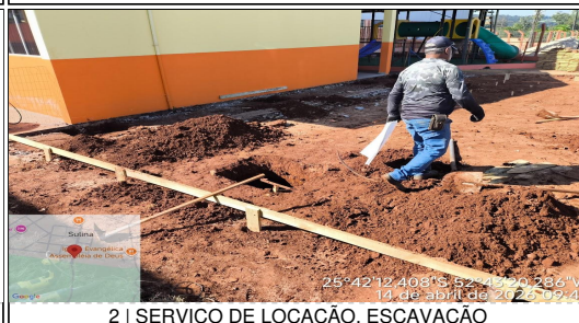
2 | SERVIÇO DE LOCAÇÃO, ESCAVAÇÃO
