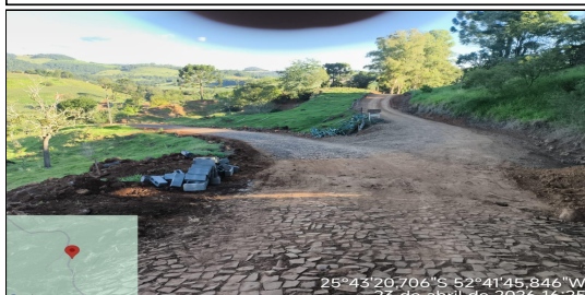
7 | SERVIÇO EXECUTADO DE ESCAVAÇÃO DE BUEIRO, REMOÇÃO DE BUEIRO 0,40M, REATERRO E APILOAMENTO MECÂNICO, CORPO DE BSTC Ø 0,60 SEM BERÇO E SEM
