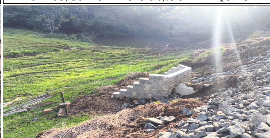
11 | SERVIÇO EXECUTADO DE ESCAVAÇÃO DE BUEIRO, REMOÇÃO DE BUEIRO 0,40M, REATERRO E APILOAMENTO MECÂNICO, CORPO DE BSTC Ø 0,60 SEM BERÇO E SEM
