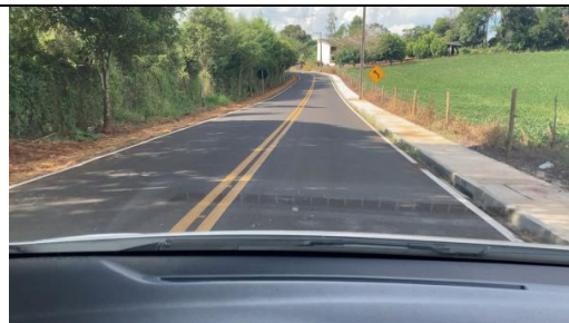
BOCA DE LOBO – PONTO 3
