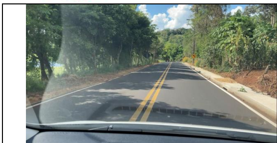
BOCA DE LOBO - PONTO 5
