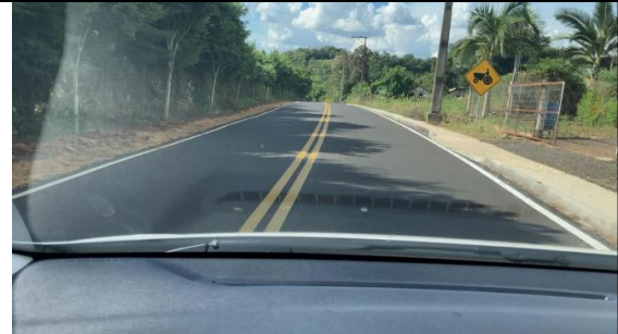
SINALIZAÇÃO DE TRÂNSITO, SARGETEAMENTO E PLANTIO DE GRAMA - PONTO 4
