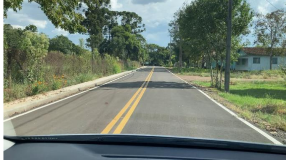
CALÇADA EM CONCRETO – PONTO 12
