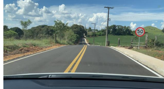
SINALIZAÇÃO DE TRÂNSITO, SARGETEAMENTO E PLANTIO DE GRAMA – PONTO 2
