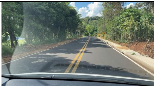
BOCA DE LOBO - PONTO 5
