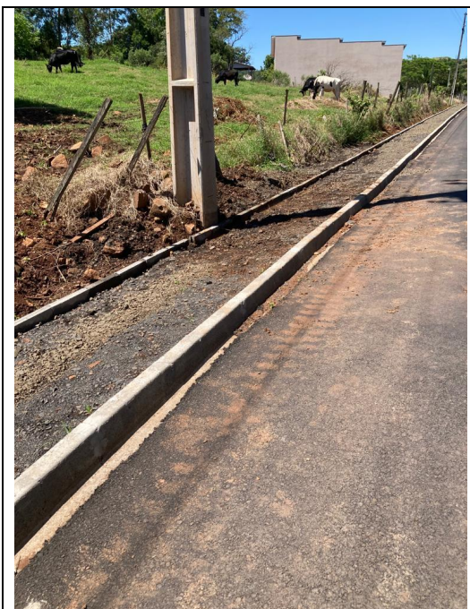
BASE DA CALÇADA EM BRITA GRADUADA E FINCADINHAS – PONTO 2
