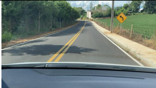
SINALIZAÇÃO DE TRÂNSITO, SARGETEAMENTO E PLANTIO DE GRAMA – PONTO 3
