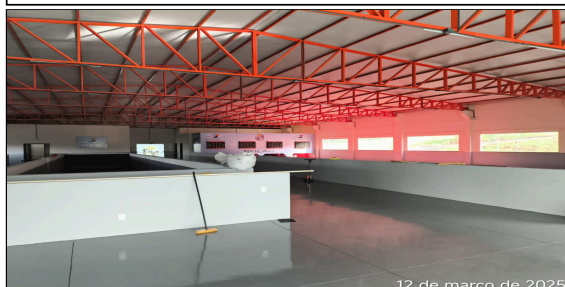
12 de março de 2025 8 | ELETRODUTO RÍGIDO ROSCÁVEL, PVC, DN 25 MM (3/4"), PARA CIRCUITOS TERMINAIS, INSTALADO EM FORRO - FORNECIMENTO E INSTALAÇÃO. AF_12/2015 8.11 CABO DE
