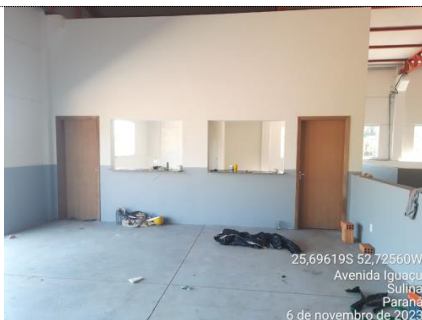
FOTO 27 ITEM 7.4: KIT DE PORTA DE MADEIRA PARA VERNIZ, SEMI-OCA (LEVE OU MÉDIA), PADRÃO POPULAR, 80X210CM, ESPESSURA DE 3,5CM, ITENS INCLUSOS: DOBRADIÇAS, MONTAGEM E INSTALAÇÃO DO BATENTE, SEM FECHADURA - FORNECIMENTO E INSTALAÇÃO. AF_12/2019 MEDIDO: 100%
