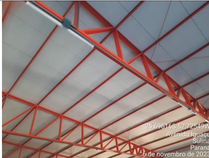
FOTO 23 ITEM 8.7: ELETRODUTO RÍGIDO ROSCÁVEL, PVC, DN 25 MM (3/4"), PARA CIRCUITOS TERMINAIS, INSTALADO EM FORRO - FORNECIMENTO E INSTALAÇÃO. AF_12/2015 MEDIDO: 73,50%
