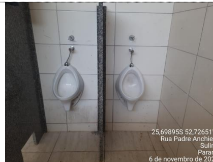
ITEM 9.56: MICTÓRIO SIFONADO LOUÇA BRANCA – PADRÃO MÉDIO – FORNECIMENTO E INSTALAÇÃO. AF_01/2020 MEDIDO: 100%
