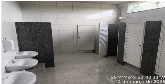
25°41'46"S 52°43'33"W 12 de março de 2025 4 | PORTA EM ALUMÍNIO DE ABRIR TIPO VENEZIANA COM GUARNIÇÃO, FIXAÇÃO COM PARAFUSOS - FORNECIMENTO E INSTALAÇÃO. AF_12/2019
