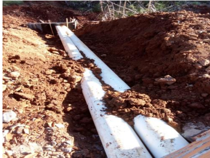
FOTO 17 ITEM 2.21: DISSIPADOR DE ENERGIA - DEB 03 - COM PEDRA DE MÃO MEDIDO: 100%
