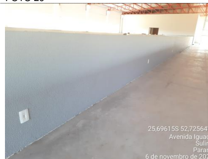
FOTO 28 ITEM 8.19: CAIXA RETANGULAR 4" X 2" BAIXA (0,30 M DO PISO), PVC, INSTALADA EM PAREDE - FORNECIMENTO E INSTALAÇÃO. AF_12/2015 MEDIDO: 100%
