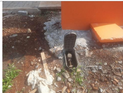
FOTO 20 ITEM 9.6: KIT CAVALETE PARA MEDIÇÃO DE ÁGUA - ENTRADA PRINCIPAL, EM PVC SOLDÁVEL DN 25 (3/4") FORNECIMENTO E INSTALAÇÃO (EXCLUSIVE HIDRÔMETRO). AF_11/2016 MEDIDO: 100%
