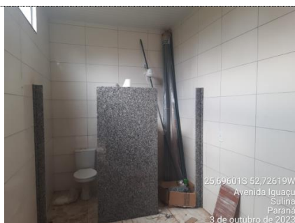
FOTO 11 ITEM 9.61: CHUVEIRO ELÉTRICO COMUM CORPO PLÁSTICO, TIPO DUCHA – FORNECIMENTO E INSTALAÇÃO. AF_01/2020 MEDIDO: 100%
