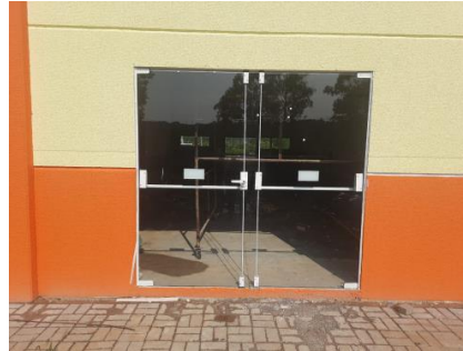
FOTO 18 ITEM 7.10: PORTA CORTA-FOGO 90X210X4CM - FORNECIMENTO E INSTALAÇÃO. AF_12/2019 MEDIDO: 100%
