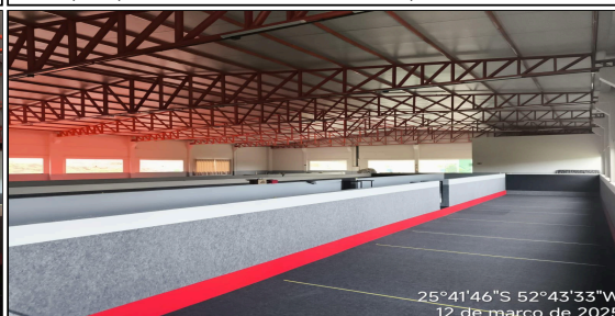
25°41'46"S 52°43'33"W 12 de março de 2025 5 | GUARDA-CORPO DE AÇO GALVANIZADO DE 1,10M DE ALTURA, MONTANTES TUBULARES DE 1.1/2" ESPAÇADOS DE 1,20M, TRAVESSA SUPERIOR DE 2", GRADIL FORMADO
