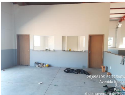
FOTO 27 ITEM 7.4: KIT DE PORTA DE MADEIRA PARA VERNIZ, SEMI-OCA (LEVE OU MÉDIA), PADRÃO POPULAR, 80X210CM, ESPESSURA DE 3,5CM, ITENS INCLUSOS: DOBRADIÇAS, MONTAGEM E INSTALAÇÃO DO BATENTE, SEM FECHADURA - FORNECIMENTO E INSTALAÇÃO. AF_12/2019 MEDIDO: 100%
