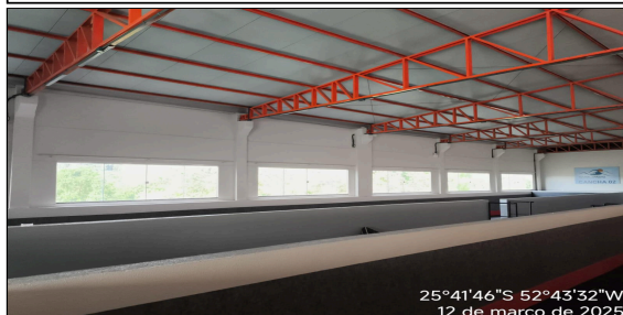
25°41'46"S 52°43'32"W 12 de março de 2025 6 | JANELA DE ALUMÍNIO DE CORRER COM 4 FOLHAS PARA VIDROS, COM VIDROS, BATENTE, ACABAMENTO COM ACETATO OU BRILHANTE E FERRAGENS. EXCLUSIVE
