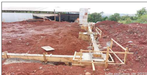
2 | Blocos, cálices e viga baldrame da lateral direita
