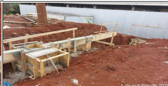
7 | Lateral esquerda: final da concretagem da baldrame
