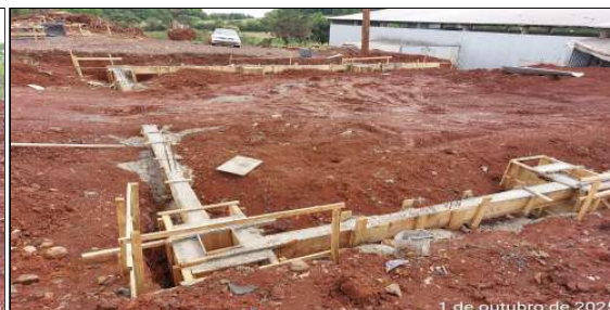
3 | Blocos, cálices e viga baldrame da frente da obra
