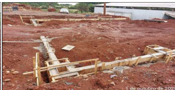
3 | Blocos, cálices e viga baldrame da frente da obra
