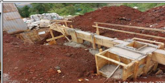
5 | Lateral direita: final da concretagem da baldrame
