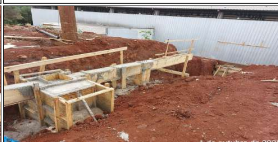
7 | Lateral esquerda: final da concretagem da baldrame
