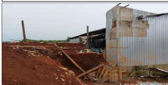
4 | Vista dos fundos: demolições realizadas
