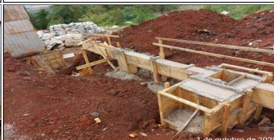
5 | Lateral direita: final da concretagem da baldrame
