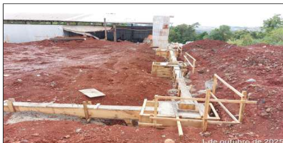
2 | Blocos, cálices e viga baldrame da lateral direita
