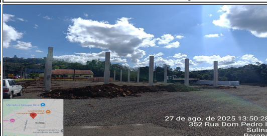
10 | SERVIÇO EXECUTADO PILAR PRÉ-FABRICADO EM CONCRETO ARMADO DE SEÇÃO 0.35X0.35X6,50MT, FORNECIMENTO E INSTALAÇÃO
