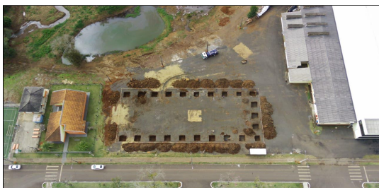
3 | SERVIÇO EXECUTADO DE LOCAÇÃO CONVENCIONAL DE OBRA, UTILIZANDO GABARITO DE TÁBUAS CORRIDAS PONTALETADAS A CADA 2,00M - 2 UTILIZAÇÕES. AF_03/2024
