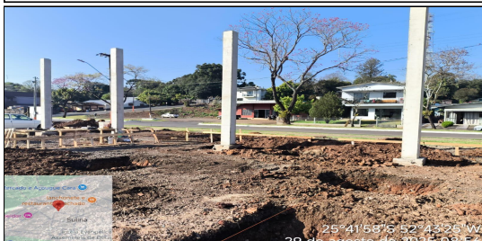
7 | SERVIÇO EXECUTADO ESCAVAÇÃO MECANIZADA DE VALA COM PROF. ATÉ 1,5 M (MÉDIA MONTANTE E JUSANTE/UMA COMPOSIÇÃO POR TRECHO), ESCAVADEIRA
