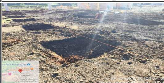
6 | SERVIÇO EXECUTADO ESCAVAÇÃO MANUAL DE VALA COM PROFUNDIDADE MENOR OU IGUAL A 1,30 M. AF_09/2024
