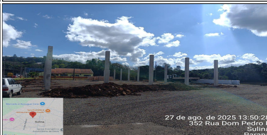
10 | SERVIÇO EXECUTADO PILAR PRÉ-FABRICADO EM CONCRETO ARMADO DE SEÇÃO 0.35X0.35X6,50MT, FORNECIMENTO E INSTALAÇÃO
