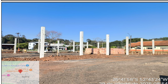
9 | SERVIÇO EXECUTADO PILAR PRÉ-FABRICADO EM CONCRETO ARMADO DE SEÇÃO 0.35X0.35X6,50MT, FORNECIMENTO E INSTALAÇÃO
