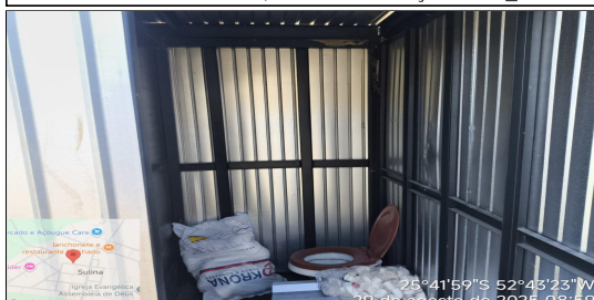
5 | SERVIÇO EXECUTADO EXECUÇÃO DE SANITÁRIO E VESTIÁRIO EM CANTEIRO DE OBRA EM CHAPA DE MADEIRA COMPENSADA, NÃO INCLUSO MOBILIÁRIO. AF_02/2016
