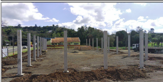
8 | SERVIÇO EXECUTADO PILAR PRÉ-FABRICADO EM CONCRETO ARMADO DE SEÇÃO 0.35X0.35X6,50MT, FORNECIMENTO E INSTALAÇÃO
