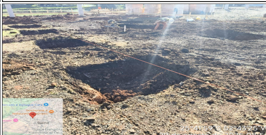
6 | SERVIÇO EXECUTADO ESCAVAÇÃO MANUAL DE VALA COM PROFUNDIDADE MENOR OU IGUAL A 1,30 M. AF_09/2024
