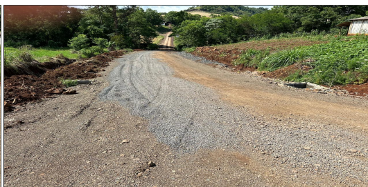
5 | RUA 01 – SERVIÇO EXECUTADO DE TERRAPLENAGEM, DRENAGEM
