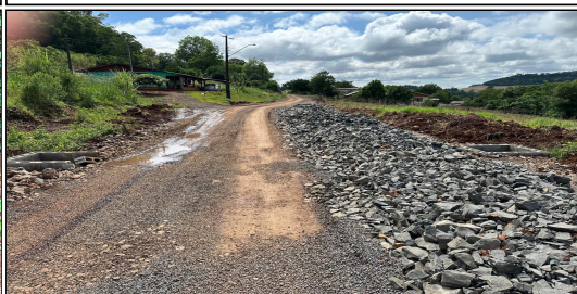
11 | RUA 04 – SERVIÇO EXECUTADO DE TERRAPLENAGEM, DRENAGEM
