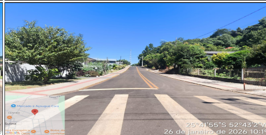
25°41'55"S 52°43'2"W 26 de janeiro de 2026 10:19 10 | RUA SANTOS DUMONT - SERVIÇO EXECUTADO DE SINALIZAÇÃO DE TRÂNSITO
