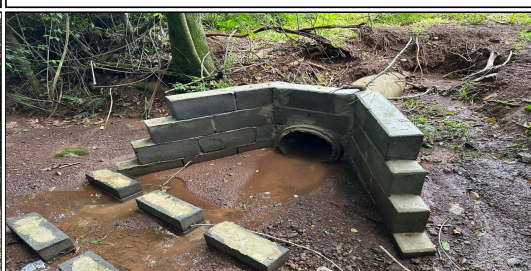
9 | RUA 02 – SERVIÇO EXECUTADO DE TERRAPLENAGEM, DRENAGEM
