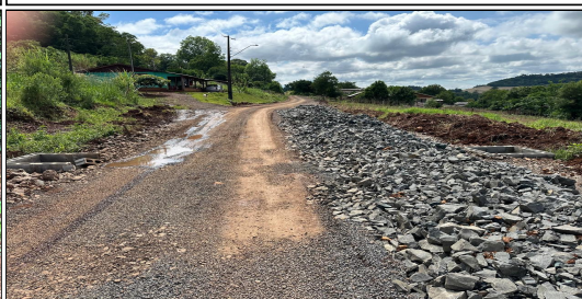
11 | RUA 04 – SERVIÇO EXECUTADO DE TERRAPLENAGEM, DRENAGEM
