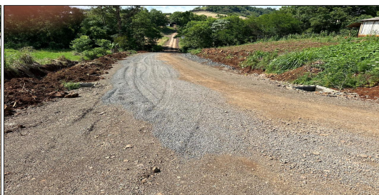
5 | RUA 01 – SERVIÇO EXECUTADO DE TERRAPLENAGEM, DRENAGEM
