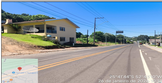
25°41'44"S 52°43'10"W 26 de janeiro de 2026 10:18 9 | RUA SALDANHA MARINHO - SERVIÇO EXECUTADO DE SINALIZAÇÃO DE TRÂNSITO
