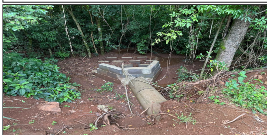
10 | RUA 02 – SERVIÇO EXECUTADO DE TERRAPLENAGEM, DRENAGEM
