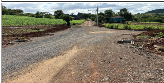
6 | RUA 02 – SERVIÇO EXECUTADO DE TERRAPLENAGEM, DRENAGEM
