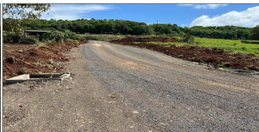
13 | RUA 03 – SERVIÇO EXECUTADO DE TERRAPLENAGEM, DRENAGEM
