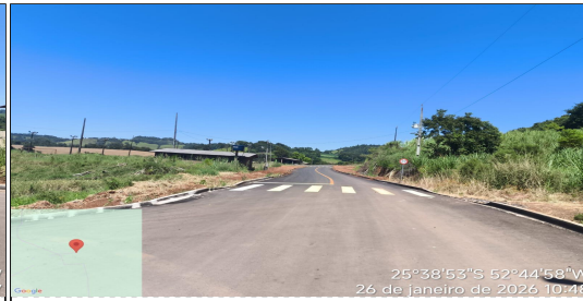
25°38'53"S 52°44'58"W 26 de janeiro de 2026 10:48 6 | RUA SEDE OURO 04 - SERVIÇO EXECUTADO DE TERRAPLENAGEM, DRENAGEM, BASE/SUB BASE, REVESTIMENTO, MEIO FIO, SERVIÇO DE URBANIZAÇÃO,
