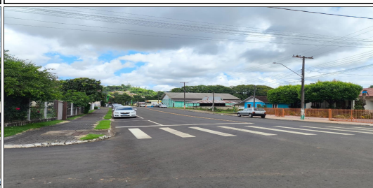
15 | RUA ANTÔNIO DIONISIO REICHART, SERVIÇO DE SINALIZAÇÃO DE TRÂNSITO EXECUTADO
