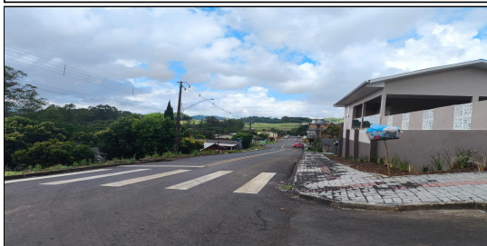
18 | RUA BARRÃO DO RIO BRANCO, SERVIÇO DE SINALIZAÇÃO DE TRÂNSITO EXECUTADO
