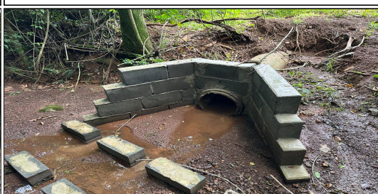
9 | RUA 02 – SERVIÇO EXECUTADO DE TERRAPLENAGEM, DRENAGEM
