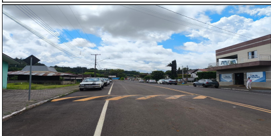
16 | RUA ANTÔNIO DIONISIO REICHART, SERVIÇO DE SINALIZAÇÃO DE TRÂNSITO EXECUTADO
