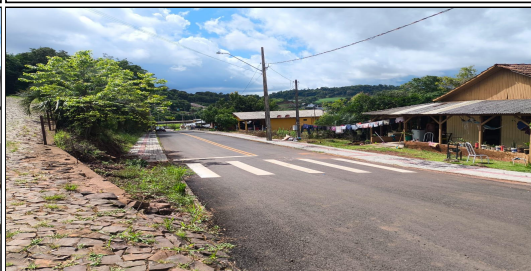
19 | RUA SANTOS DUMONT, SERVIÇO DE SINALIZAÇÃO DE TRÂNSITO EXECUTADO
