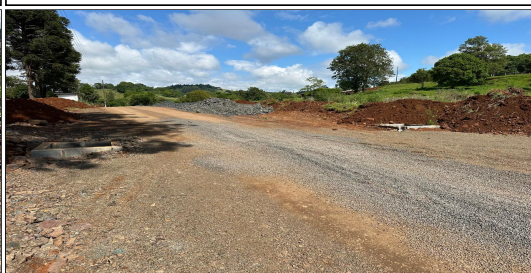
7 | RUA 02 – SERVIÇO EXECUTADO DE TERRAPLENAGEM, DRENAGEM
