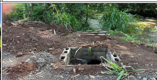
3 | RUA 01 – SERVIÇO EXECUTADO DE TERRAPLENAGEM, DRENAGEM
