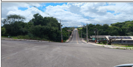
14 | RUA COMENDADOR ARAÚJO, SERVIÇO DE SINALIZAÇÃO DE TRÂNSITO EXECUTADO
