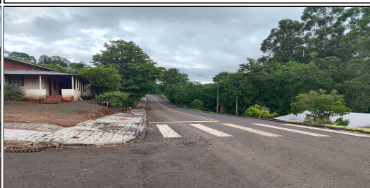
17 | RUA BARRÃO DO RIO BRANCO, SERVIÇO DE SINALIZAÇÃO DE TRÂNSITO EXECUTADO
