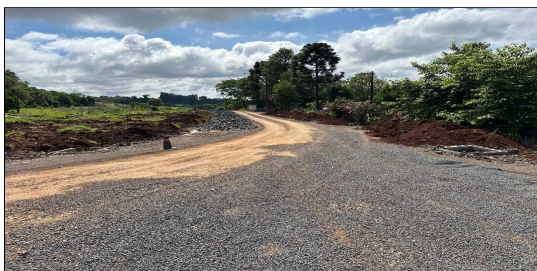
12 | RUA 03 – SERVIÇO EXECUTADO DE TERRAPLENAGEM, DRENAGEM
