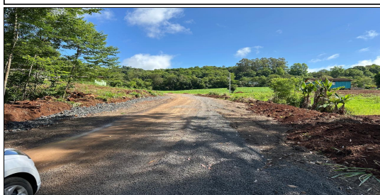
2 | RUA 01 – SERVIÇO EXECUTADO DE TERRAPLENAGEM, DRENAGEM
