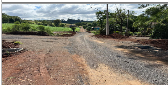
8 | RUA 02 – SERVIÇO EXECUTADO DE TERRAPLENAGEM, DRENAGEM
