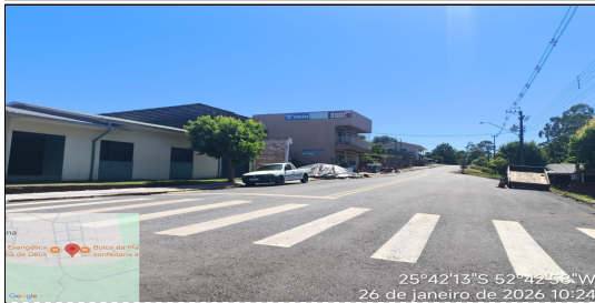
25°42'13"S 52°42'58"W 26 de janeiro de 2026 10:24 11 | RUA BARRÃO DO RIO BRANCO - SERVIÇO EXECUTADO DE SINALIZAÇÃO DE TRÂNSITO
