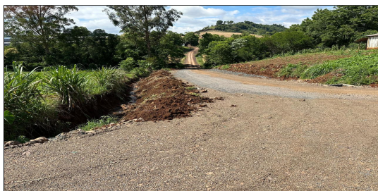
4 | RUA 01 – SERVIÇO EXECUTADO DE TERRAPLENAGEM, DRENAGEM
