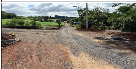
8 | RUA 02 – SERVIÇO EXECUTADO DE TERRAPLENAGEM, DRENAGEM
