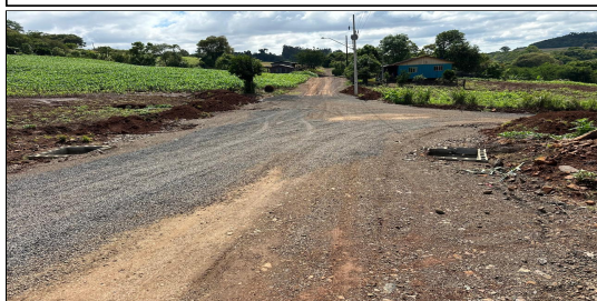
6 | RUA 02 – SERVIÇO EXECUTADO DE TERRAPLENAGEM, DRENAGEM
