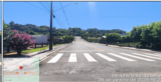
25°42'6"S 52°42'59"W 26 de janeiro de 2026 10:22 12 | RUA GETÚLIO VARGAS - SERVIÇO EXECUTADO DE SINALIZAÇÃO DE TRÂNSITO
