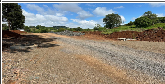
7 | RUA 02 – SERVIÇO EXECUTADO DE TERRAPLENAGEM, DRENAGEM
