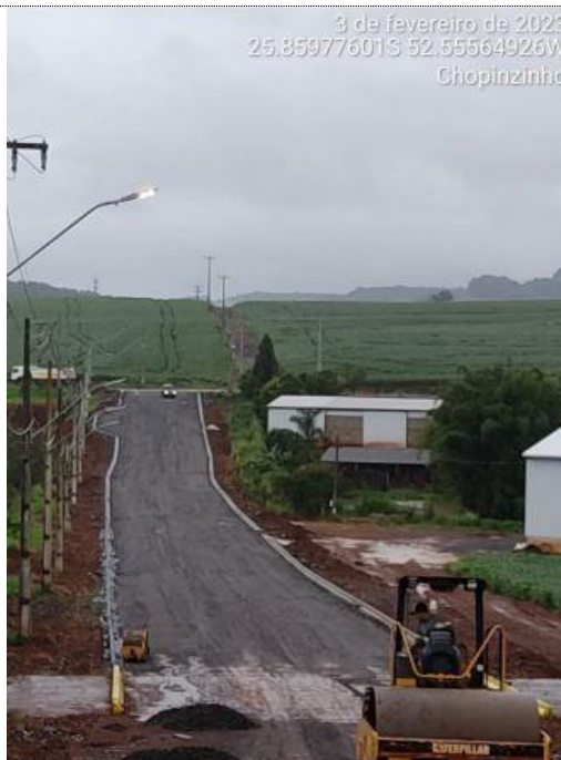
Foto 07 – Compactação da Base de brita graduada da Rua Joaquim Fávero.
