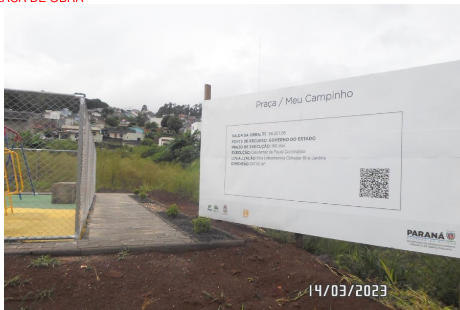
Figure 1 - Placa de obra instalada no Loteamento Jardins
