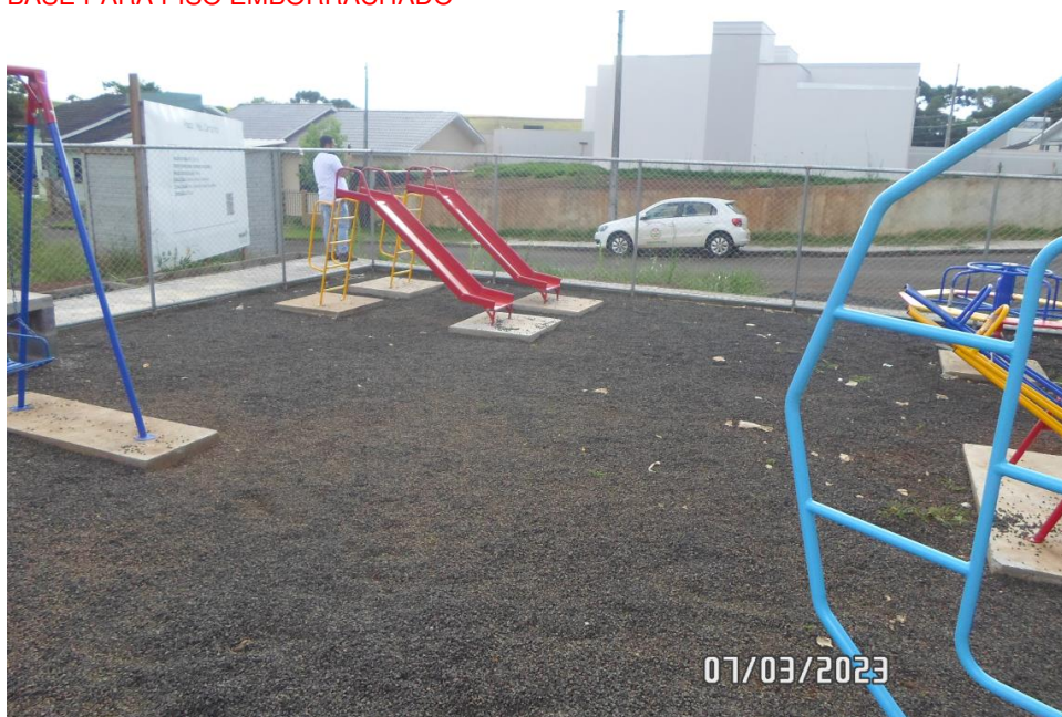
Figure 2 - Base para piso emborrachado
