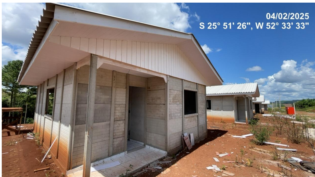
Foto 08 – Habitações tipo Padrão de frente para a R. Nébito Simões, com beiral, espelho e oitão finalizado – Local 02.
