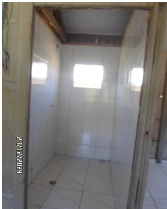
Foto 07 - Revestimento Cerâmico no banheiro de habitação acessível – Local 02.
