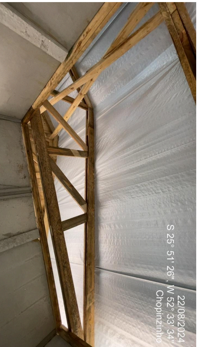
Foto 03 – Tesouras de madeira e manta térmica aluminiada.
