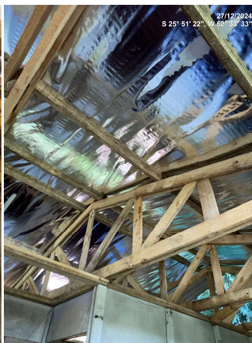
Foto 06 – Tesouras em madeira e manta térmica. (Local 04)
