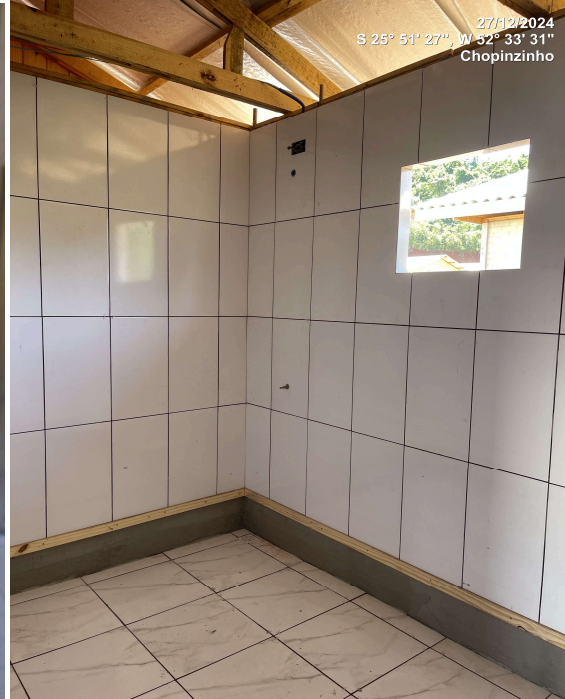
Foto 07 - Revestimento Cerâmico no banheiro de habitação acessível – Local 02.
