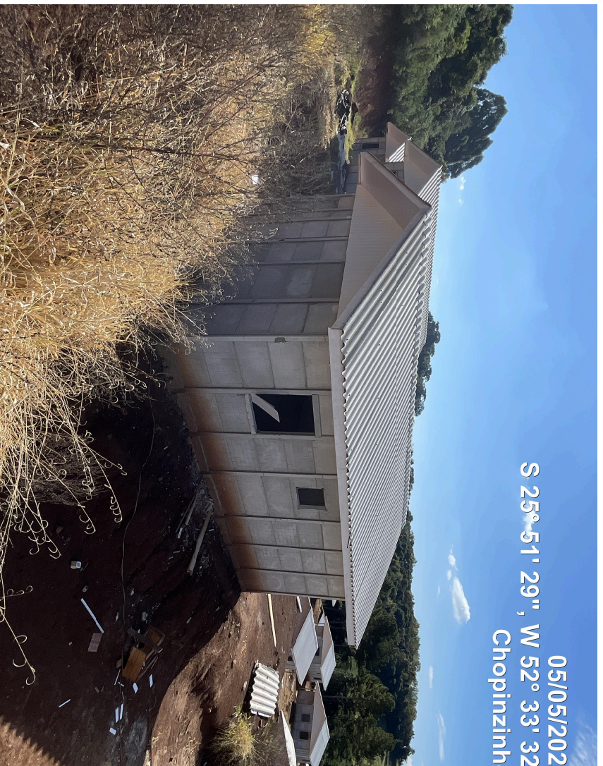
Foto 04 – Oitões, espelho e beiral executados (Local 05-06)
