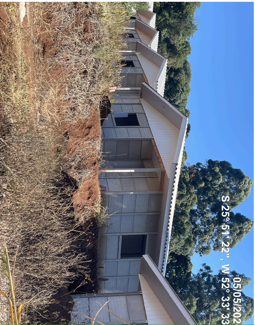
Foto 03 – Oitões, espelho e beiral executados (Local 04)
