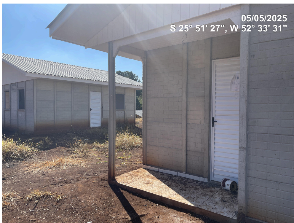
Foto 08 – Portas externas em alumínio instaladas (Local 01 e 02-07)
