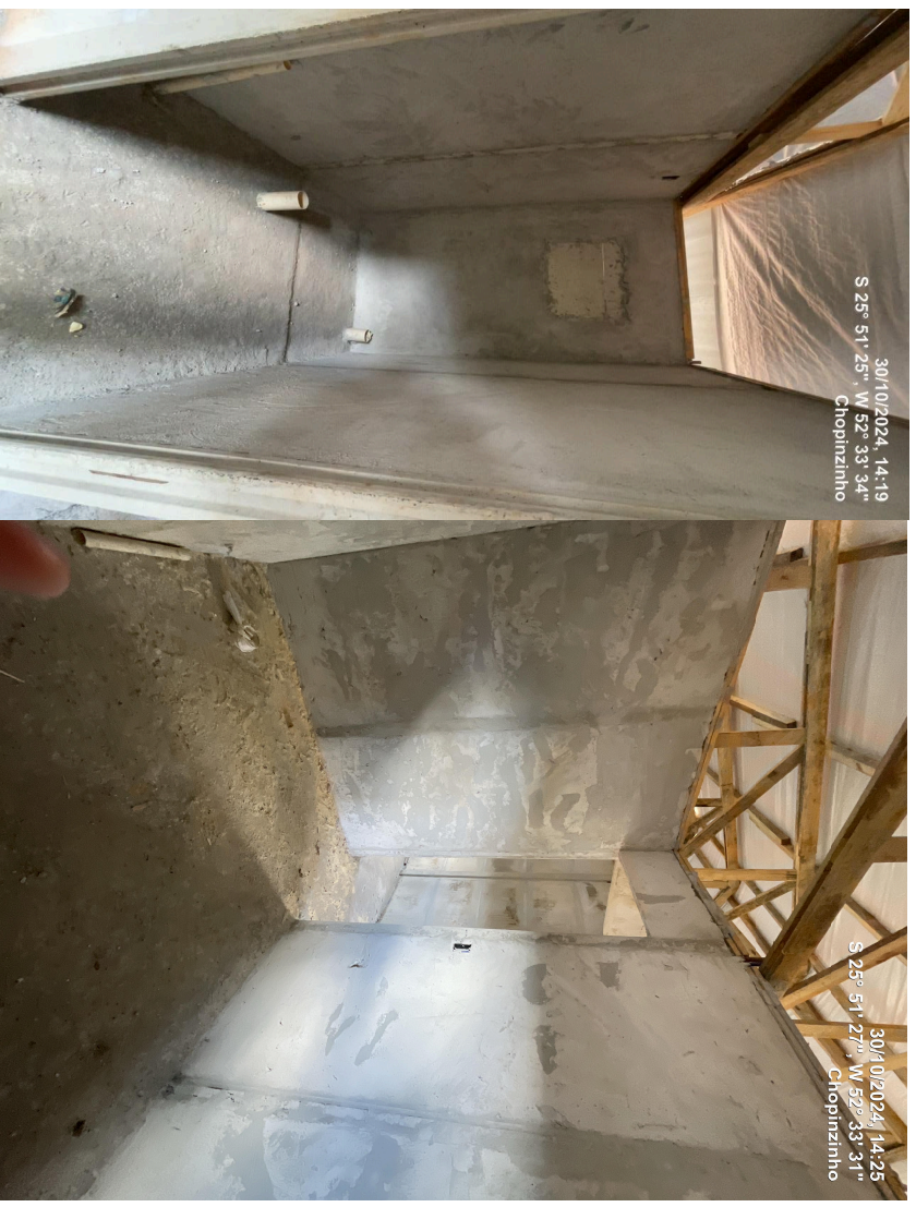
Foto 08 – Emassamento das paredes de banheiros, local 02 e 07.
