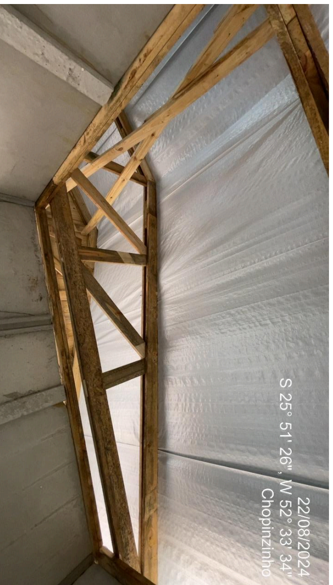
Foto 03 – Tesouras de madeira e manta térmica aluminiada.
