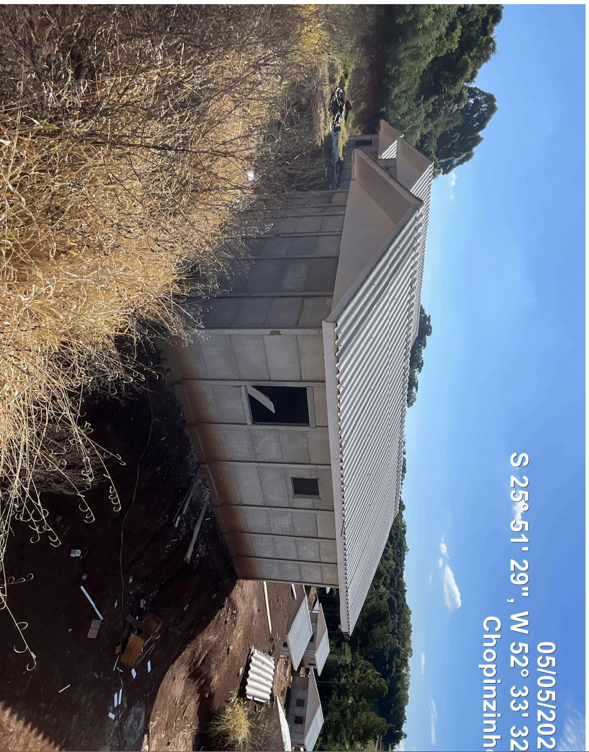
Foto 04 – Oitões, espelho e beiral executados (Local 05-06)
