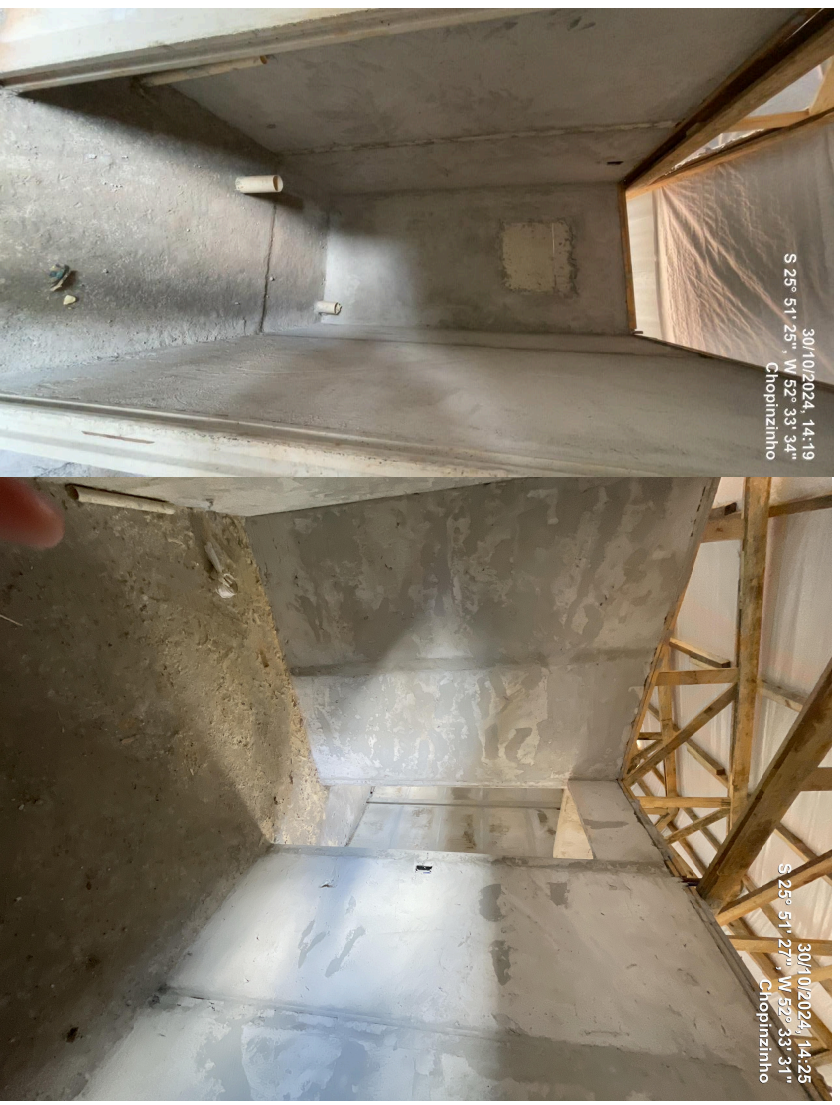
Foto 08 – Emassamento das paredes de banheiros, local 02 e 07.
