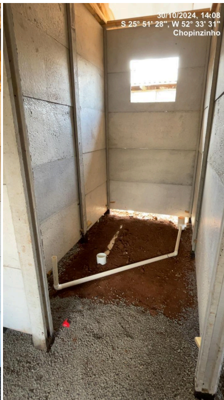
Foto 04 – Estrutura da cobertura com manta térmica aluminizada, lastro de brita iniciado, tubulação de esgoto iniciada.
