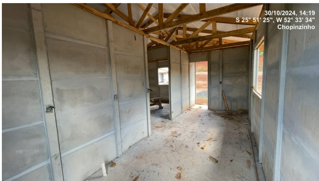
Foto 05 – Interior de habitação do Local 02, com piso de concreto executado e paredes com as juntas tratadas.
