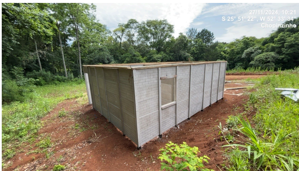
Foto 04 –Unidades habitacionais pré-moldadas em construção (Local 04)
