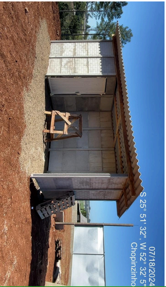
Foto 04 – Escritório de Obra com sanitário
