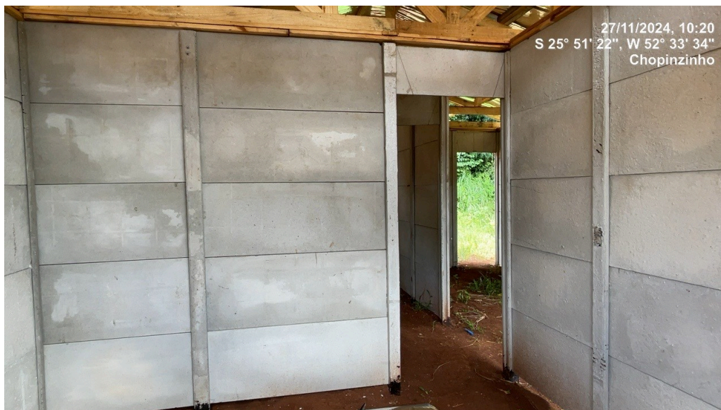
Foto 05 – Placas pré-moldadas interior da construção (Local 04)
