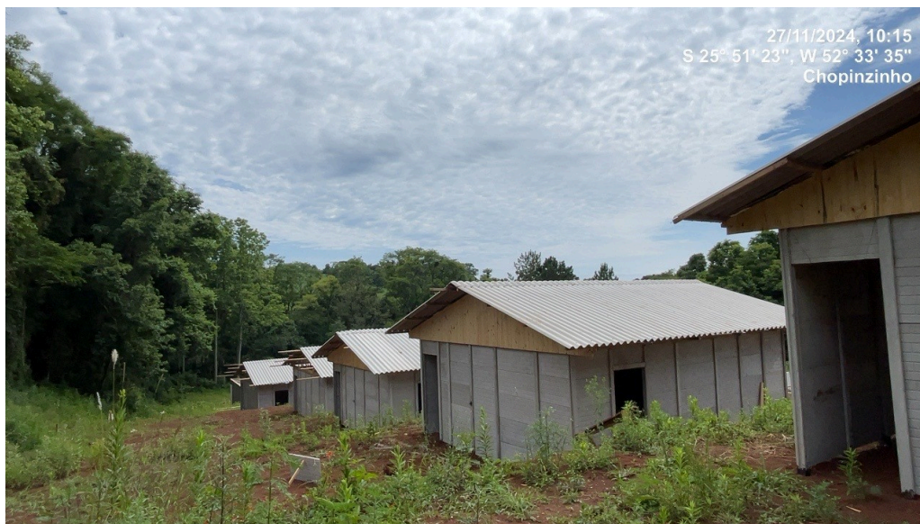
Foto 03 –Unidades habitacionais pré-moldadas em construção (Local 04)
