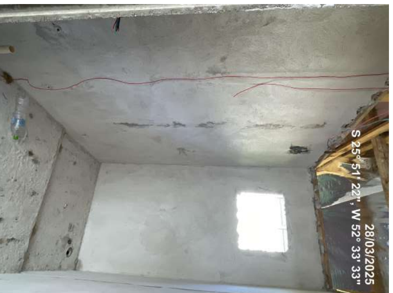
Foto 02 – Paredes do banheiro emboçadas (Local 04 e 05-06)
