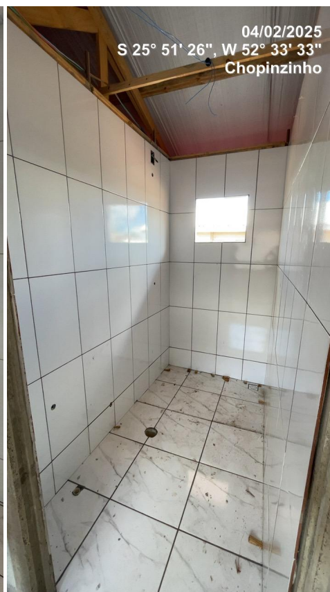
Foto 07 – Revestimento Cerâmico, Piso Cerâmico, pontos de esgoto, elétrica (Local 02 e 07)
