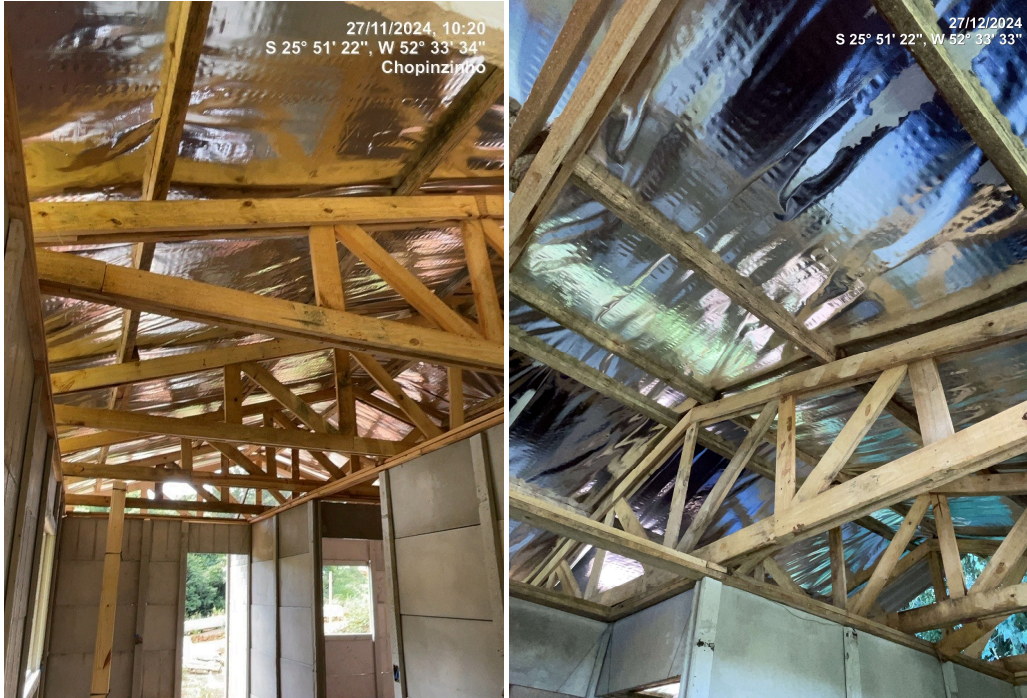
Foto 06 – Tesouras em madeira e manta térmica. (Local 04)
