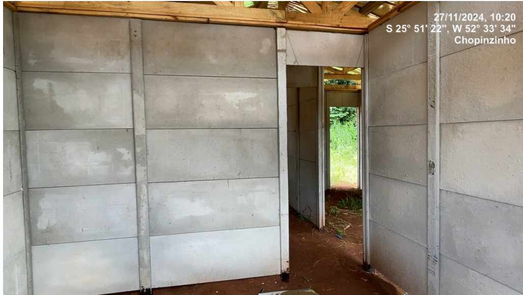
Foto 05 – Placas pré-moldadas interior da construção (Local 04)
