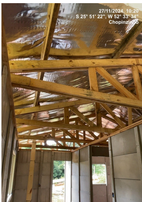
Foto 06 – Tesouras em madeira e manta térmica. (Local 04)
