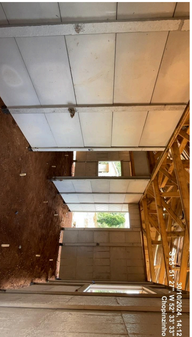
Foto 07 – Interior de habitação do Local 01 sem lastro executado.
