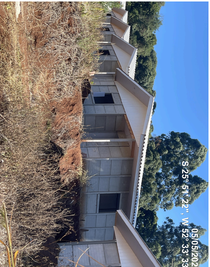
Foto 03 – Oitões, espelho e beiral executados (Local 04)
