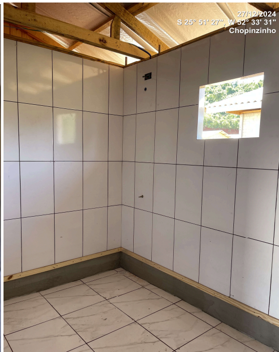
Foto 07 - Revestimento Cerâmico no banheiro de habitação acessível – Local 02.
