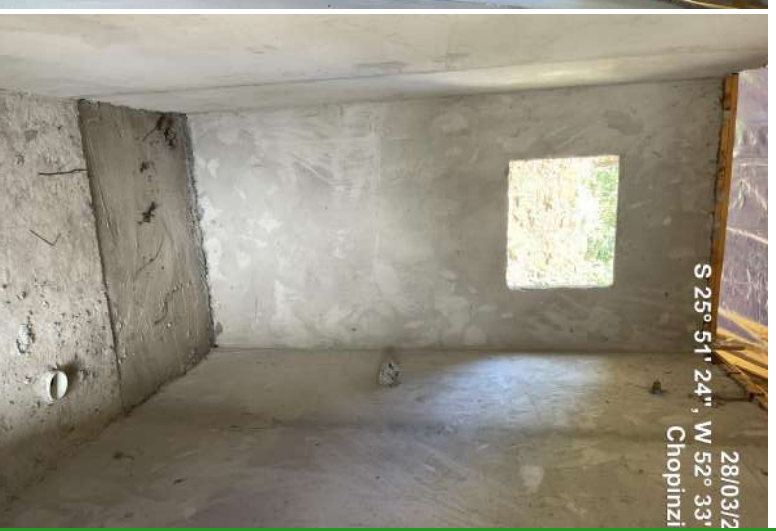
Foto 02 – Paredes do banheiro emboçadas (Local 04 e 05-06)
