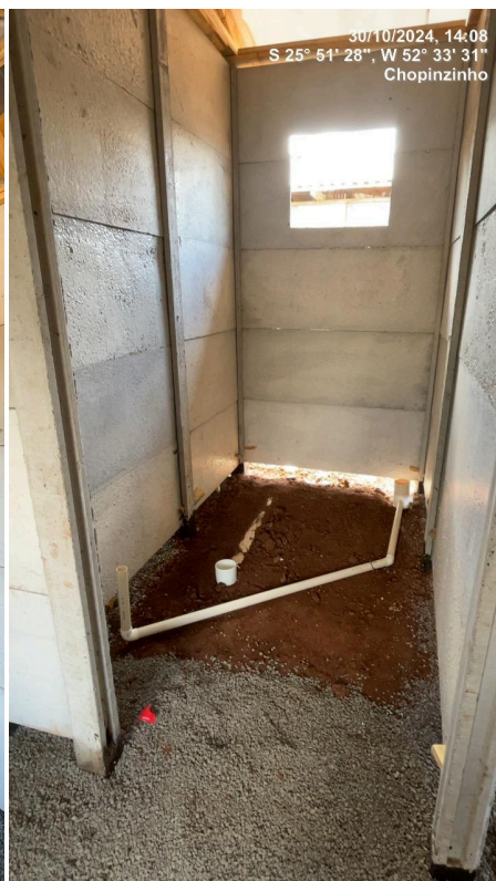
Foto 04 – Estrutura da cobertura com manta térmica aluminizada, lastro de brita iniciado, tubulação de esgoto iniciada.
