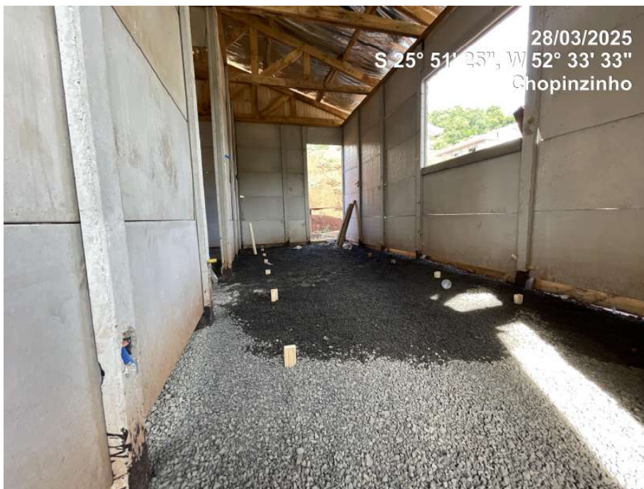
Foto 07 – Serviços em andamento (Local 03)
