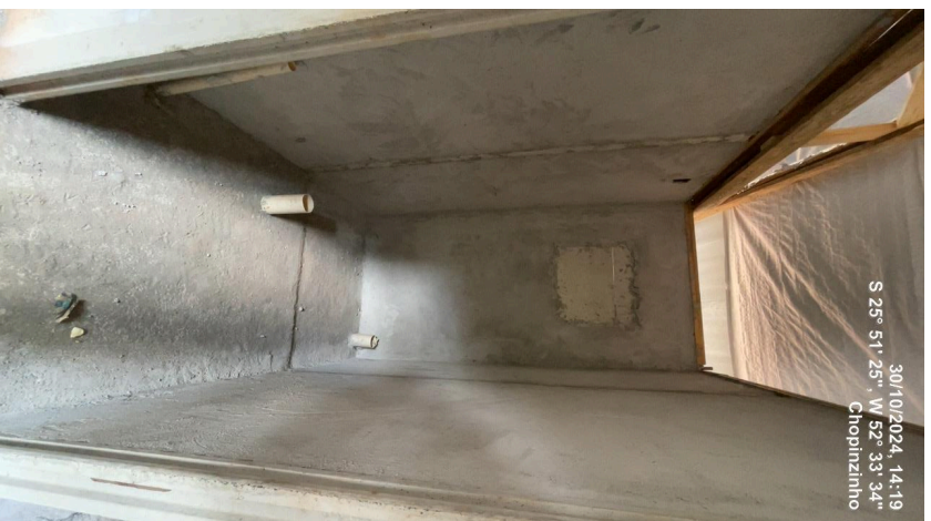
Foto 08 – Emassamento das paredes de banheiros, local 02 e 07.
