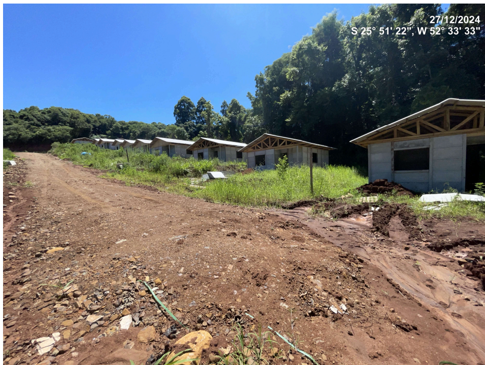
Foto 03 – Unidades habitacionais pré-moldadas em construção (Local 04)
