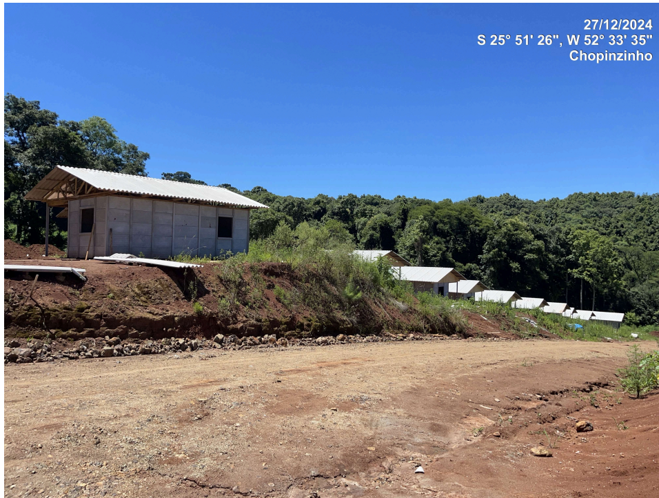
Foto 02 – Unidades habitacionais pré-moldadas em construção (Local 04)
