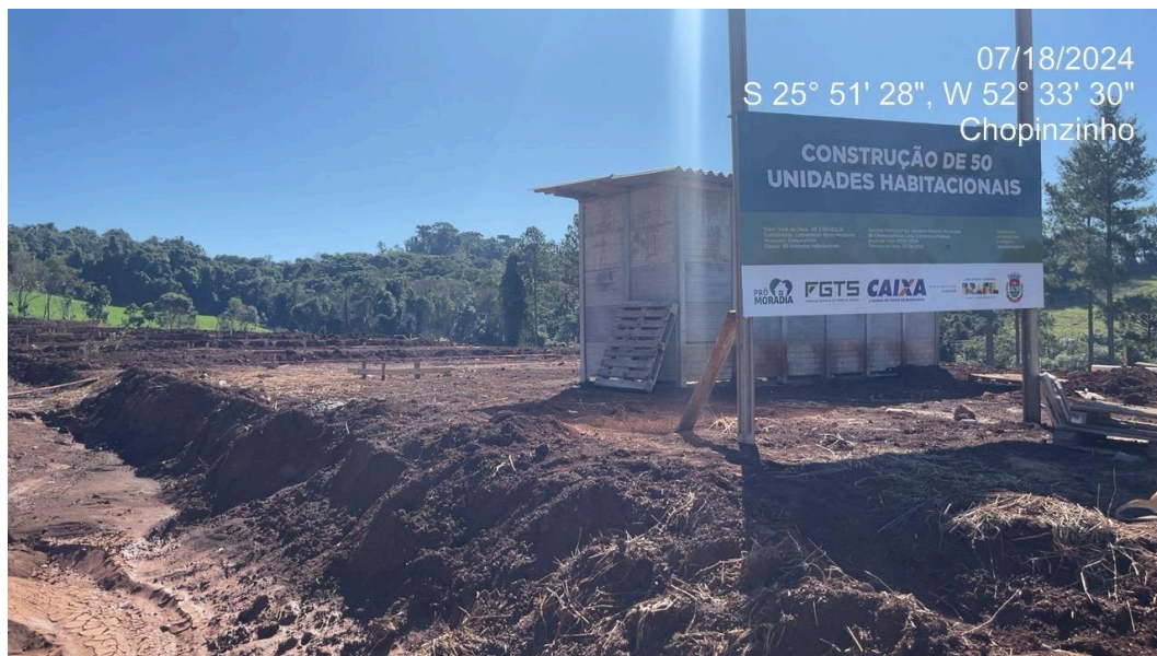
Foto 02 – Placa da obra e escritório da obra instalados no Lote 01 da Quadra 09 do Lot. Novo Horizonte. Rua Prof. Maria Fca. Chichorro, esquina com Domingos Baldisseira.
