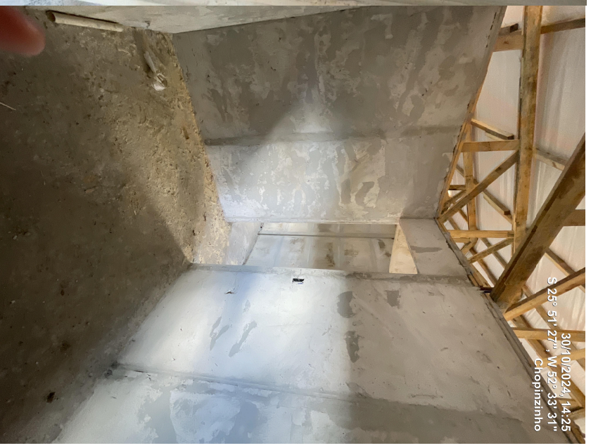
Foto 08 – Emassamento das paredes de banheiros, local 02 e 07.
