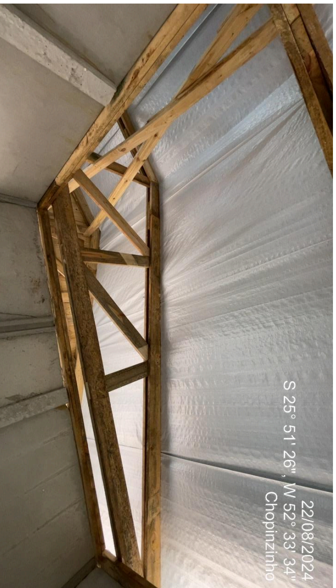
Foto 03 – Tesouras de madeira e manta térmica aluminiada.
