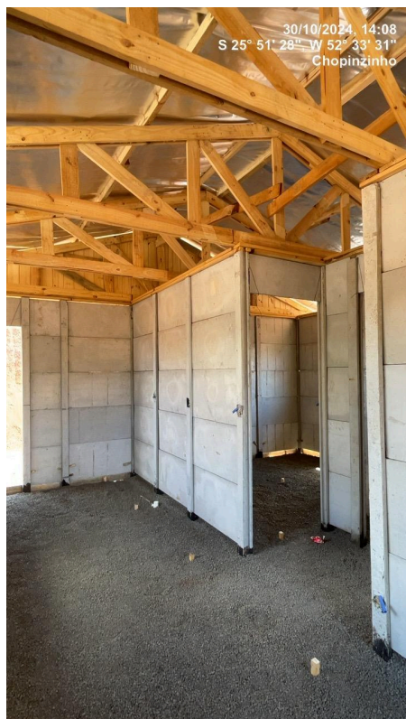
Foto 04 – Estrutura da cobertura com manta térmica aluminizada, lastro de brita iniciado, tubulação de esgoto iniciada.
