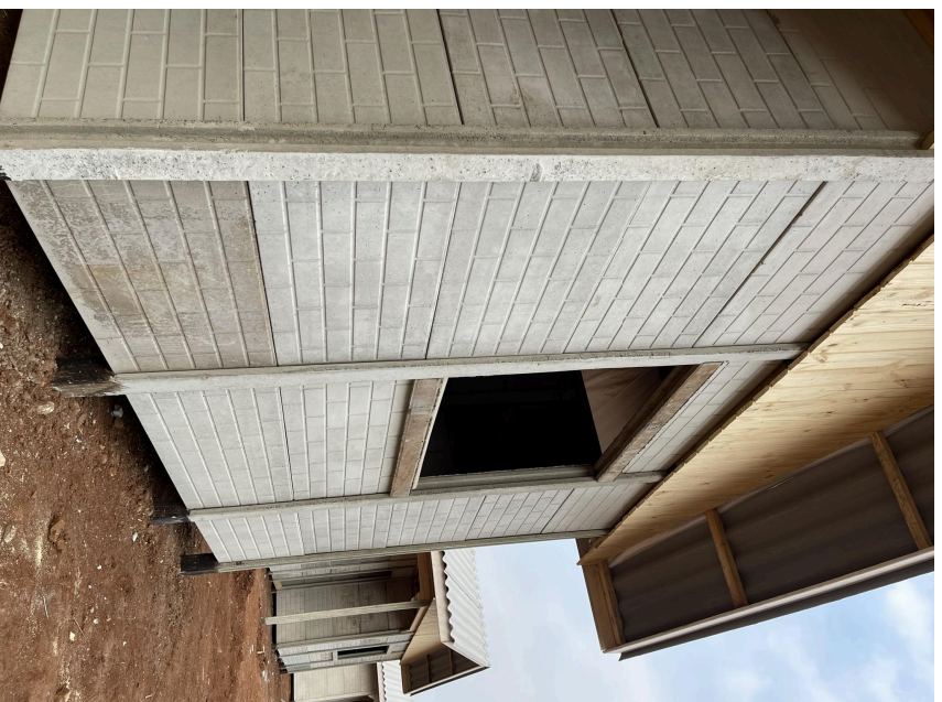
Foto 05 – Fachada de casa pre-moldada com verga e contra-verga instalada, oitão em madeira pinus 2,5cm
