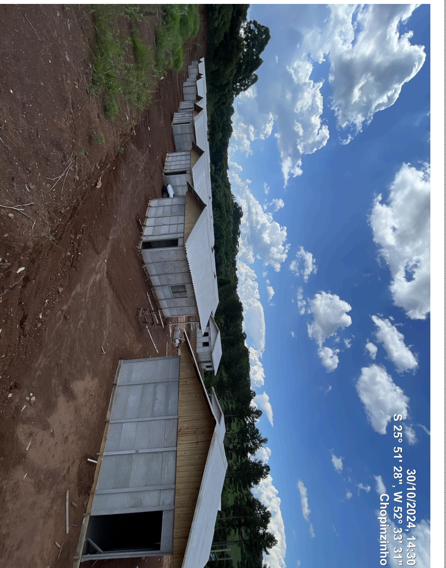
Foto 02 – 10 unidades habitacionais pré-moldadas, construídas e cobertas. (Local 01)
