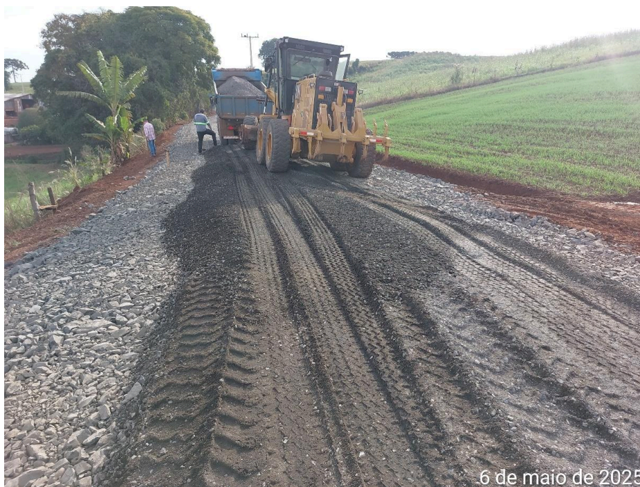
Foto 08. Execução da base em brita graduada.
