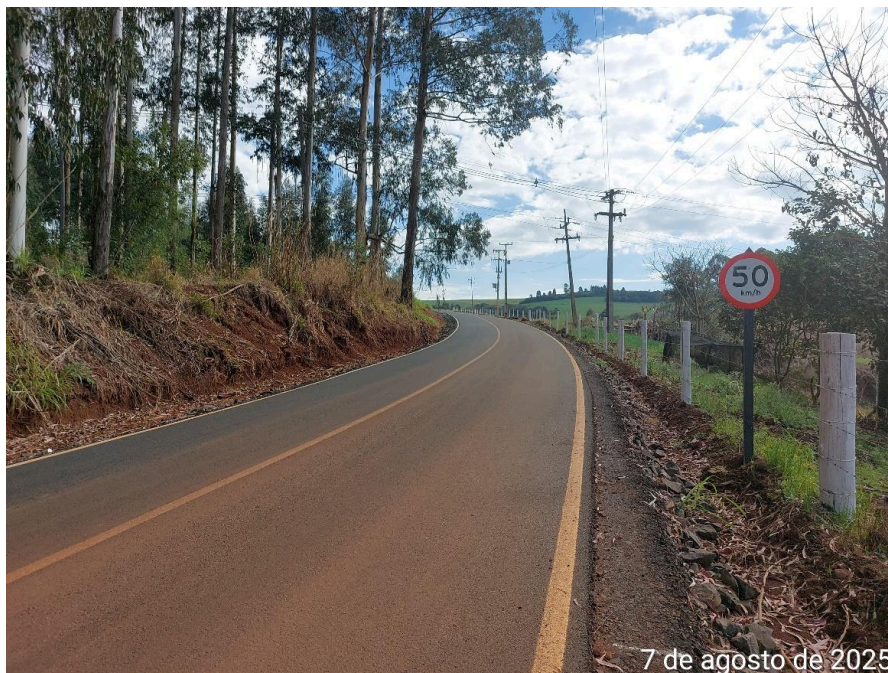
Foto 04. Serviços de pavimentação asfáltica e sinalização viária concluídos.
