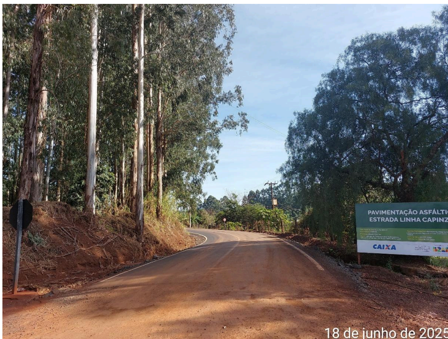
Foto 03. Placa da obra instalada próxima à estaca E1.
