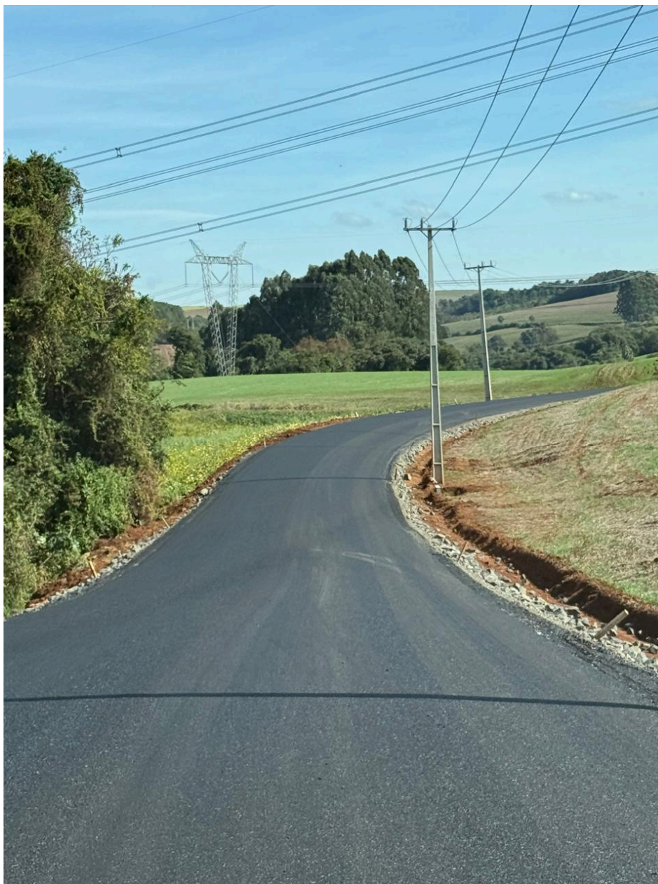
Foto 12. Execução da pavimentação asfáltica.
