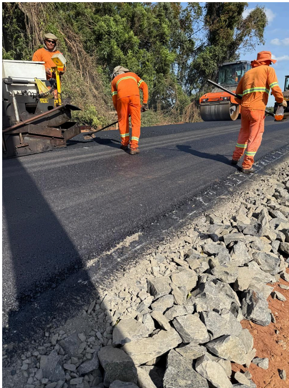
Foto 11. Execução da pavimentação asfáltica.
