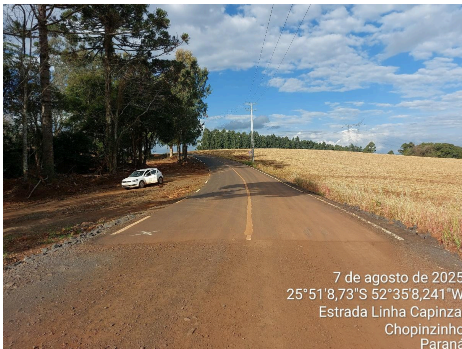
Foto 07. Obra de pavimentação asfáltica concluída – final do trecho.
