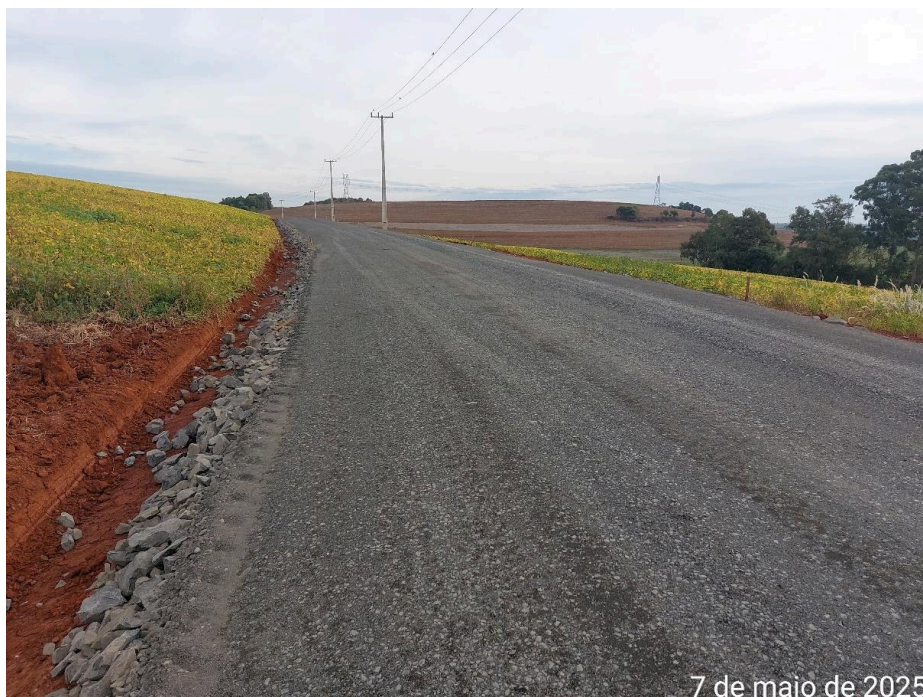
Foto 09. Execução da base em brita graduada.
