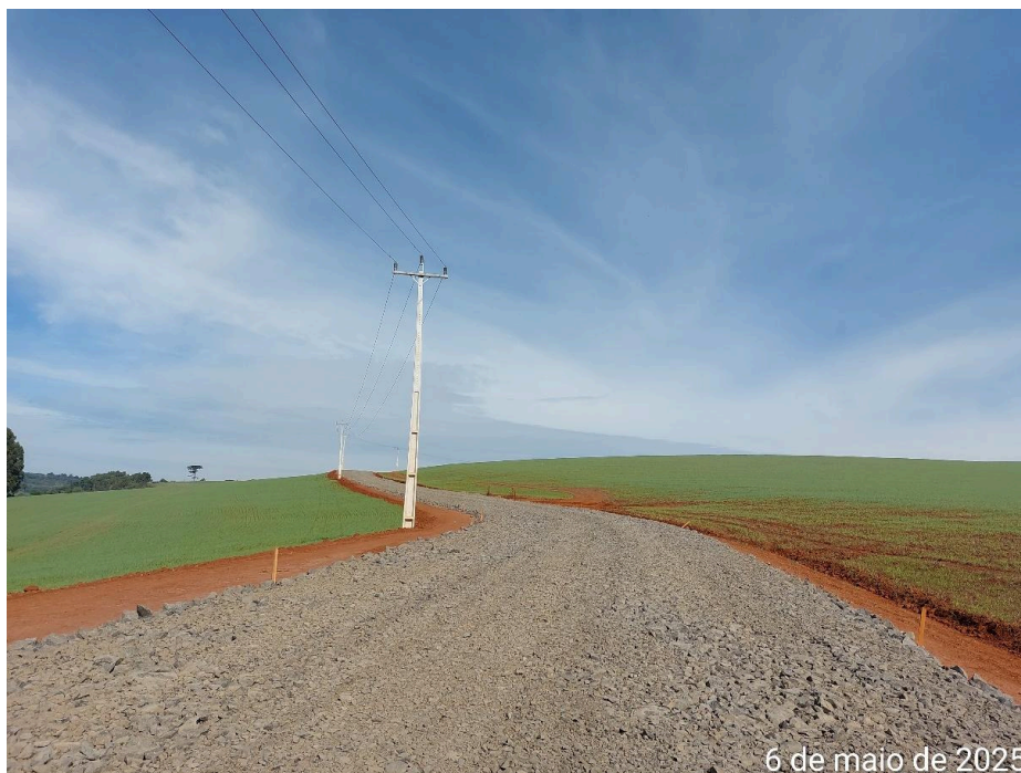
Foto 07. Execução da sub-base em macadame seco.
