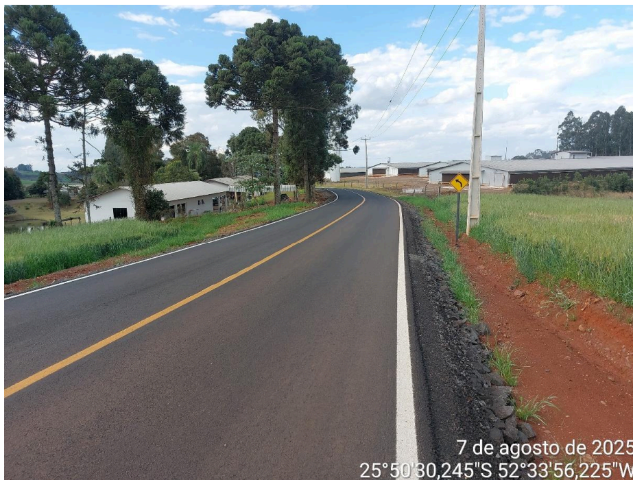
Foto 06. Serviços de pavimentação asfáltica e sinalização viária concluídos.
