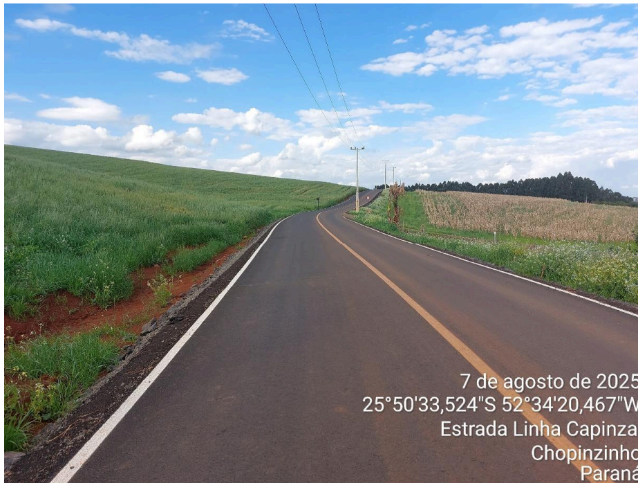
Foto 10. Serviços de pavimentação asfáltica e sinalização viária concluídos.
