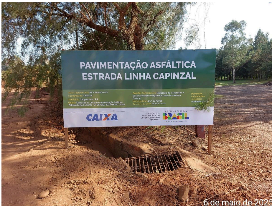
Foto 01. Placa da obra instalada próxima à estaca E1 no início da obra.
