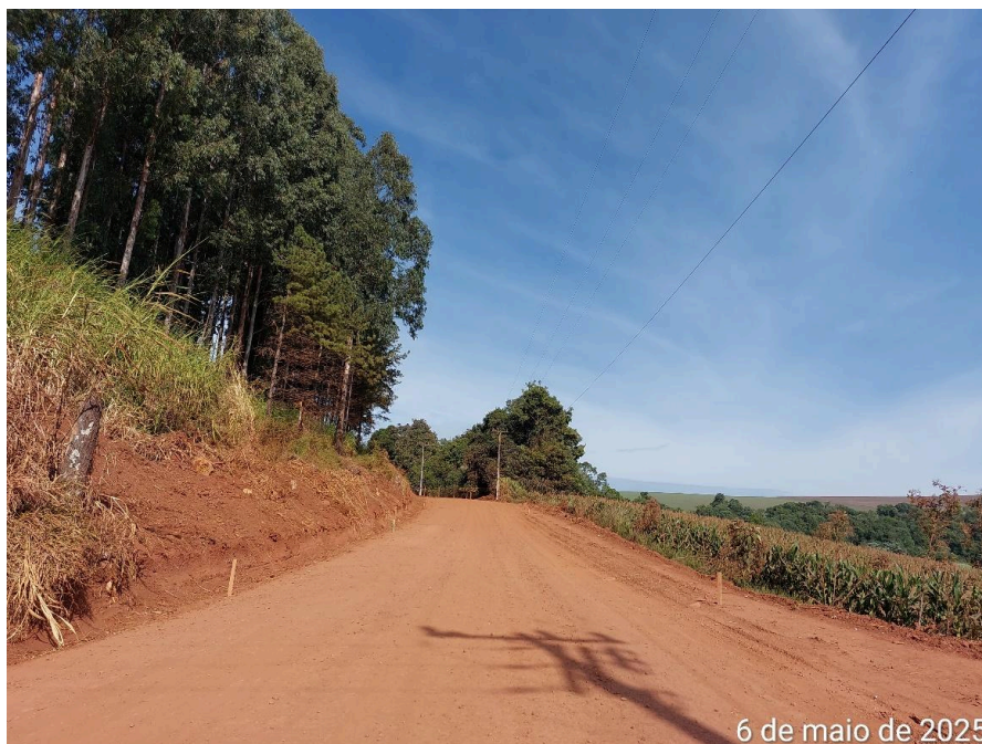
Foto 05. Execução da terraplanagem.
