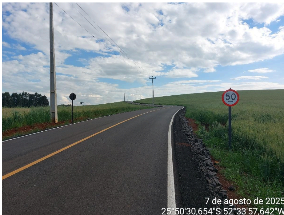
Foto 07. Serviços de pavimentação asfáltica e sinalização viária concluídos.
