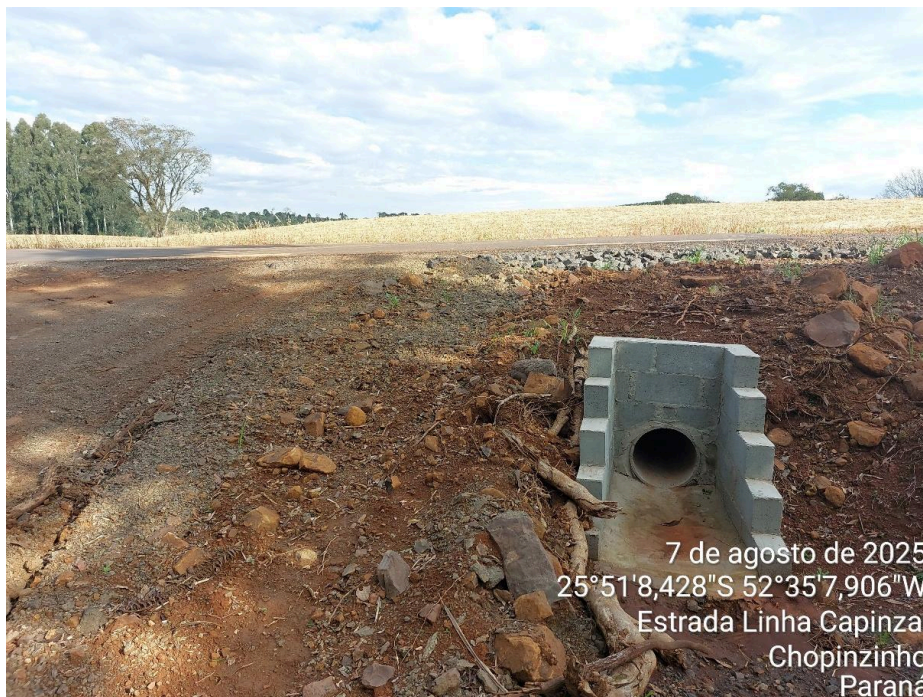
Foto 16. Serviços de drenagem concluídos.
