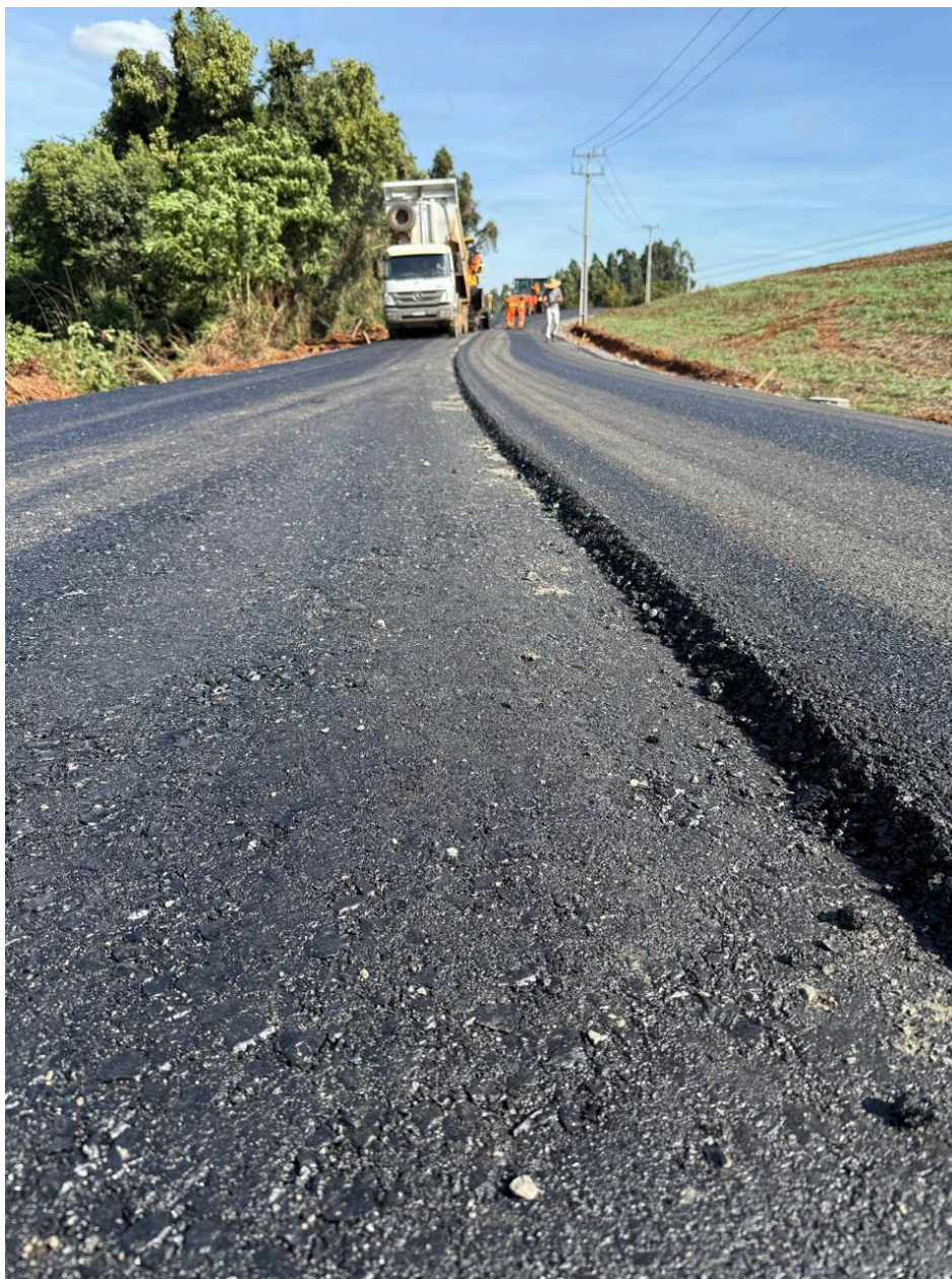
Foto 10. Execução da pavimentação asfáltica.
