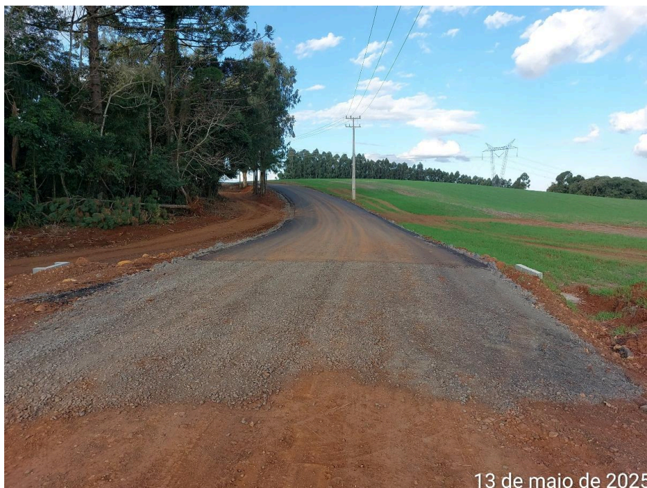
Foto 14. Execução da pavimentação asfáltica – final do trecho.
