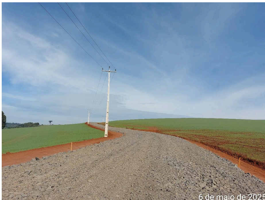
Foto 07. Execução da sub-base em macadame seco.
