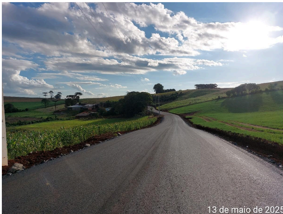
Foto 13. Execução da pavimentação asfáltica.
