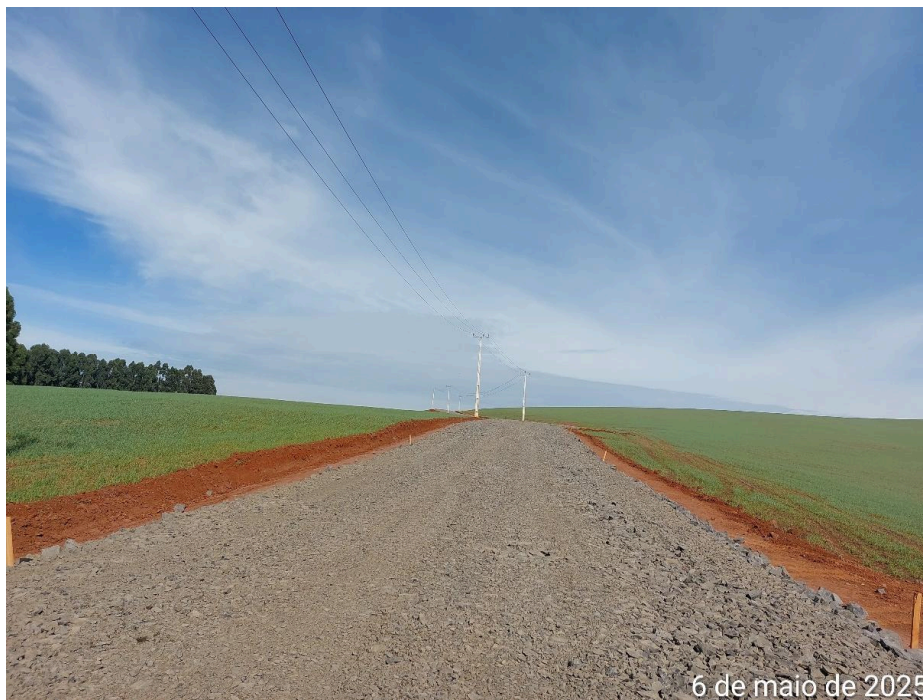
Foto 06. Execução da sub-base em macadame seco.
