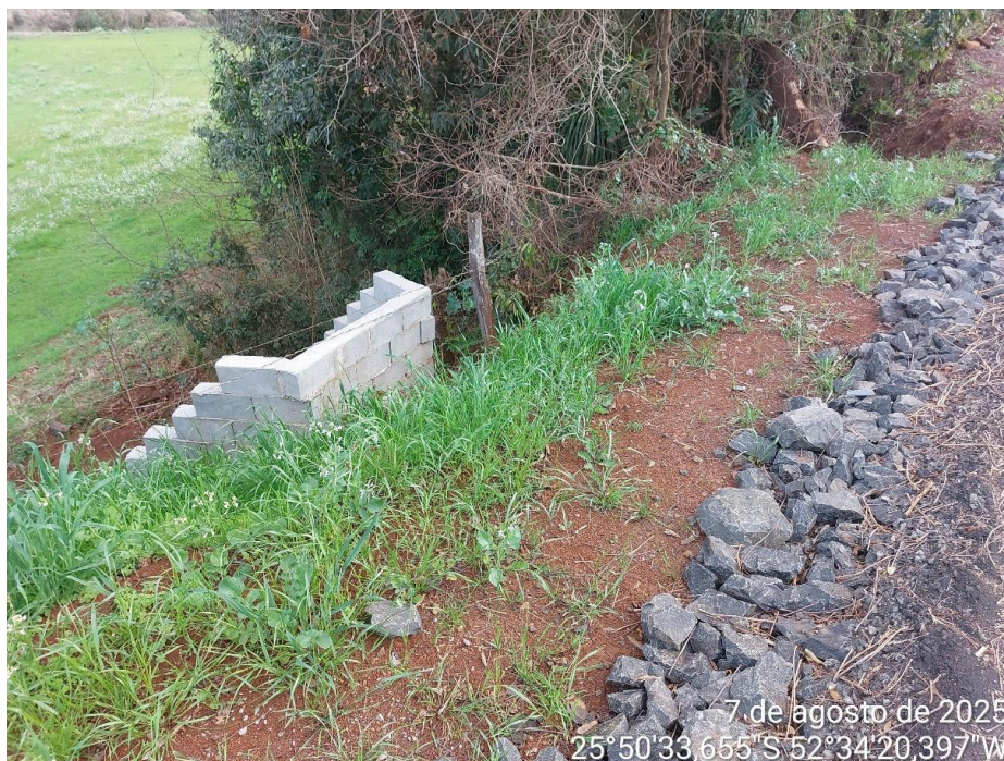
Foto 11. Serviços de drenagem concluídos.
