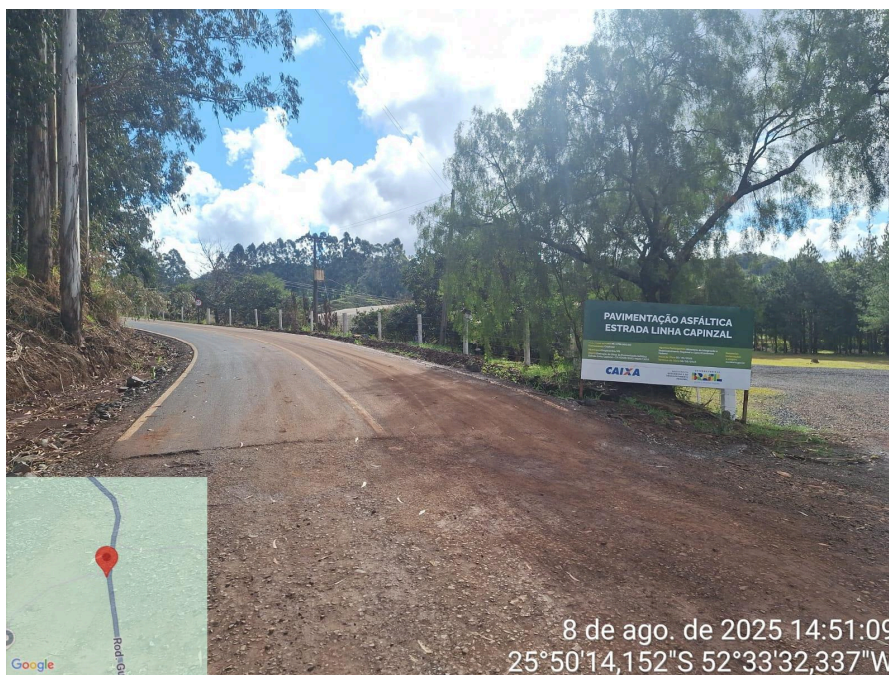
Foto 03. Obra de pavimentação asfáltica concluída – início do trecho.
