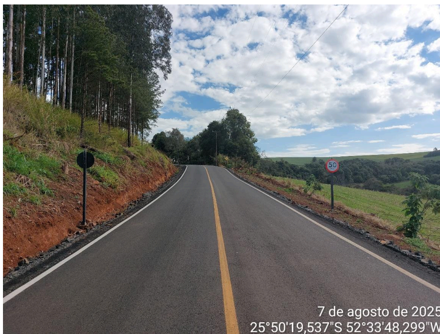
Foto 05. Serviços de pavimentação asfáltica e sinalização viária concluídos.
