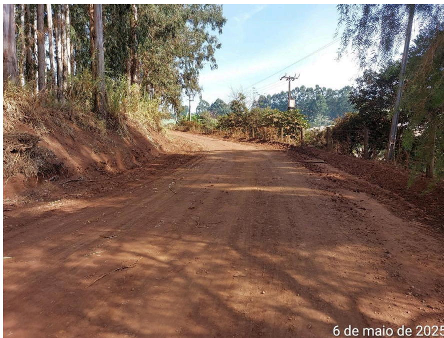
Foto 04. Execução da terraplanagem.
