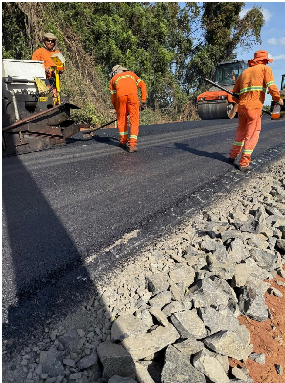
Foto 11. Execução da pavimentação asfáltica.
