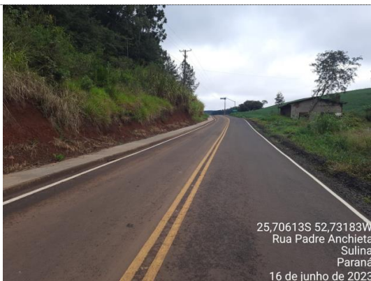
FOTO 07 Fornecimento de emulsão RR-1C - pintura de ligação Medido: 100%
