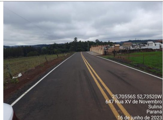
FOTO 12 Faixa de Sinalização Horizontal c/tinta resina acrílica base solvente- (0,034 m2/m2) Medido: 100%
