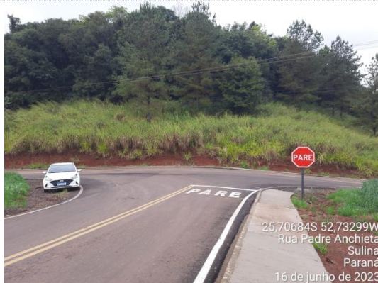
FOTO 09 Meio-Fio com Sarjeta DER - Tipo 2 - (0,042 m3) - Moldado "in loco" Medido: 100%
