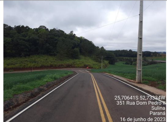
FOTO 10 Sarjeta triangular sem revestimento (Escavação mecânica em material de 1ª categoria na profundidade de até 2m) Medido: 100%
