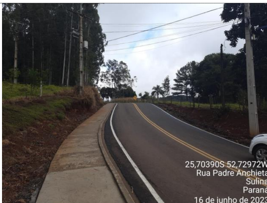
FOTO 03 Desconfinamento Lateral de bordo do Pavimento c/motoniveladora - terreno natural Medido: 100%
