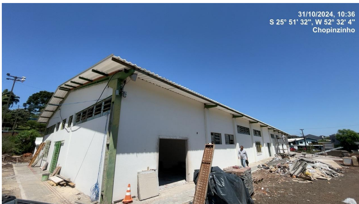
Foto 04 - Pintura externa (textura) finalizada
