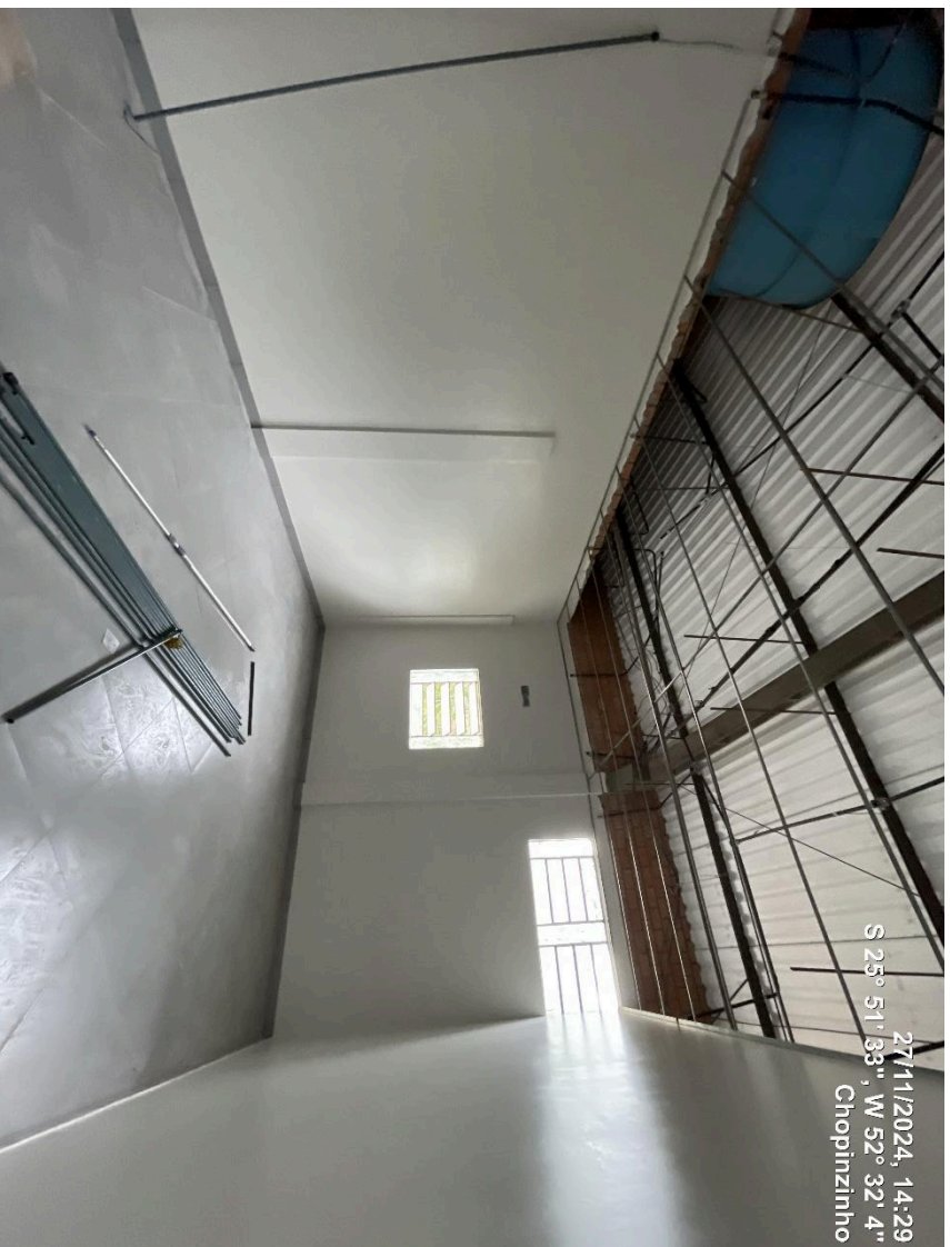
Foto 07 - Sala com pintura finalizada das paredes finalizada;
