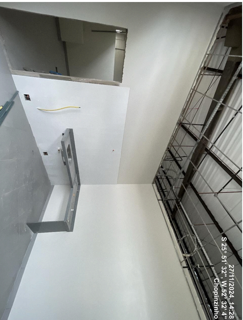
Foto 06 - Pintura finalizada, bancada instalada, cerâmica aplicada (piso e parede), rodapé finalizados.
