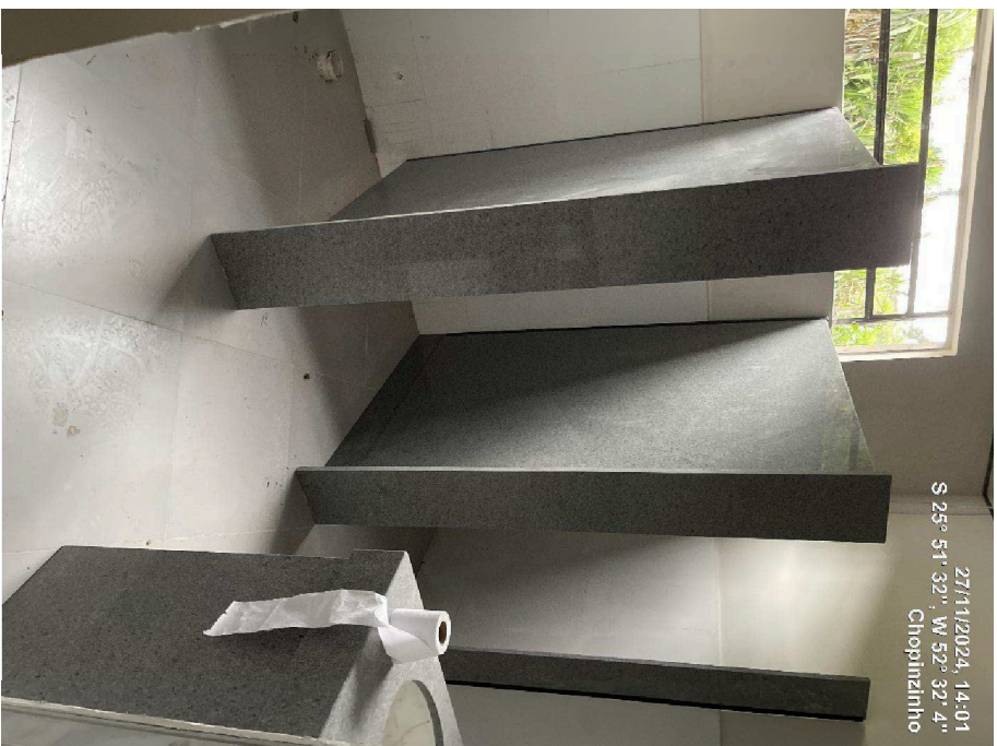
Foto 04 – Divisórias em granito instalada nos banheiros, juntamente com as pias em granito.
