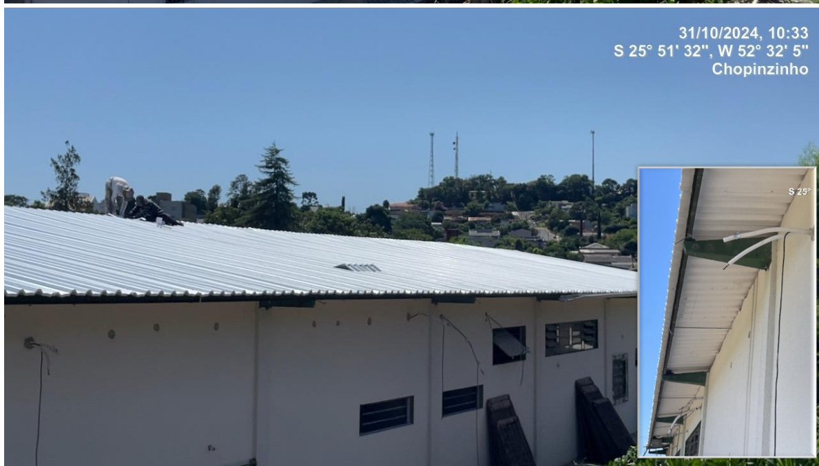
Foto 03 - Cobertura com telha metálica trapezoidal com proteção termoacústica
