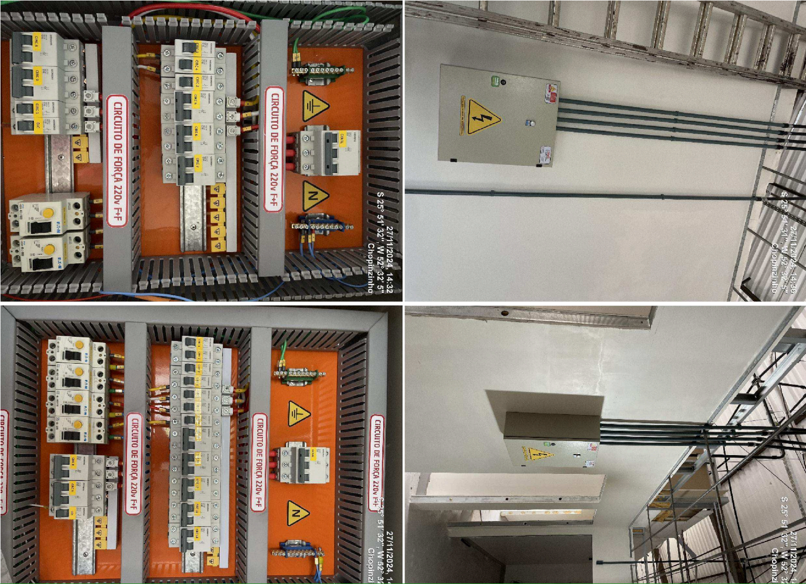
Foto 03 - Quadro de Distribuição de energia, barramentos, disjuntores, DPS e outros.
