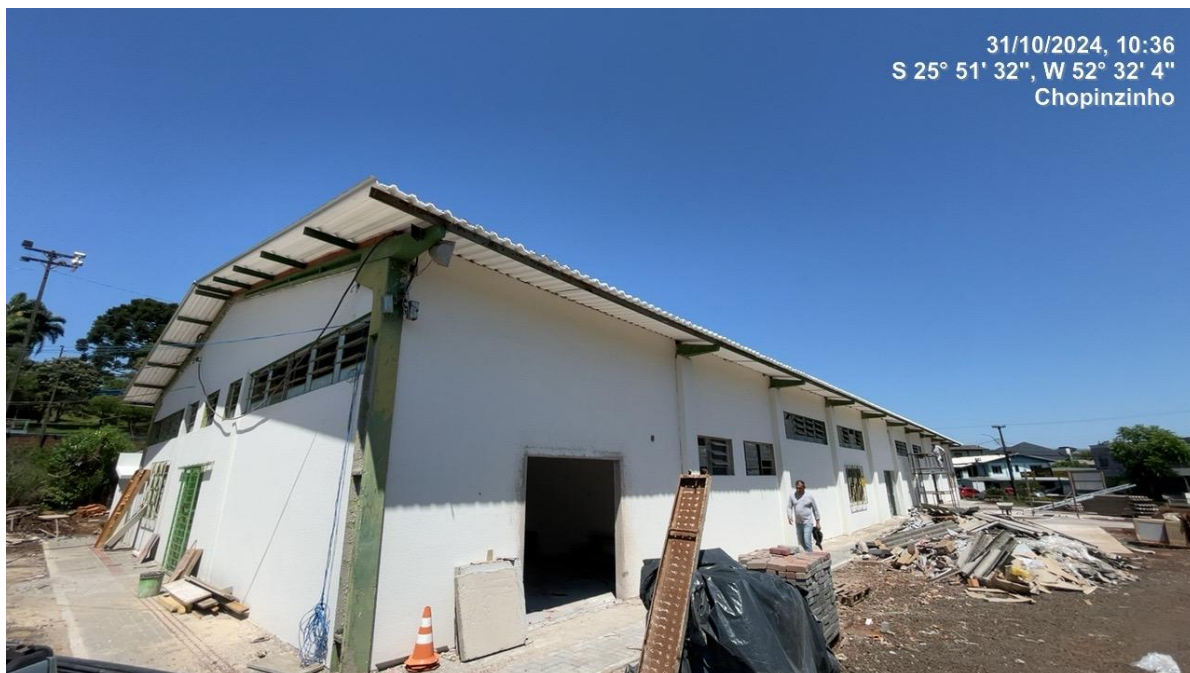
Foto 04 - Pintura externa (textura) finalizada
