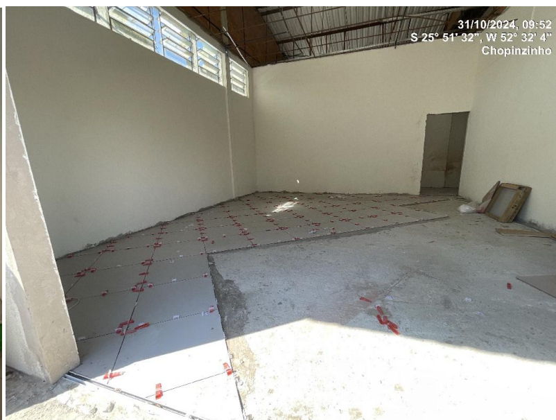
Foto 05 – Cerâmica aplicada no corredor e em aplicação na sala da comunidade.
