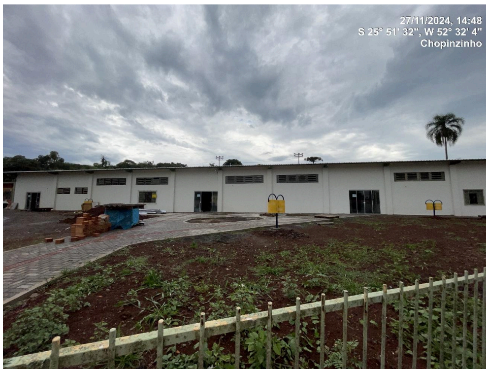
Foto 01 - Face externa totalmente texturada aguardando pintura, lixeiras instaladas.
