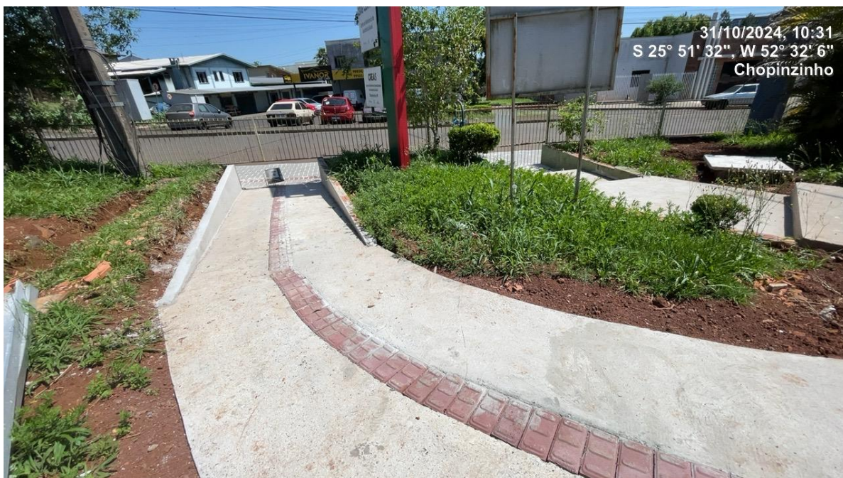
Foto 02 – Rampa de acesso com mureta lateral
