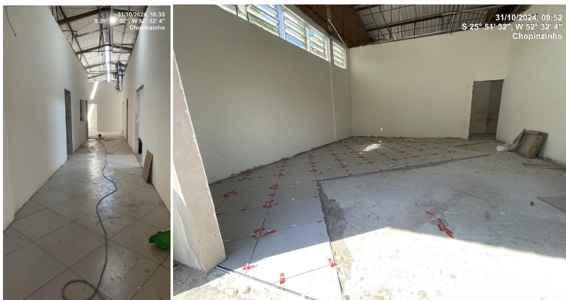
Foto 05 – Cerâmica aplicada no corredor e em aplicação na sala da comunidade.
