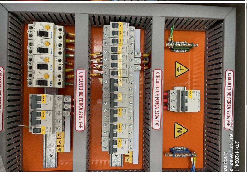
Foto 03 - Quadro de Distribuição de energia, barramentos, disjuntores, DPS e outros.
