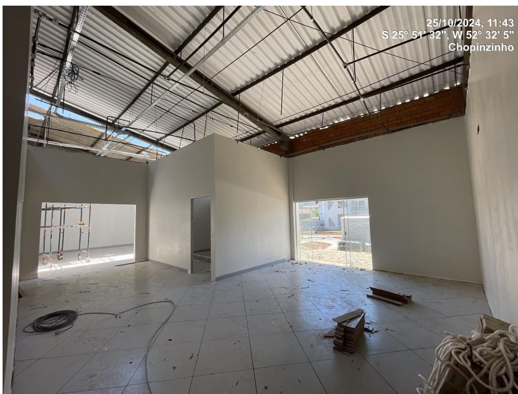
Foto 07 – Pintura de paredes internas;
