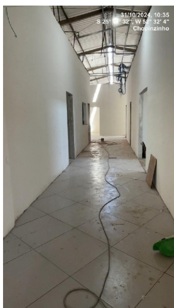
Foto 05 – Cerâmica aplicada no corredor e em aplicação na sala da comunidade.
