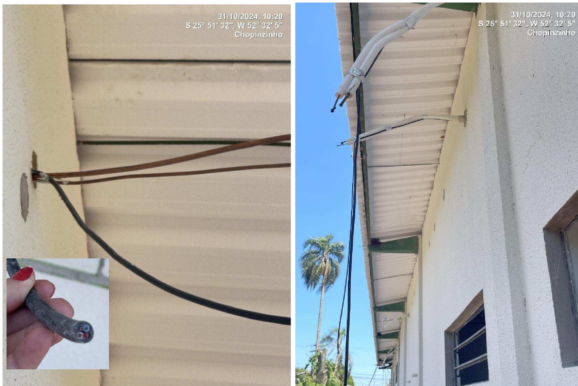
Foto 01 – Instalação da tubulação de ar-condicionado
