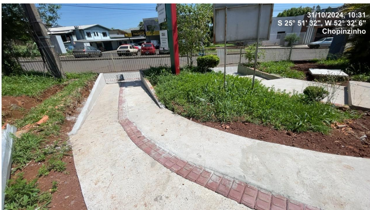
Foto 02 – Rampa de acesso com mureta lateral
