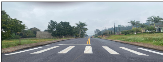
5 | LIMPEZA E LAVAGEM DA PISTA, PINTURA DE LIGAÇÃO, FORNECIMENTO DE EMULSSÃO, FAIXA DE SINALIZAÇÃO E ENSAIOS - RUA PADRE ANCHIETA
