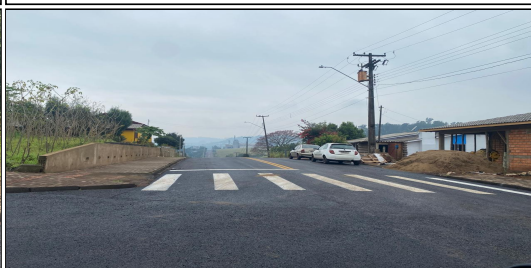
8 | LIMPEZA E LAVAGEM DA PISTA, PINTURA DE LIGAÇÃO, FORNECIMENTO DE EMULSSÃO, FAIXA DE SINALIZAÇÃO E ENSAIOS RUA COMENDADOR ARAÚJO
