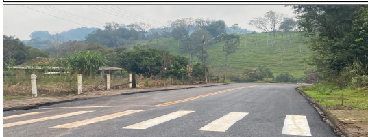
6 | LIMPEZA E LAVAGEM DA PISTA, PINTURA DE LIGAÇÃO, FORNECIMENTO DE EMULSSÃO, FAIXA DE SINALIZAÇÃO E ENSAIOS - RUA PADRE ANCHIETA
