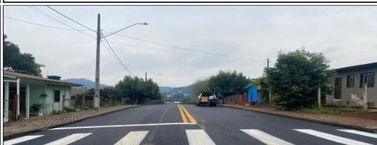
5 | LIMPEZA E LAVAGEM DA PISTA, PINTURA DE LIGAÇÃO, FORNECIMENTO DE EMULSSÃO, FAIXA DE SINALIZAÇÃO E ENSAIOS - RUA PADRE ANCHIETA
