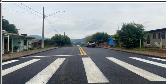
10 | LIMPEZA E LAVAGEM DA PISTA, PINTURA DE LIGAÇÃO, FORNECIMENTO DE EMULSSÃO, FAIXA DE SINALIZAÇÃO E ENSAIOS - RUA VENEZUELA
