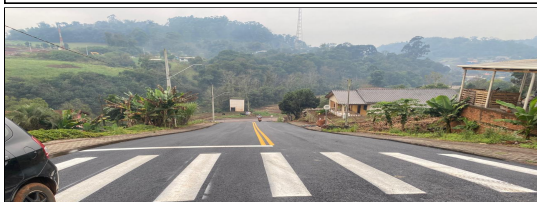
4 | LIMPEZA E LAVAGEM DA PISTA, PINTURA DE LIGAÇÃO, FORNECIMENTO DE EMULSSÃO, FAIXA DE SINALIZAÇÃO E ENSAIOS - RUA PADRE ANCHIETA
