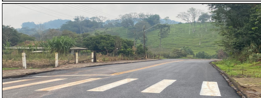
6 | LIMPEZA E LAVAGEM DA PISTA, PINTURA DE LIGAÇÃO, FORNECIMENTO DE EMULSSÃO, FAIXA DE SINALIZAÇÃO E ENSAIOS - RUA PADRE ANCHIETA
