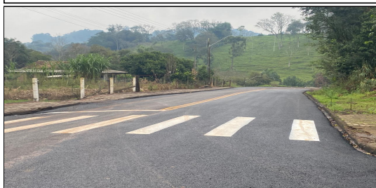
7 | LIMPEZA E LAVAGEM DA PISTA, PINTURA DE LIGAÇÃO, FORNECIMENTO DE EMULSSÃO, FAIXA DE SINALIZAÇÃO E ENSAIOS - RUA COMENDADOR ARAÚJO
