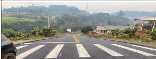
4 | LIMPEZA E LAVAGEM DA PISTA, PINTURA DE LIGAÇÃO, FORNECIMENTO DE EMULSSÃO, FAIXA DE SINALIZAÇÃO E ENSAIOS - RUA PADRE ANCHIETA
