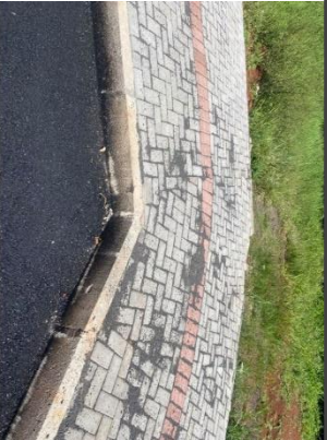
LAT -25.856100790769647; LONG -52.5405765100254 pavimentação
