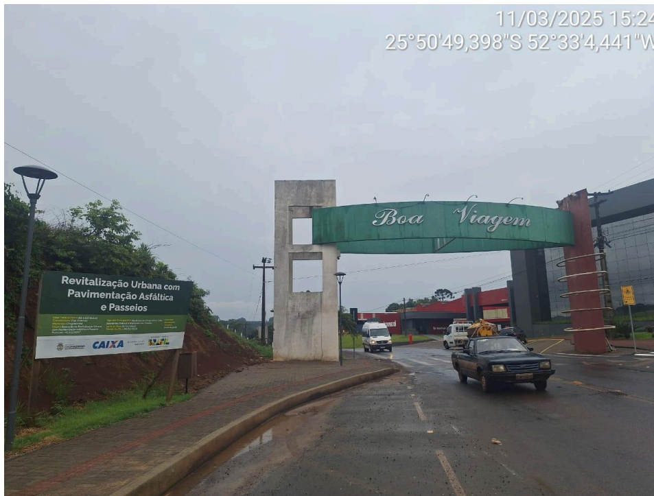
Foto 01 – Placa da Obra instalada – Vista 01
