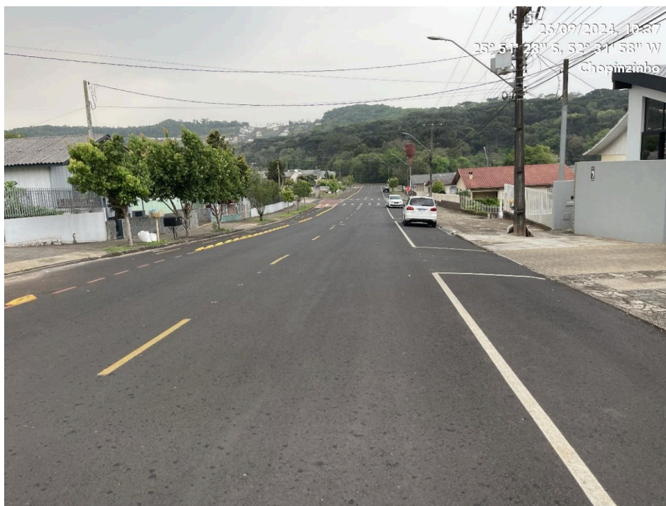
Rua Foto 05 - Presidente Dutra, entre as ruas Frei Everaldo e esquina com Pedro Ivo.
