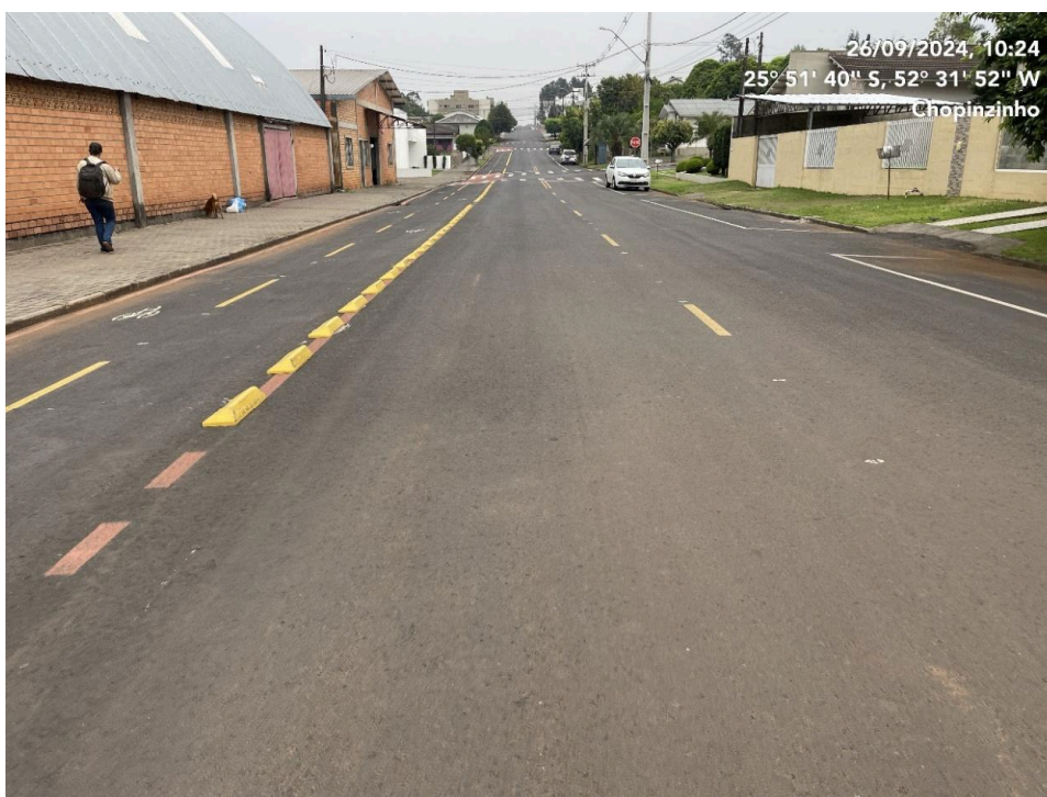
Foto 14 - Rua Sete de Setembro, entre as ruas Guilherme Bocalon e Tiradentes
