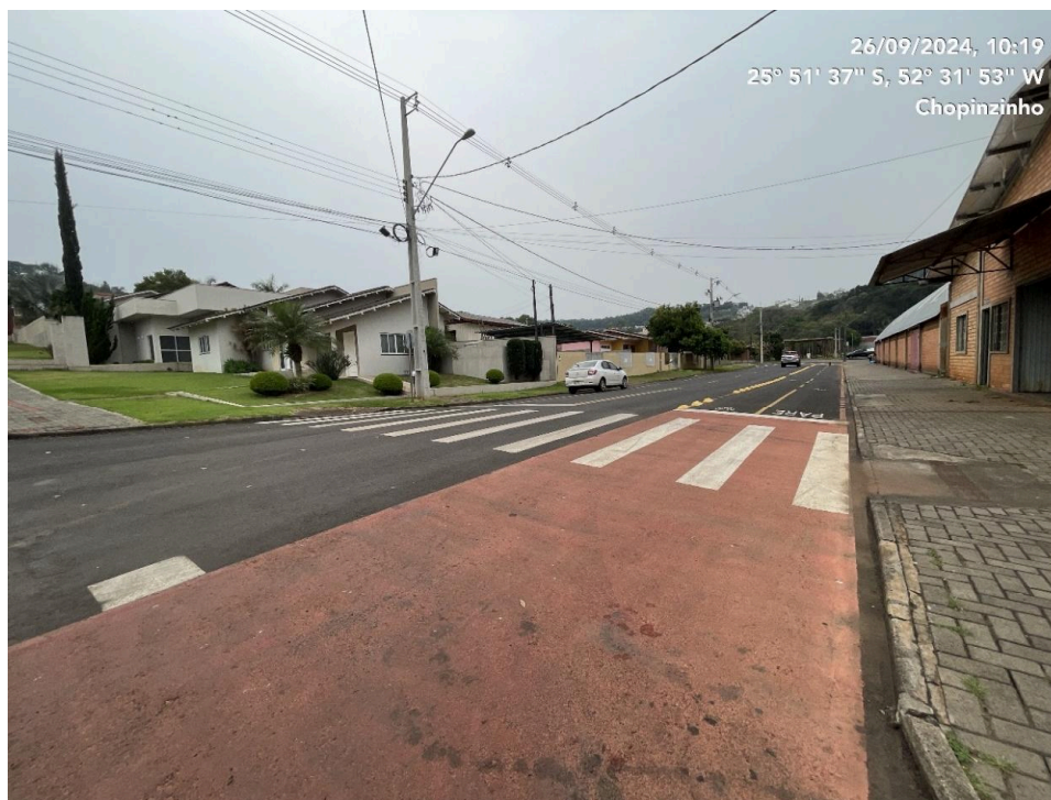
Foto 11 - Rua Sete de Setembro, entre as ruas Guilherme Bocalon e Tiradentes
