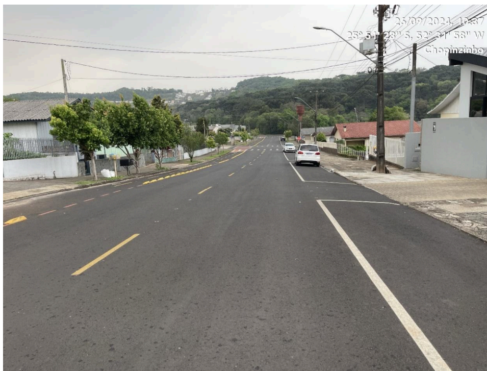
Rua Foto 07 - Presidente Dutra, entre as ruas Frei Everaldo e esquina com Pedro Ivo.
