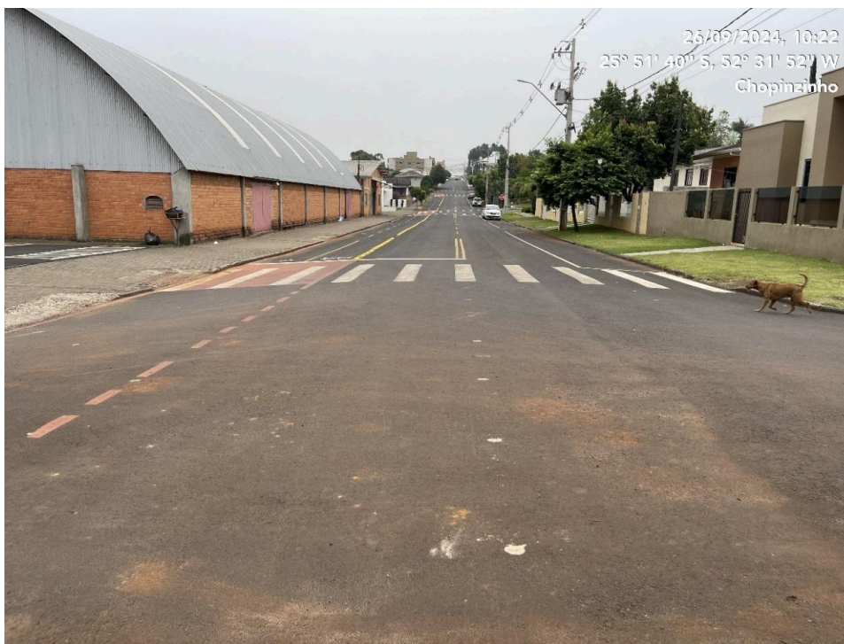
Foto 13 - Rua Sete de Setembro, entre as ruas Guilherme Bocalon e Tiradentes
