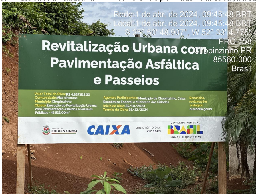
Foto 04 – Placa da obra instalada na Av. XV de Novembro próxima ao Portal saída para Cascavel.
