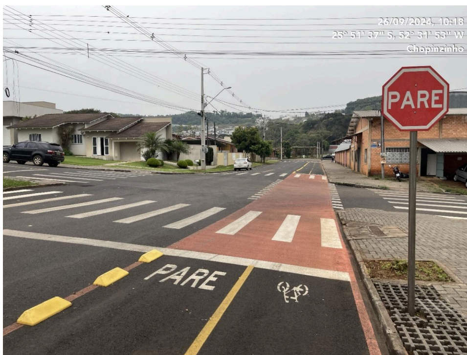
Foto 12 - Rua Sete de Setembro, entre as ruas Guilherme Bocalon e Tiradentes
