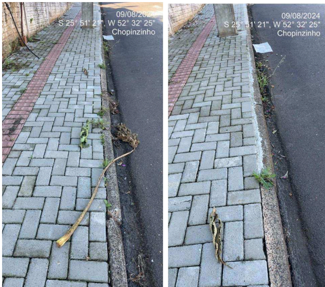
Figura 32 – Na R. São Paulo as calçadas executadas em piso intertravado apresentaram baixa qualidade executiva; (acabamento ruim, tátil com aplicação incorreta em alguns pontos, não execução de uma parte)
