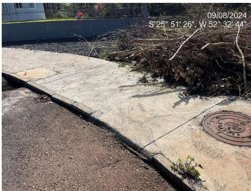
Figura 24 – Meio-fio executado com concreto da calçada; calçada com acabamento de baixa qualidade; meios-fios desalinhados.
