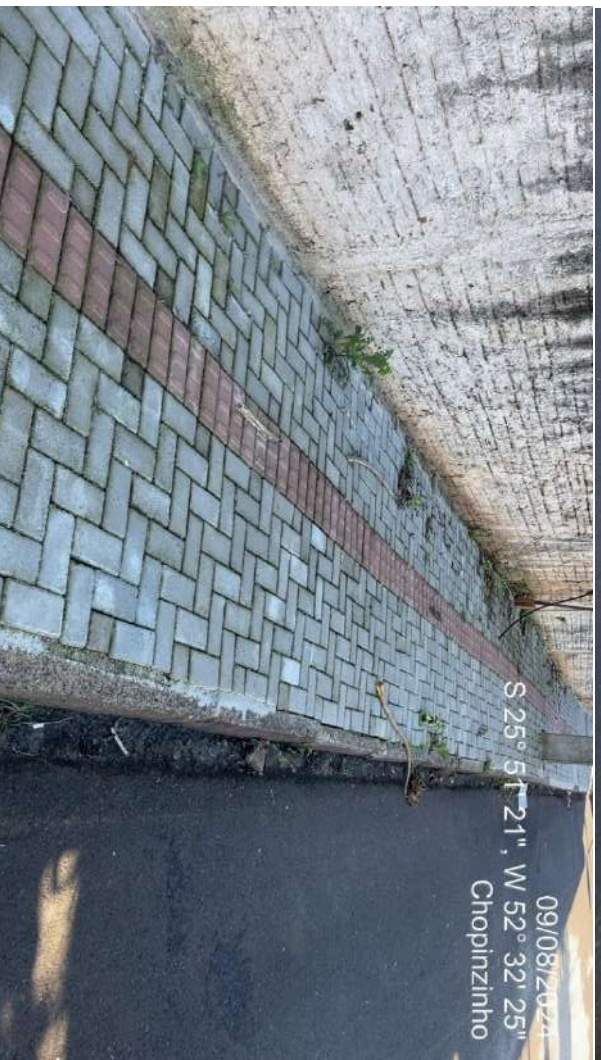
Figura 31 – Na R. São Paulo as calçadas executadas em piso intertravado apresentaram baixa qualidade executiva;
