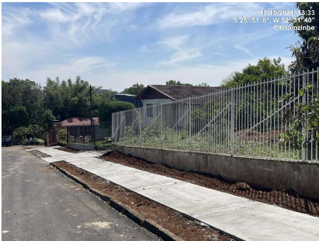
Figura 26 – Calçada de concreto executada na R. Miguel Procópio Kurpel
