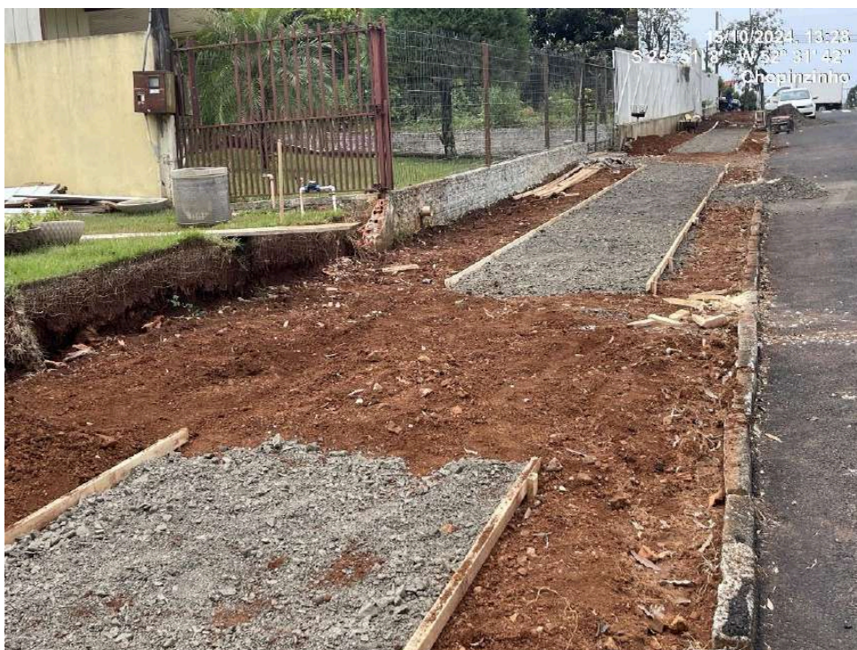
Figura 25 – Na R. Miguel Procópio Kurpel havia previsão de substituição do Meio-fio existente, entretanto como neste caso o concreto ficaria afastado do mesmo e como o pavimento já havia sido executado sem a troca de meio-fio, glosou-se da planilha orçamentária.
