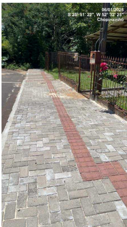
Figura 29 – Calçadas em piso intertravado na R. Paraná apresentaram baixa qualidade executiva; Contratada fez ajustes no acabamento do meio fio e melhorou o travamento das peças.
