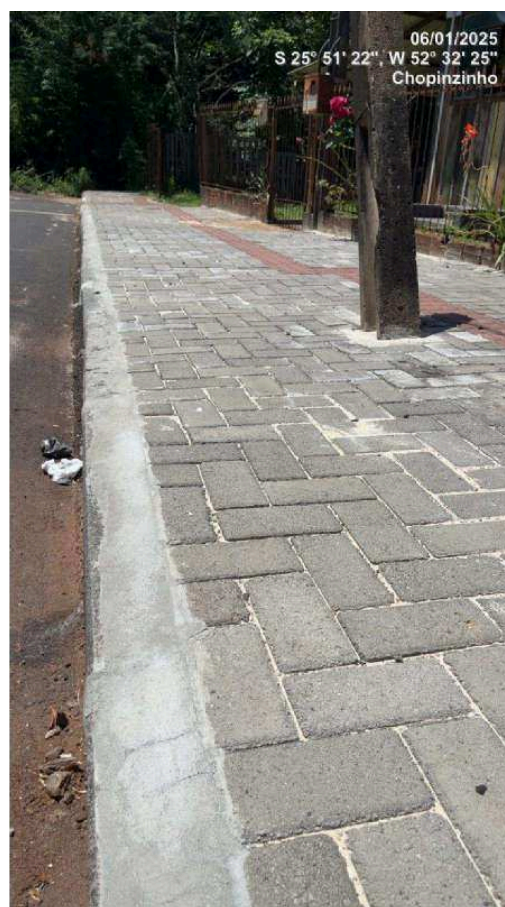
Figura 29 – Calçadas em piso intertravado na R. Paraná apresentaram baixa qualidade executiva; Contratada fez ajustes no acabamento do meio fio e melhorou o travamento das peças.
