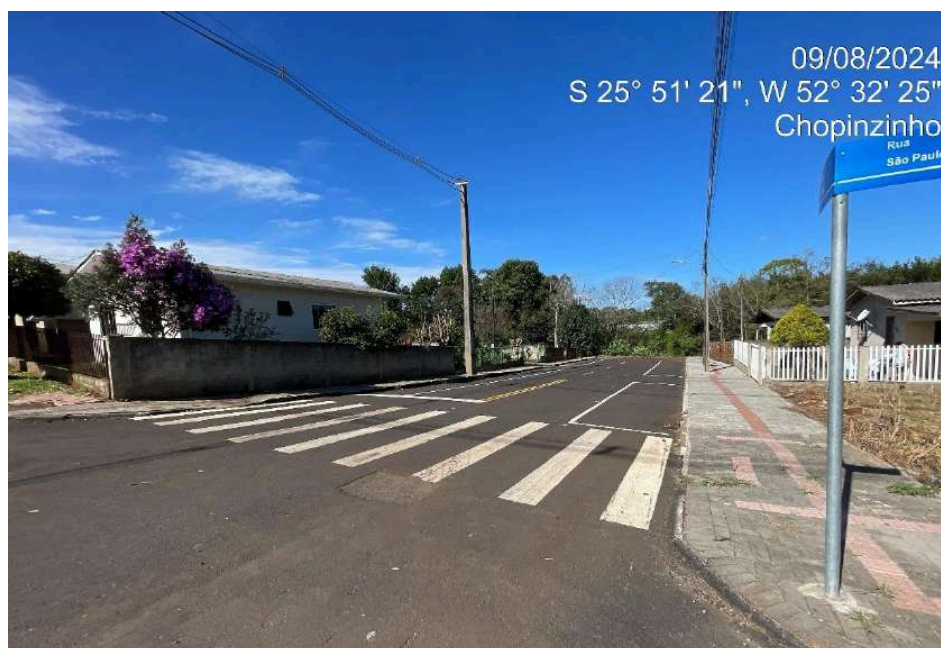
Figura 28 – Na R. Paraná não foram instalados meio-fios novos e as calçadas apresentaram baixa qualidade executiva;
