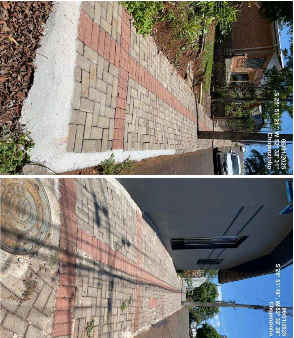
Figura 36 – Calçadas em piso intertravado na R. Brasília – Trecho 03 apresentaram baixa qualidade executiva;
