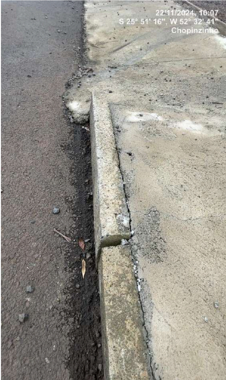
Foto 07 – Meio-fio instalada no Rua Bráulio Sauer
