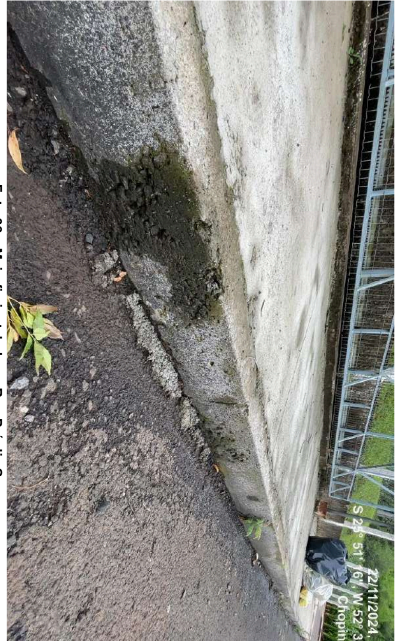
Foto 06 – Meio-fio instalada no Rua Bráulio Sauer
