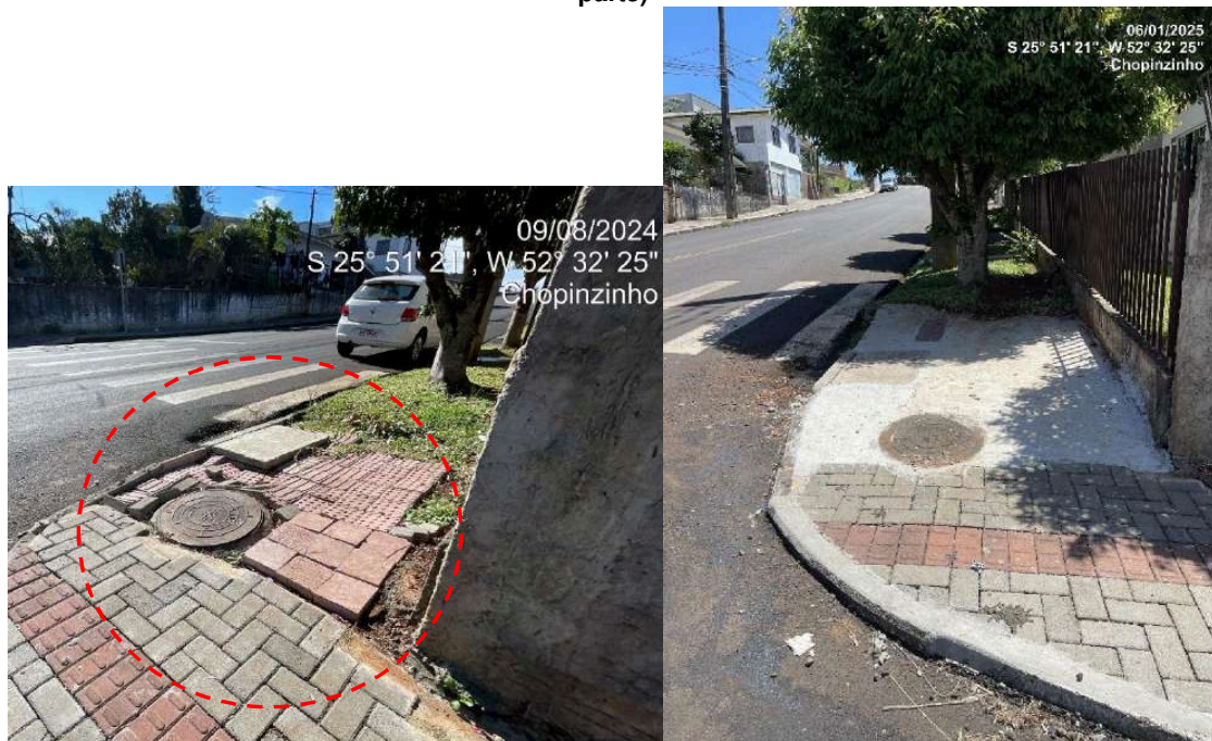
Figura 33 – Rampa em concreto não executada até 09/08 na Rua São Paulo; Finalizada em 06/01/25.
