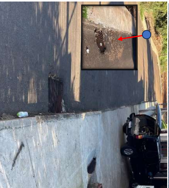
Foto 15 – Bocas de Lobo da Rua Armin Matte a ser refeitas/relocadas (4 unidades), não executar
