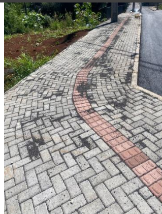
LAT -25.856100760676647, LONG -52.5405765100254 curva acesso Rua São Paulo
