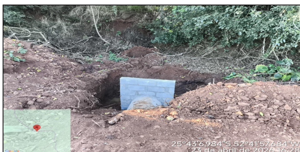
12 | SERVIÇO EXECUTADO DE ESCAVAÇÃO DE BUEIRO, REMOÇÃO DE BUEIRO 0,40M, REATERRO E APILOAMENTO MECÂNICO, CORPO DE BSTC Ø 0,60 SEM BERÇO E SEM
