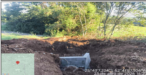
9 | SERVIÇO EXECUTADO DE ESCAVAÇÃO DE BUEIRO, REMOÇÃO DE BUEIRO 0,40M, REATERRO E APILOAMENTO MECÂNICO, CORPO DE BSTC Ø 0,60 SEM BERÇO E SEM
