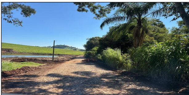
3 | SERVIÇO EXECUTADO DE ESCAVAÇÃO DE BUEIRO, REMOÇÃO DE BUEIRO 0,40M, REATERRO E APILOAMENTO MECÂNICO, CORPO DE BSTC Ø 0,60 SEM BERÇO E SEM
