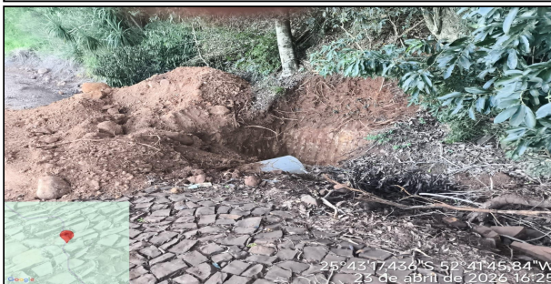
6 | SERVIÇO EXECUTADO DE ESCAVAÇÃO DE BUEIRO, REMOÇÃO DE BUEIRO 0,40M, REATERRO E APILOAMENTO MECÂNICO, CORPO DE BSTC Ø 0,60 SEM BERÇO E SEM
