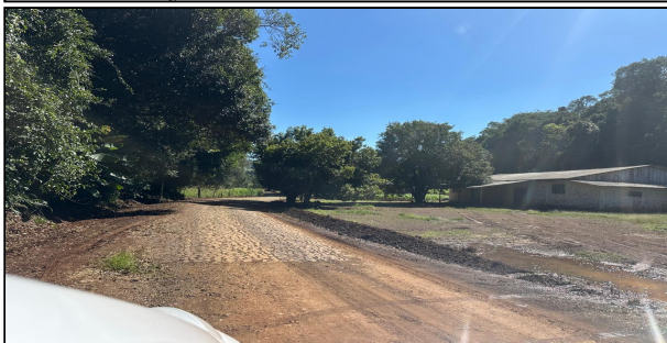
15 | TRECHO FINAL DO PROJETO - ESTRADA DE LINHA SURUBI
