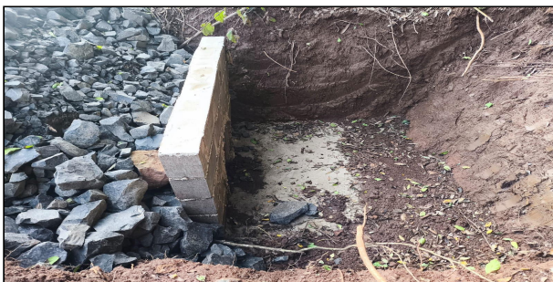
13 | SERVIÇO EXECUTADO DE ESCAVAÇÃO DE BUEIRO, REMOÇÃO DE BUEIRO 0,40M, REATERRO E APILOAMENTO MECÂNICO, CORPO DE BSTC Ø 0,60 SEM BERÇO E SEM
