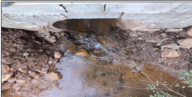
10 | SERVIÇO EXECUTADO DE ESCAVAÇÃO DE BUEIRO, REATERRO E APILOAMENTO MECÂNICO, CORPO DE BSTC Ø 1,00 SEM BERÇO C/ ARMAÇÃO SÍMPLES PA-1 - ESTRADA DE
