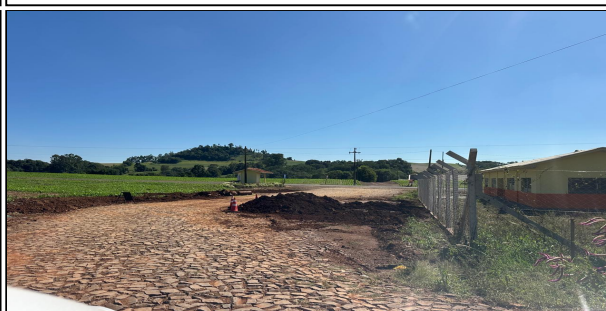
2 | SERVIÇO EXECUTADO DE ESCAVAÇÃO DE BUEIRO, REMOÇÃO DE BUEIRO 0,40M, REATERRO E APIOLAMENTO MECÂNICO, CORPO DE BSTC Ø 0,60 SEM BERÇO E SEM
