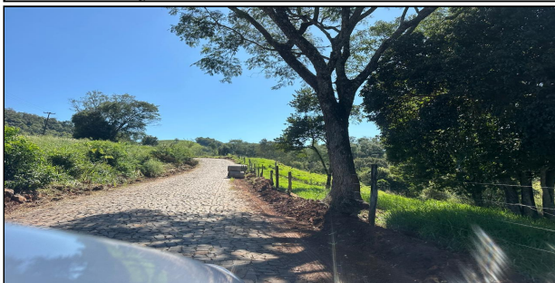
14 | SERVIÇO EXECUTADO DE ESCAVAÇÃO DE BUEIRO, REMOÇÃO DE BUEIRO 0,40M, REATERRO E APILOAMENTO MECÂNICO, CORPO DE BSTC Ø 0,60 SEM BERÇO E SEM
