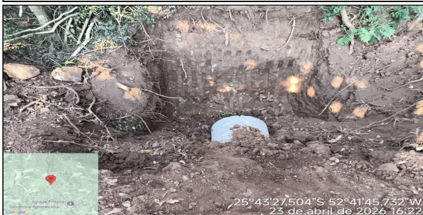
8 | SERVIÇO EXECUTADO DE ESCAVAÇÃO DE BUEIRO, REMOÇÃO DE BUEIRO 0,40M, REATERRO E APILOAMENTO MECÂNICO, CORPO DE BSTC Ø 0,60 SEM BERÇO E SEM
