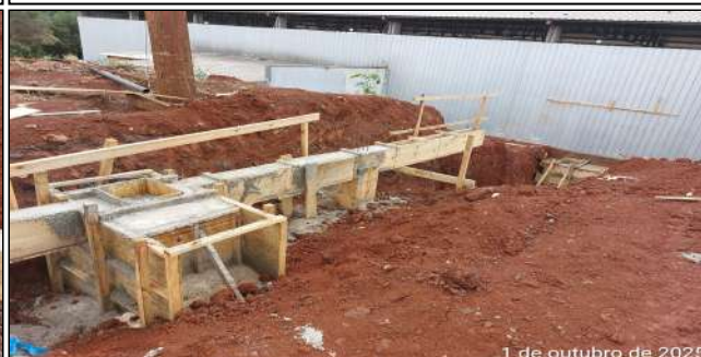
7 | Lateral esquerda: final da concretagem da baldrame
