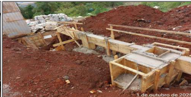
5 | Lateral direita: final da concretagem da baldrame
