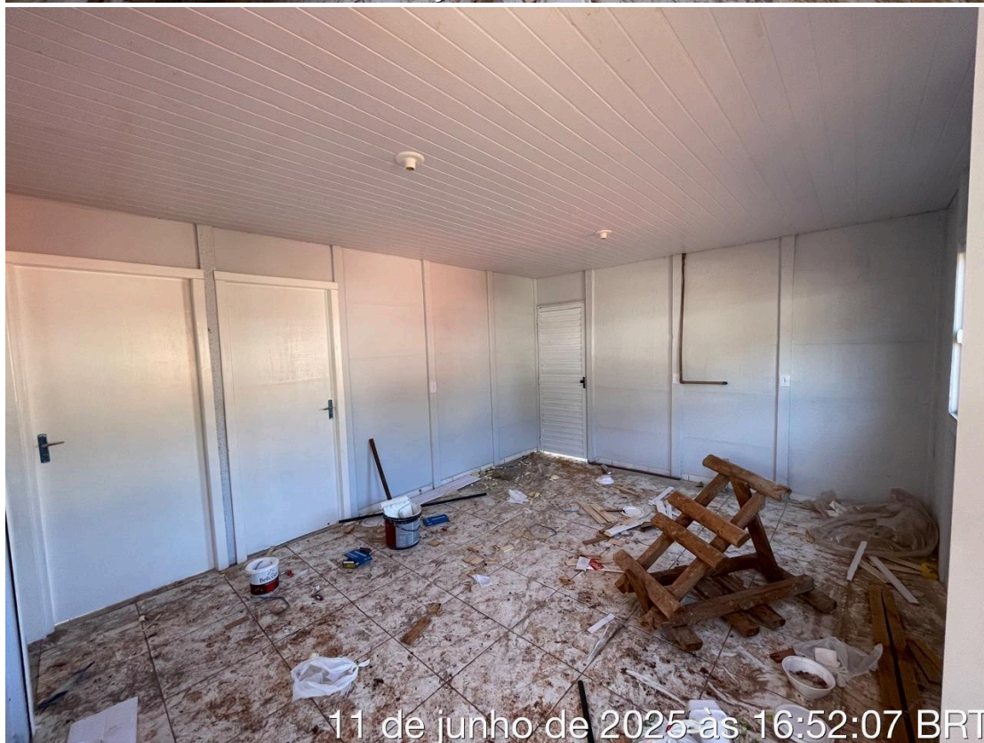
Foto 03 – Paredes e portas de madeira pintadas; Portas e janelas de alumínio instaladas; Forro e acabamentos de elétrica concluídos; (Local 07 - PNE)
