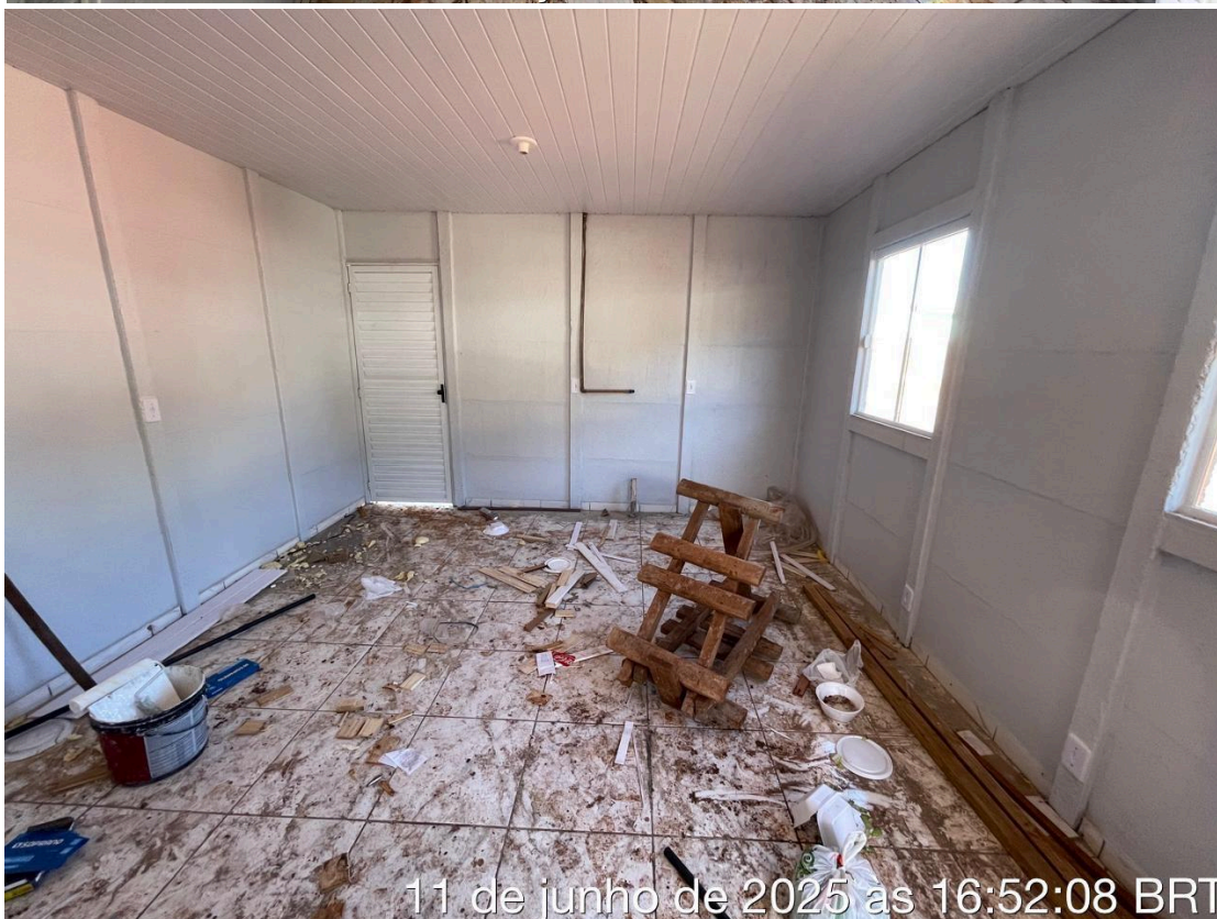
Foto 02 – Paredes e portas de madeira pintadas; Portas e janelas de alumínio instaladas; Forro e acabamentos de elétrica concluídos; (Local 01)
