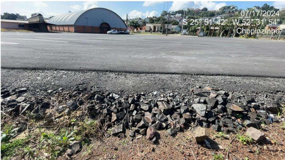
Foto 03 – Material de sub-base/base aparente na borda da pista de estacionamento – R01
