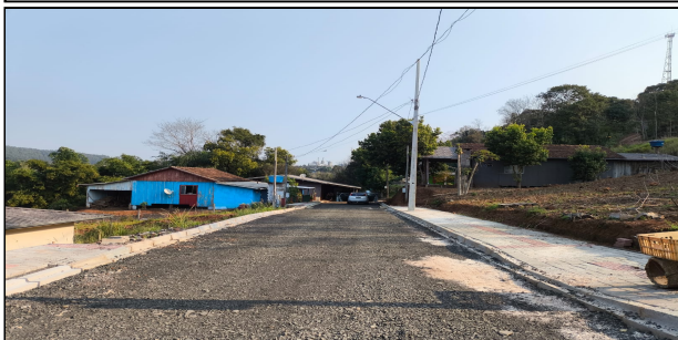
13 | SERVIÇOS EXECUTADOS RAMPA – RUA GUERINO DE OLIVEIRA
