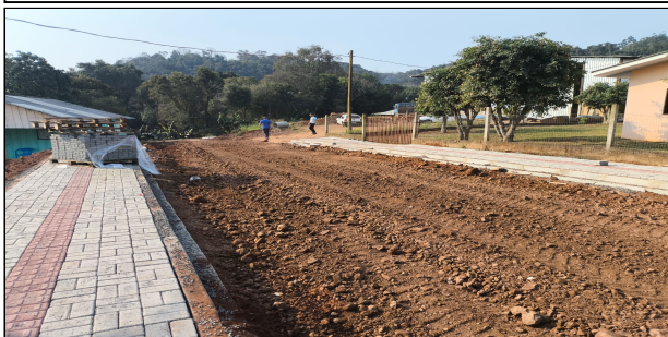
15 | SERVIÇOS EXECUTADOS, MEIO FIO, FINCADINHA, REGULARIZAÇÃO E COMPACTAÇÃO, COLCHÃO DE PÓ DE PEDRA, ATERRO, PAVER, RAMPA E DRENAGEM – RUA
