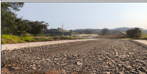
7 | SERVIÇOS EXECUTADOS, MEIO FIO, FINCADINHA, REGULARIZAÇÃO E COMPACTAÇÃO, COLCHÃO DE PÓ DE PEDRA, ATERRO, PAVER E RAMPA – AVELINO RUBI ERHART
