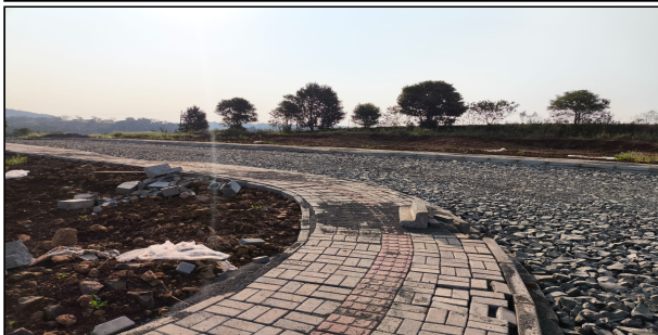
18 | SERVIÇOS EXECUTADOS, MEIO FIO, FINCADINHA, REGULARIZAÇÃO E COMPACTAÇÃO, COLCHÃO DE PÓ DE PEDRA, ATERRO, PAVER E RAMPA – RUA WALTER
