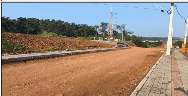
2 | SERVIÇOS EXECUTADOS, MEIO FIO, FINCADINHA, REGULARIZAÇÃO E COMPACTAÇÃO, COLCHÃO DE PÓ DE PEDRA, ATERRO, PAVER E RAMPA – AVENIDA IGUAÇU
