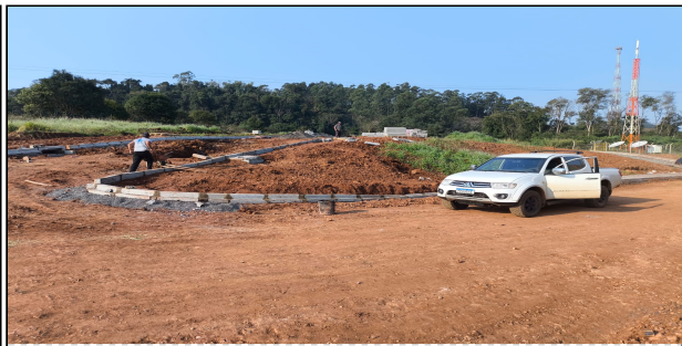
20 | SERVIÇOS EXECUTADOS, MEIO FIO, FINCADINHA, REGULARIZAÇÃO E COMPACTAÇÃO, COLCHÃO DE PÓ DE PEDRA, ATERRO, PAVER E RAMPA – RUA WALTER
