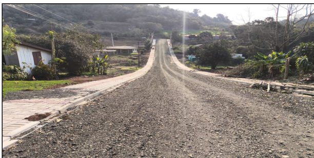
11 | SERVIÇOS EXECUTADOS, MEIO FIO, FINCADINHA, REGULARIZAÇÃO E COMPACTAÇÃO, COLCHÃO DE PÓ DE PEDRA, ATERRO, PAVER E RAMPA – RUA JOSÉ HARRY
