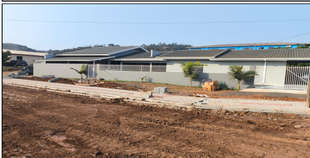
16 | SERVIÇOS EXECUTADOS, MEIO FIO, FINCADINHA, REGULARIZAÇÃO E COMPACTAÇÃO, COLCHÃO DE PÓ DE PEDRA, ATERRO, PAVER, RAMPA E DRENAGEM – RUA
