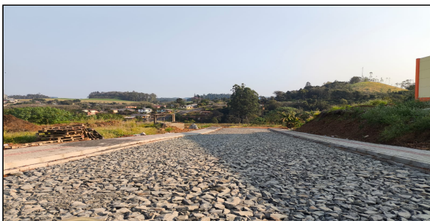
4 | SERVIÇOS EXECUTADOS, MEIO FIO, FINCADINHA, REGULARIZAÇÃO E COMPACTAÇÃO, COLCHÃO DE PÓ DE PEDRA, ATERRO, PAVER E RAMPA – AVELINO RUBI ERHART
