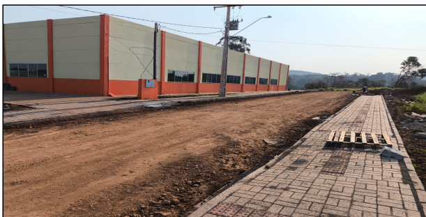
3 | SERVIÇOS EXECUTADOS, MEIO FIO, FINCADINHA, REGULARIZAÇÃO E COMPACTAÇÃO, COLCHÃO DE PÓ DE PEDRA, ATERRO, PAVER E RAMPA – AVENIDA IGUAÇU
