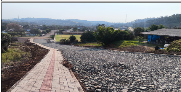
9 | SERVIÇOS EXECUTADOS, MEIO FIO, FINCADINHA, REGULARIZAÇÃO E COMPACTAÇÃO, COLCHÃO DE PÓ DE PEDRA, ATERRO, PAVER, RAMPA E DRENAGEM – RUA DOM
