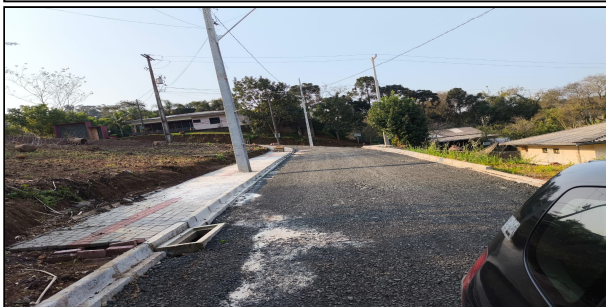
14 | SERVIÇOS EXECUTADOS RAMPA – RUA GUERINO DE OLIVEIRA
