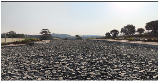
19 | SERVIÇOS EXECUTADOS, MEIO FIO, FINCADINHA, REGULARIZAÇÃO E COMPACTAÇÃO, COLCHÃO DE PÓ DE PEDRA, ATERRO, PAVER E RAMPA – RUA WALTER
