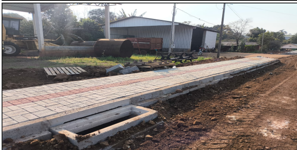
17 | SERVIÇOS EXECUTADOS, MEIO FIO, FINCADINHA, REGULARIZAÇÃO E COMPACTAÇÃO, COLCHÃO DE PÓ DE PEDRA, ATERRO, PAVER, RAMPA E DRENAGEM – RUA
