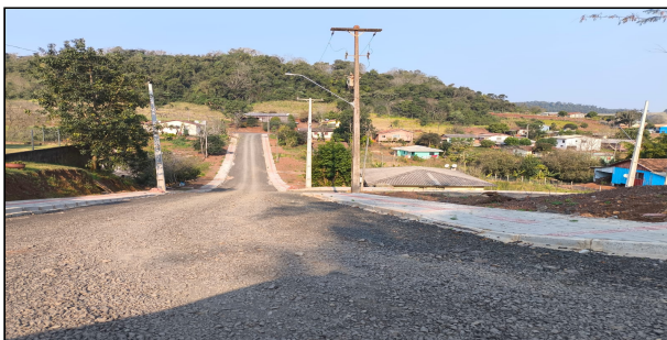
12 | SERVIÇOS EXECUTADOS, MEIO FIO, FINCADINHA, REGULARIZAÇÃO E COMPACTAÇÃO, COLCHÃO DE PÓ DE PEDRA, ATERRO, PAVER E RAMPA – RUA JOSÉ HARRY
