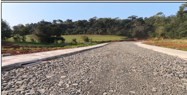
5 | SERVIÇOS EXECUTADOS, MEIO FIO, FINCADINHA, REGULARIZAÇÃO E COMPACTAÇÃO, COLCHÃO DE PÓ DE PEDRA, ATERRO, PAVER E RAMPA – AVELINO RUBI ERHART
