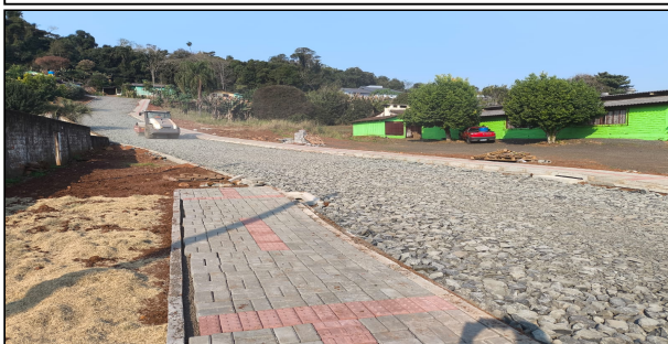
10 | SERVIÇOS EXECUTADOS, MEIO FIO, FINCADINHA, REGULARIZAÇÃO E COMPACTAÇÃO, COLCHÃO DE PÓ DE PEDRA, ATERRO, PAVER, RAMPA E DRENAGEM – RUA DOM
