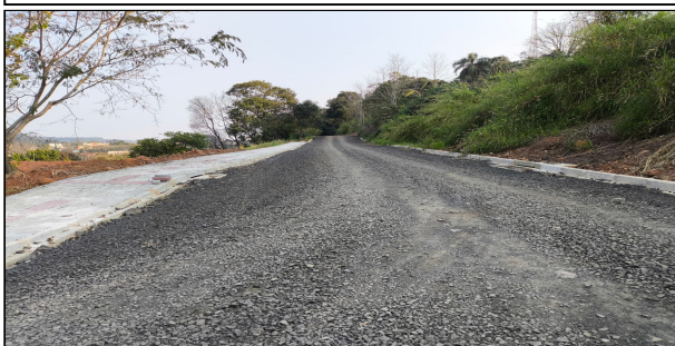
8 | SERVIÇOS EXECUTADOS RAMPA – CASTELO BRANCO
