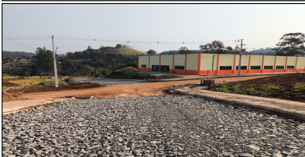
6 | SERVIÇOS EXECUTADOS, MEIO FIO, FINCADINHA, REGULARIZAÇÃO E COMPACTAÇÃO, COLCHÃO DE PÓ DE PEDRA, ATERRO, PAVER E RAMPA – AVELINO RUBI ERHART
