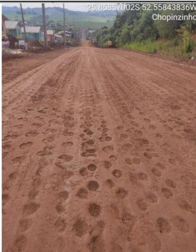
Foto 05 – Regularização e Compactação do Subleito da Rua Joaquim Fávero.
