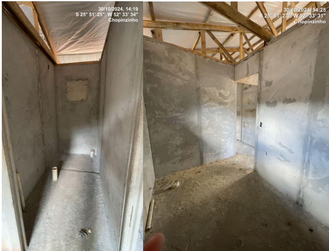
Foto 08 – Emassamento das paredes de banheiros, local 02 e 07.
