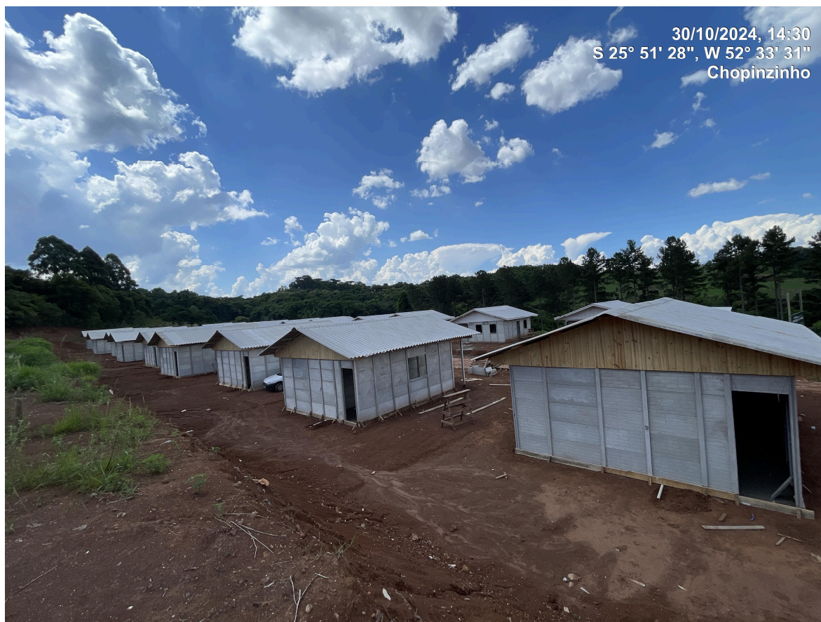
Foto 02 – 10 unidades habitacionais pré-moldadas, construídas e cobertas. (Local 01)
