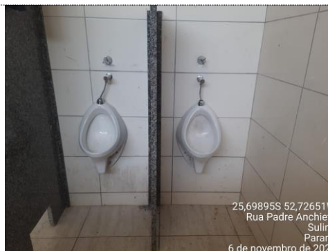
ITEM 9.56: MICTÓRIO SIFONADO LOUÇA BRANCA – PADRÃO MÉDIO – FORNECIMENTO E INSTALAÇÃO. AF_01/2020 MEDIDO: 100%
