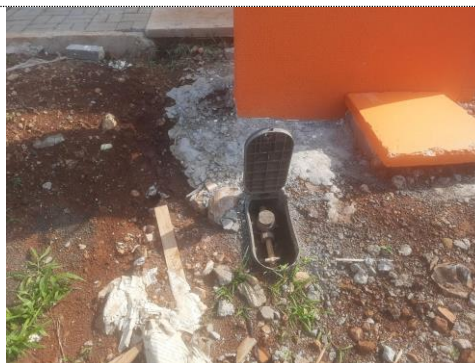
FOTO 20 ITEM 9.6: KIT CAVALETE PARA MEDIÇÃO DE ÁGUA - ENTRADA PRINCIPAL, EM PVC SOLDÁVEL DN 25 (3/4") FORNECIMENTO E INSTALAÇÃO (EXCLUSIVE HIDRÔMETRO). AF_11/2016 MEDIDO: 100%
