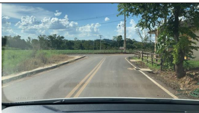
BOCA DE LOBO – PONTO 9
