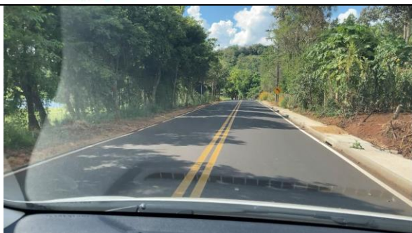
BOCA DE LOBO - PONTO 5
