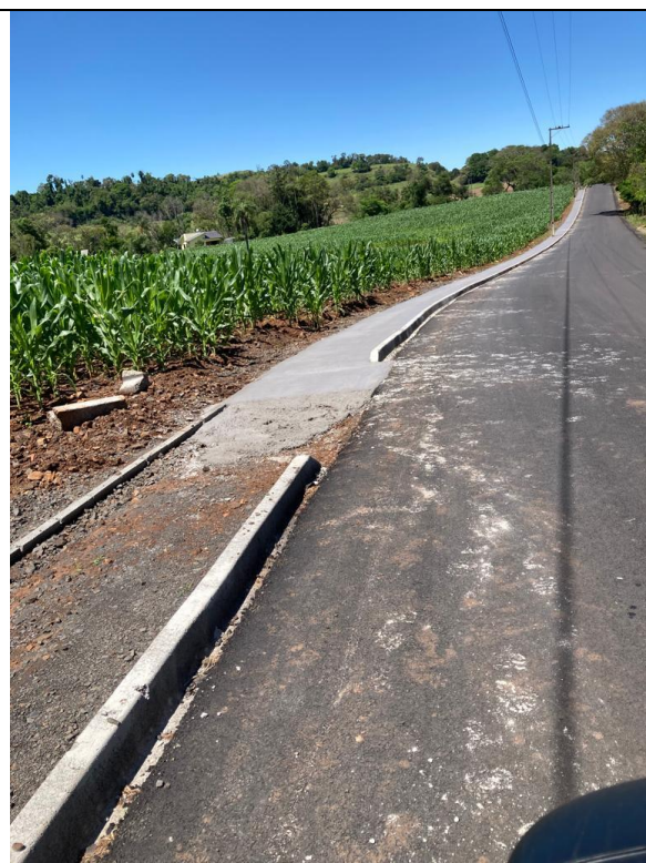
CONCRETAGEM DA CALÇADA E BASE DA CALÇADA E FINCADINHA - PONTO 2 e 3
