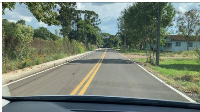
CALÇADA EM CONCRETO – PONTO 12
