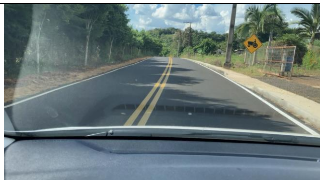
SINALIZAÇÃO DE TRÂNSITO, , SARGETEAMENTO E PLANTIO DE GRAMA - PONTO 4
