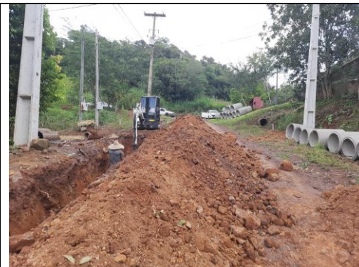
SERVIÇOS EXECUTADOS NA RUA JOSÉ HARRY WILLEMBORG (FOTO 04)
