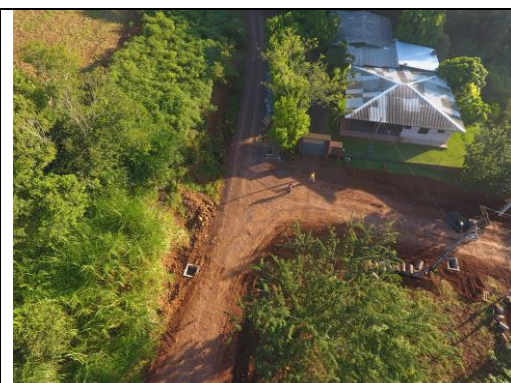
SERVIÇOS EXECUTADOS NA RUA CASTELO BRANCO (FOTO 08)
