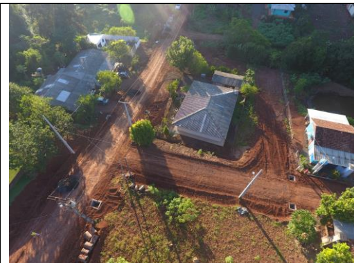
SERVIÇOS EXECUTADOS NA RUA GUERINO DE OLIVEIRA (FOTO 10)
