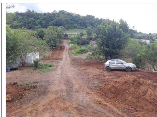
SERVIÇOS EXECUTADOS NA RUA JOSÉ HARRY WILLEMBORG (FOTO 02)
