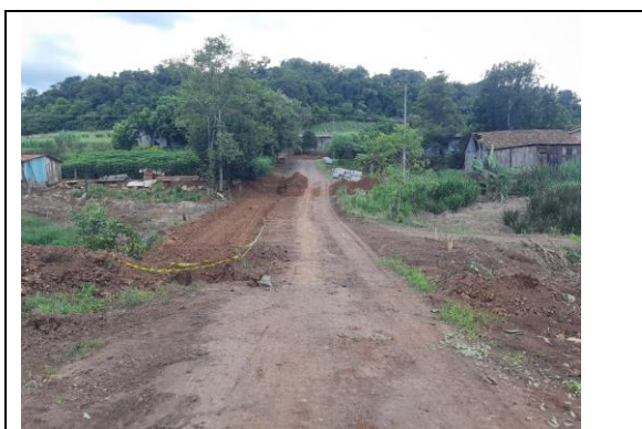
SERVIÇOS EXECUTADOS NA RUA JOSÉ HARRY WILLEMBORG (FOTO 01)
