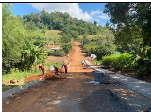
SERVIÇOS EXECUTADOS NA RUA JOSÉ HARRY WILLEMBORG (FOTO 05)
