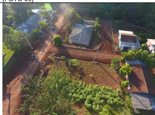
SERVIÇOS EXECUTADOS NA RUA GUERINO DE OLIVEIRA (FOTO 11)
