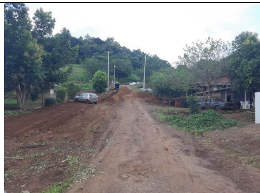
SERVIÇOS EXECUTADOS NA RUA JOSÉ HARRY WILLEMBORG (FOTO 03)
