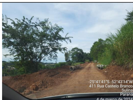
SERVIÇOS EXECUTADOS NA RUA CASTELO BRANCO (FOTO 07)
