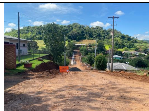
SERVIÇOS EXECUTADOS NA RUA JOSÉ HARRY WILLEMBORG (FOTO 06)
