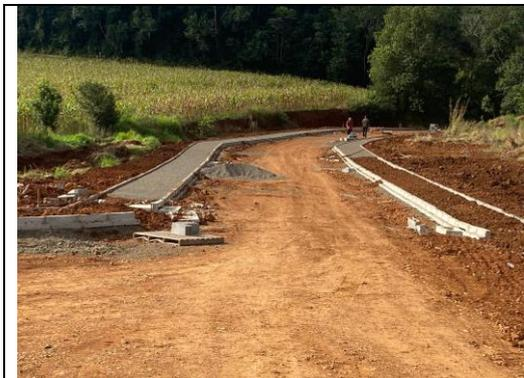
EXECUÇÃO DE COMPACTAÇÃO DE ATERROS 100% P.N, ESCAVAÇÃO, CARGA E TRANSP. 1ª CAT, MEIO-FIO COM SARJETA DER - TIPO 2 - (0,042 M3) - MOLDADO "IN LOCO", FINCADINHA DE CONCRETO - (9X19X39CM-0,0171M3/M), REGULARIZAÇÃO E COMPACTAÇÃO P/ ASSENTAMENTO DE CALÇADAS/LAJOTAS/BLOCOS, COLCHÃO DE PÓ
