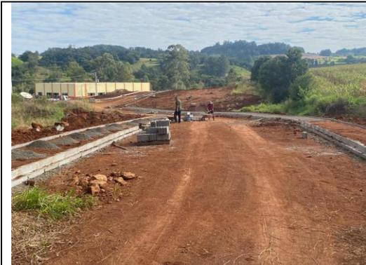
EXECUÇÃO DE COMPACTAÇÃO DE ATERROS 100% P.N, ESCAVAÇÃO, CARGA E TRANSP. 1ª CAT, MEIO-FIO COM SARJETA DER - TIPO 2 - (0,042 M3) - MOLDADO "IN LOCO", FINCADINHA DE CONCRETO - (9X19X39CM-0,0171M3/M), REGULARIZAÇÃO E COMPACTAÇÃO P/ ASSENTAMENTO DE CALÇADAS/LAJOTAS/BLOCOS, COLCHÃO DE PÓ DE PEDRA PARA ASSENTAMENTO DE CALÇADAS, ATERRO C/ MAT. DO CANTEIRO (ESCAV 1ª CAT+TRANSP+COMPACT) - PASSEIO NA RUA AVELINO RUBI ERHART (FOTO 05)
