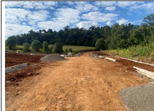
EXECUÇÃO DE COMPACTAÇÃO DE ATERROS 100% P.N, ESCAVAÇÃO, CARGA E TRANSP. 1ª CAT, MEIO-FIO COM SARJETA DER - TIPO 2 - (0,042 M3) - MOLDADO "IN LOCO", FINCADINHA DE CONCRETO - (9X19X39CM-0,0171M3/M), REGULARIZAÇÃO E COMPACTAÇÃO P/ ASSENTAMENTO DE CALÇADAS/LAJOTAS/BLOCOS, COLCHÃO DE PÓ DE PEDRA PARA ASSENTAMENTO DE CALÇADAS, ATERRO C/ MAT. DO CANTEIRO (ESCAV 1ª CAT+TRANSP+COMPACT) - PASSEIO NA RUA AVELINO RUBI ERHART (FOTO 06)
