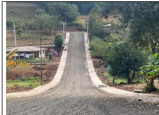
EXECUÇÃO DE, MEIO-FIO COM SARJETA DER - TIPO 2 - (0,042 M3) - MOLDADO "IN LOCO", FINCADINHA DE CONCRETO - (9X19X39CM-0,0171M3/M), REGULARIZAÇÃO E COMPACTAÇÃO P/ ASSENTAMENTO DE CALÇADAS/LAJOTAS/BLOCOS, COLCHÃO DE PÓ DE PEDRA PARA ASSENTAMENTO DE CALÇADAS, ATERRO C/ MAT. DO CANTEIRO (ESCAV 1ª CAT+TRANSP+COMPACT) - PASSEIO, PAVER OU BLOKET E=6CM - SEM COLCHÃO, PAVER OU BLOKET COLORIDO E=6CM - SEM COLCHÃO NA RUA JOSÉ HARRY WILLEMBORG (FOTO 02)
