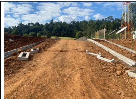
EXECUÇÃO DE COMPACTAÇÃO DE ATERROS 100% P.N, ESCAVAÇÃO, CARGA E TRANSP. 1ª CAT, MEIO-FIO COM SARJETA DER - TIPO 2 - (0,042 M3) - MOLDADO "IN LOCO", FINCADINHA DE CONCRETO - (9X19X39CM-0,0171M3/M), REGULARIZAÇÃO E COMPACTAÇÃO P/ ASSENTAMENTO DE CALÇADAS/LAJOTAS/BLOCOS, COLCHÃO DE PÓ
