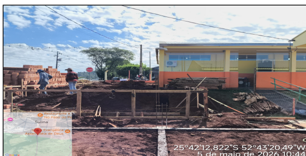
11 | SERVIÇO DE LOCAÇÃO, ESCAVAÇÃO
