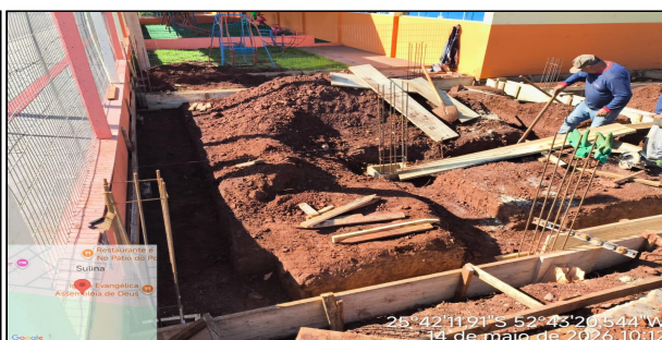
12 | SERVIÇO DE ESCAVAÇÃO, FABRICAÇÃO DE FORMA, MONTAGEM DE FORMA
