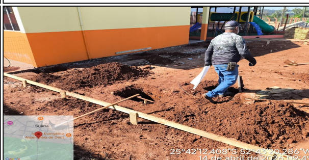
2 | SERVIÇO DE LOCAÇÃO, ESCAVAÇÃO
