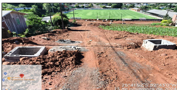
11 | SERVIÇO DE DRENAGEM SENDO EXECUTADO NA RUA VALDOMIRO FRANCISCO DA MOTTA
