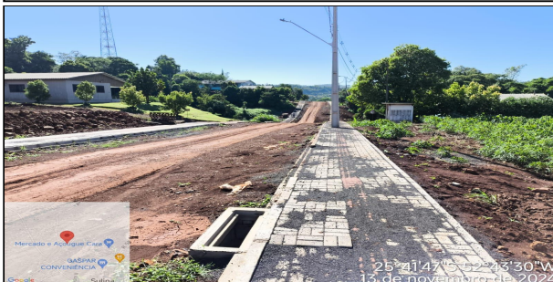
2 | SERVIÇO DE MEIO FIO E SARJETA, SERVIÇO DE URBANIZAÇÃO E SERVIÇO DE DRENAGEM NA AVENIDA IGUAÇU
