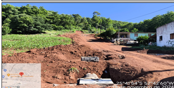
13 | SERVIÇO DE DRENAGEM SENDO EXECUTADO NA RUA VALDOMIRO FRANCISCO DA MOTTA
