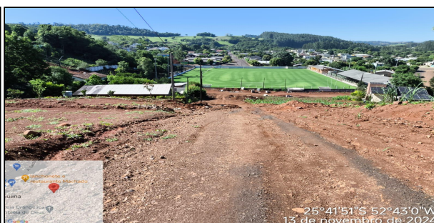
12 | SERVIÇO DE DRENAGEM SENDO EXECUTADO NA RUA VALDOMIRO FRANCISCO DA MOTTA
