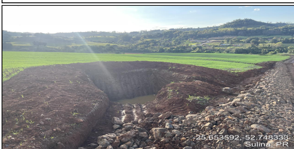
11 | ESTRADA PARA LINHA SEDE OURO - ESCAVAÇÃO DE CAIXA DE CONTENÇÃO CONFORME RTV
