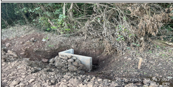
9 | ESTRADA PARA LINHA SEDE OURO - BUEIRO COM ALA
