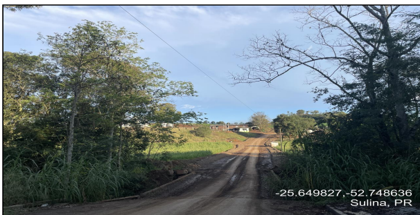
13 | ESTRADA PARA LINHA SEDE OURO - REGULARIZAÇÃO, COMPACTAÇÃO DO SUBLEITO
