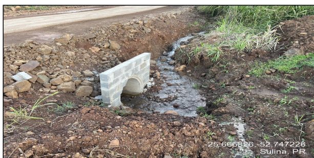
4 | ESTRADA PARA LINHA SEDE OURO - BUEIRO COM ALA
