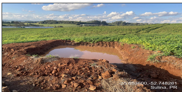
12 | ESTRADA PARA LINHA SEDE OURO - ESCAVAÇÃO DE CAIXA DE CONTENÇÃO CONFORME RTV
