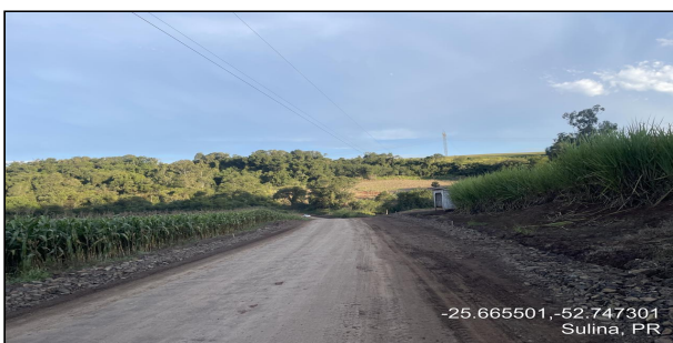
5 | ESTRADA PARA LINHA SEDE OURO - REGULARIZAÇÃO, COMPACTAÇÃO DO SUBLEITO
