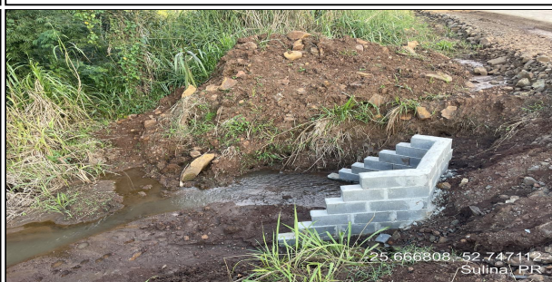
3 | ESTRADA PARA LINHA SEDE OURO - BUEIRO COM ALA
