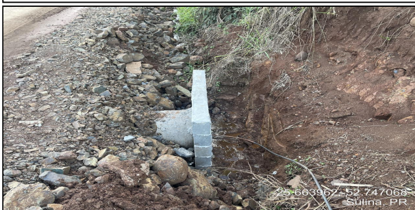
7 | ESTRADA PARA LINHA SEDE OURO - BUEIRO COM ALA
