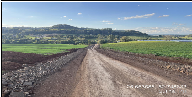
14 | ESTRADA PARA LINHA SEDE OURO - REGULARIZAÇÃO, COMPACTAÇÃO DO SUBLEITO
