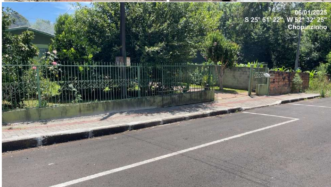
Figura 30 – Na R. Paraná não foram instalados meio-fios novos e as calçadas apresentaram baixa qualidade executiva;
