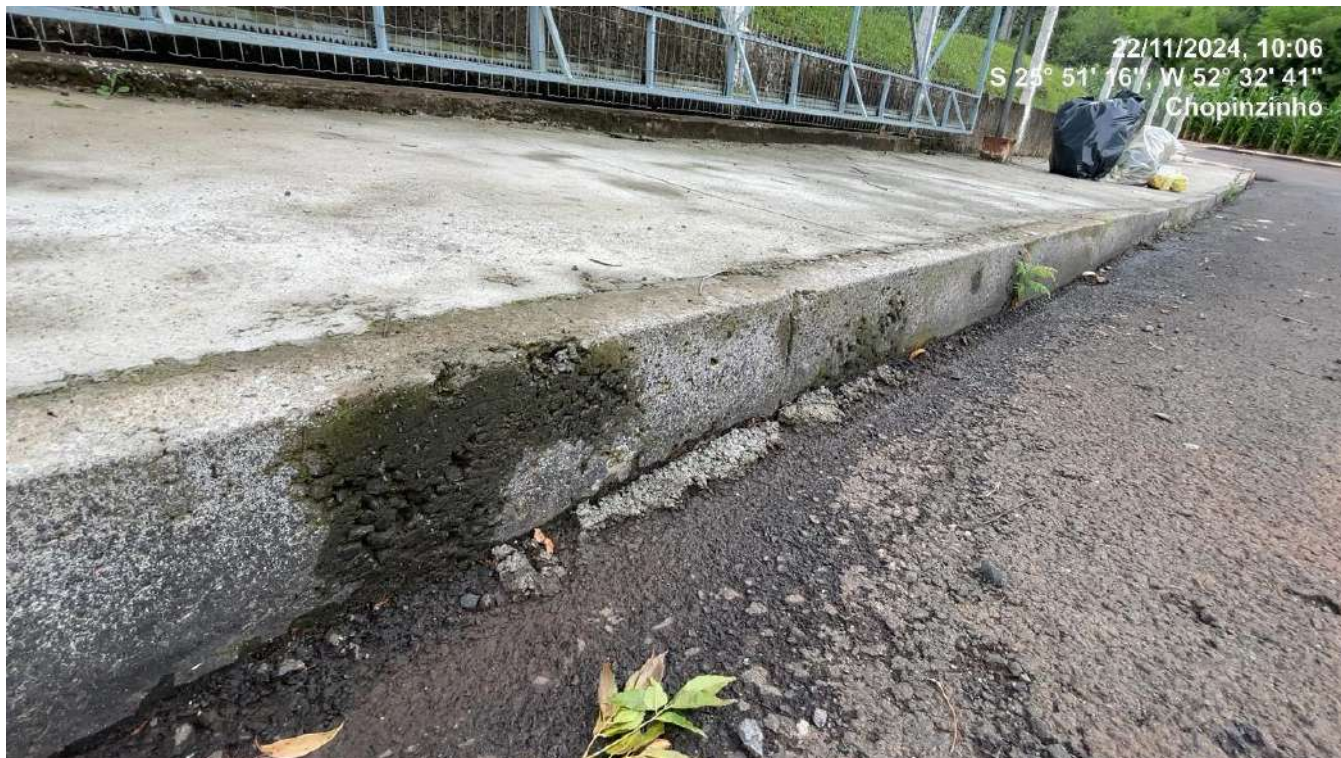
Foto 06 – Meio-fio instalada no Rua Bráulio Sauer
