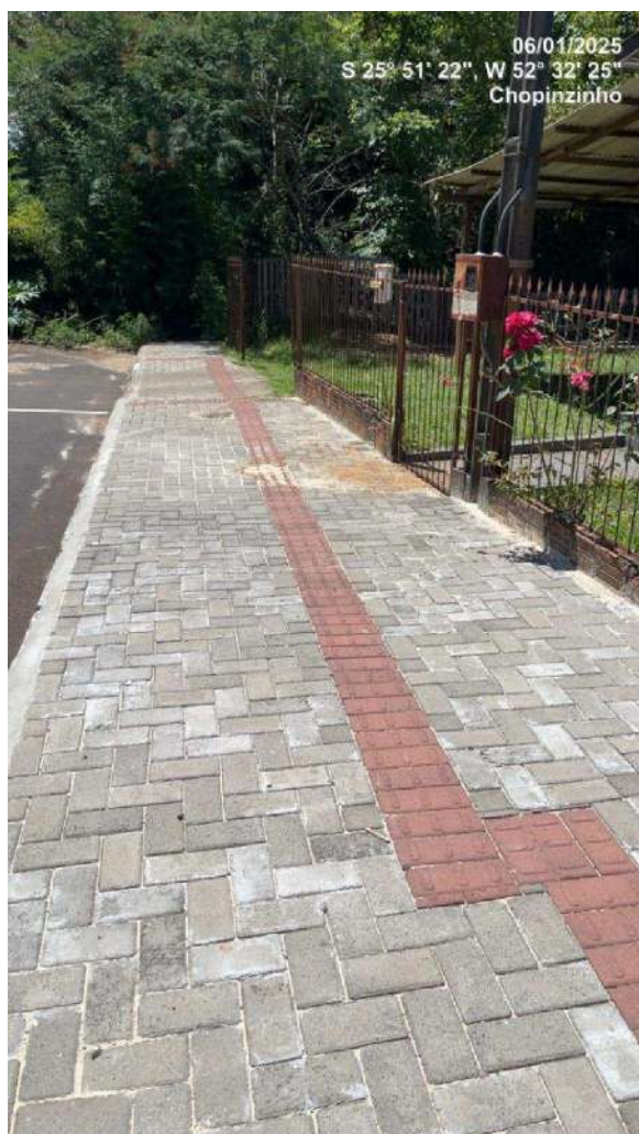
Figura 29 – Calçadas em piso intertravado na R. Paraná apresentaram baixa qualidade executiva; Contratada fez ajustes no acabamento do meio fio e melhorou o travamento das peças.
