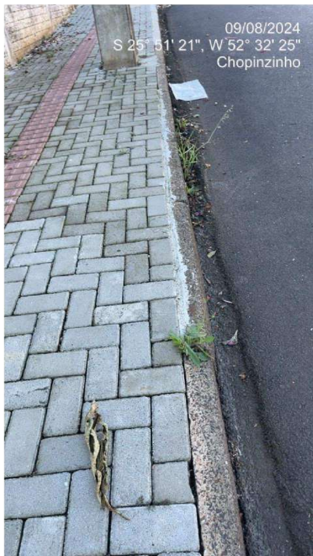
Figura 32 – Na R. São Paulo as calçadas executadas em piso intertravado apresentaram baixa qualidade executiva; (acabamento ruim, tátil com aplicação incorreta em alguns pontos, não execução de uma parte)
