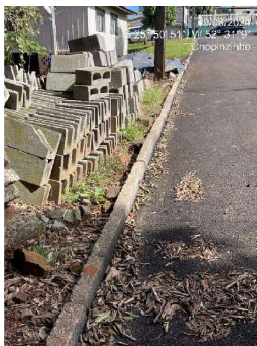
Figura 21 – Calçada de concreto que deveria ter tido meio-fio substituído. Baixa qualidade de execução.
