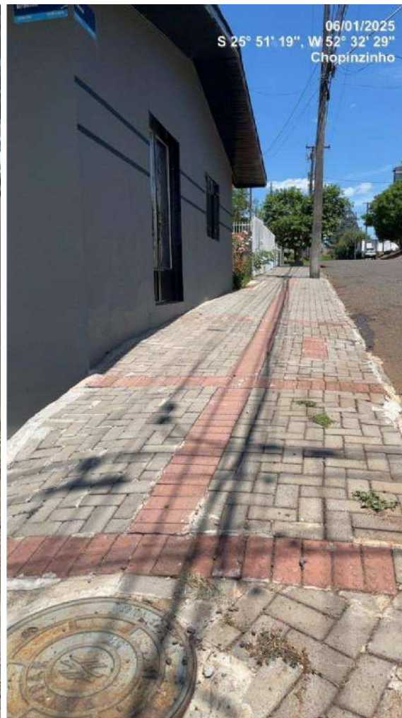
Figura 36 – Calçadas em piso intertravado na R. Brasília – Trecho 03 apresentaram baixa qualidade executiva;
