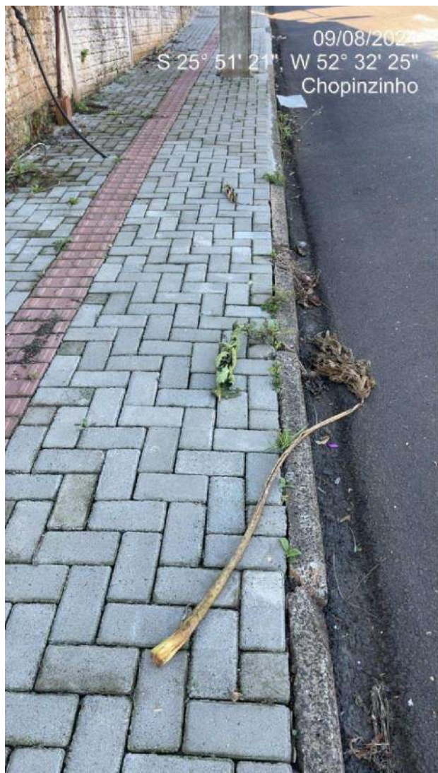
Figura 32 – Na R. São Paulo as calçadas executadas em piso intertravado apresentaram baixa qualidade executiva; (acabamento ruim, tátil com aplicação incorreta em alguns pontos, não execução de uma parte)
