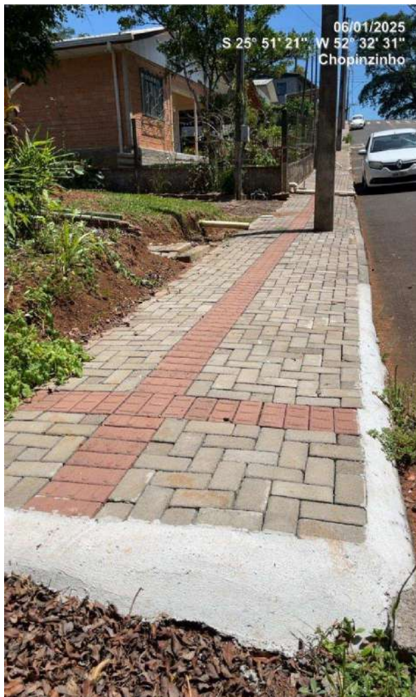
Figura 36 – Calçadas em piso intertravado na R. Brasília – Trecho 03 apresentaram baixa qualidade executiva;
