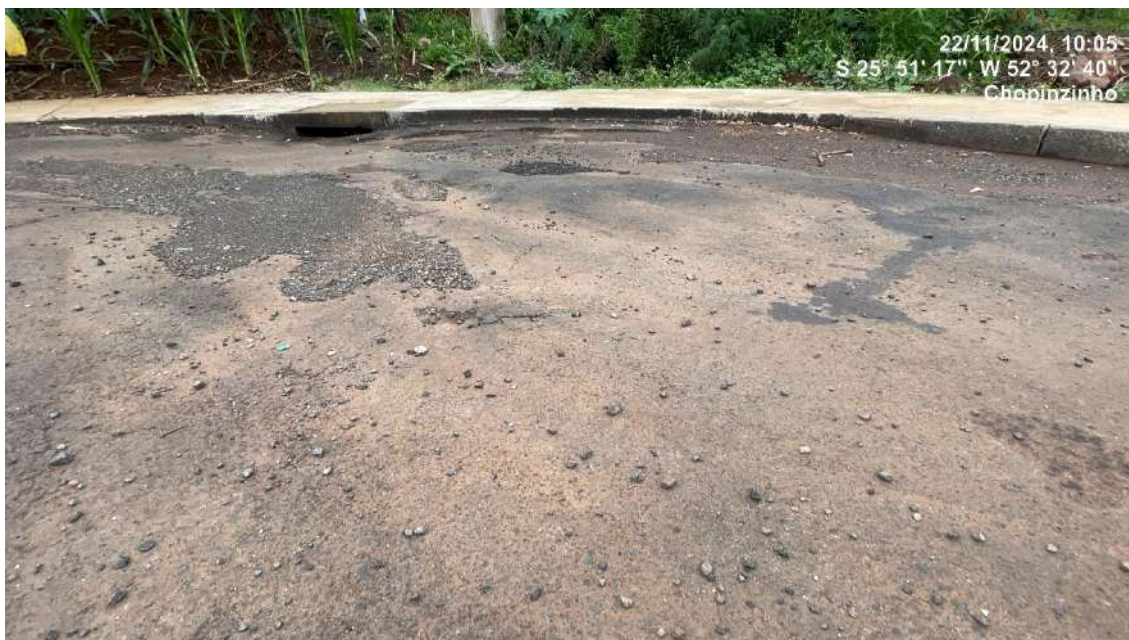
Foto 03 – Condições do pavimento ao final da Rua Prof. Bráulio Sauer. Ondulações no pavimento, falta de compactação, trincas.
