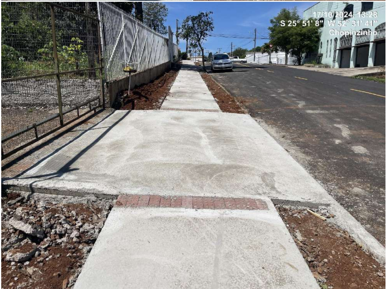
Figura 27 – Calçada de concreto executada na R. Miguel Procópio Kurpel
