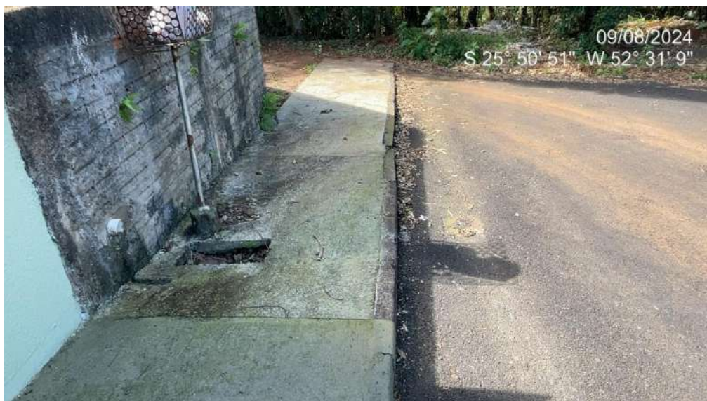
Foto 20 – Calçada em concreto na Tva. Alferes Joaquim Ferreira com baixa qualidade executiva, meio-fio desalinhado.
