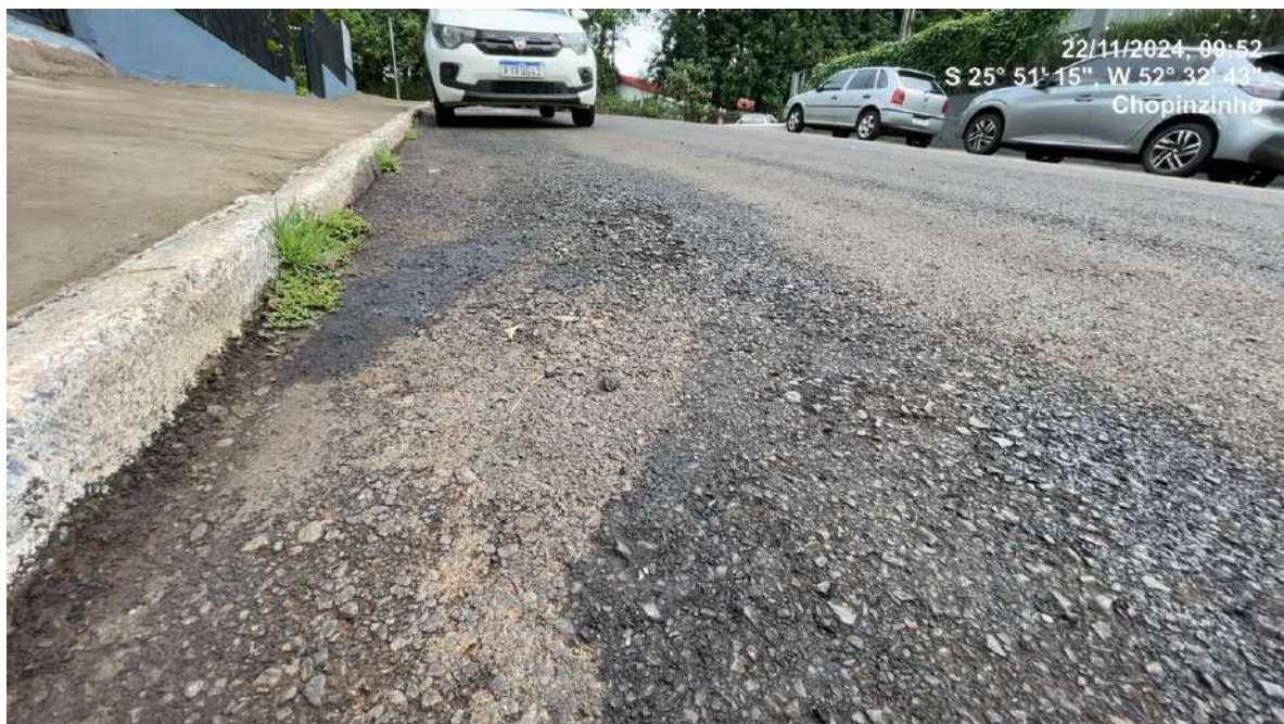
Foto 05 – Capeamento da Rua Bráulio Sauer apresentado desagregação e porosidade.
