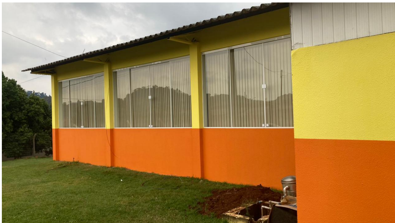
Esquadrias Sala de Informática
