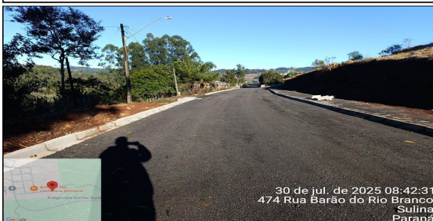
2 | SERVIÇO DE DRENAGEM NA RUA BARÃO DO RIO BRANCO
