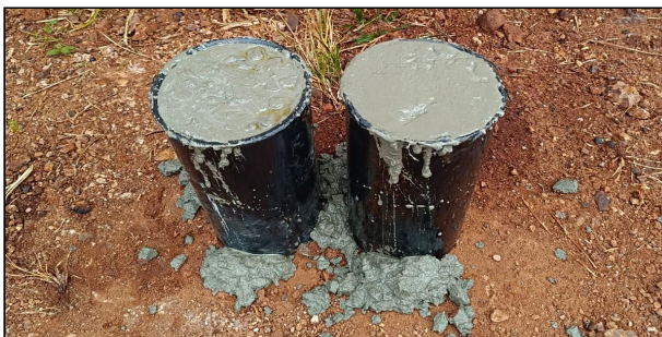
13 | CORPOS DE PROVA DE CONTROLE DA EMPRESA EXECUTORA
