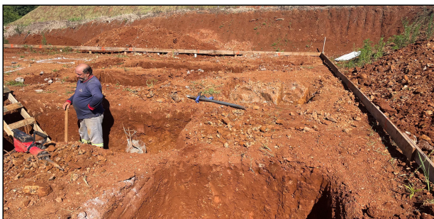
4 | ESCAVAÇÃO DOS BLOCOS APOS CONCRETAGEM DAS ESTACAS
