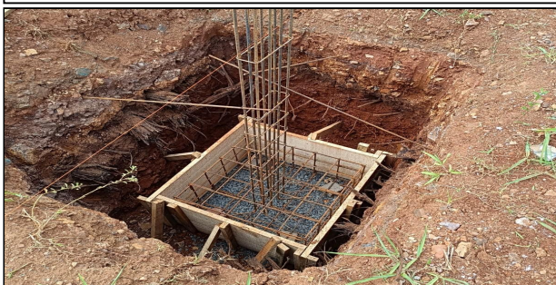
6 | CONFERENCIA DAS ARMADURAS DOS BLOCOS E FORMAS PARA CONCRETAGEM
