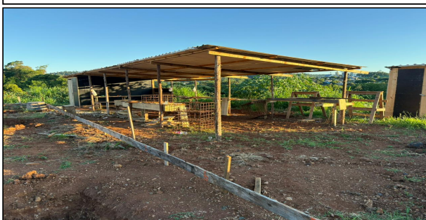
11 | CENTRAL DE ARMADURAS, DEPOSITO E SANITARIO
