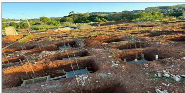
12 | FUNDAÇÃO CONCRETADA
