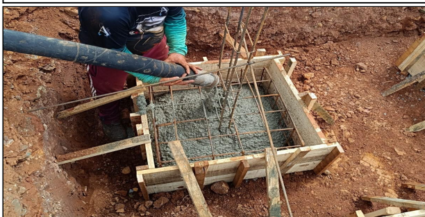
8 | CONCRETAGEM DOS BLOCOS
