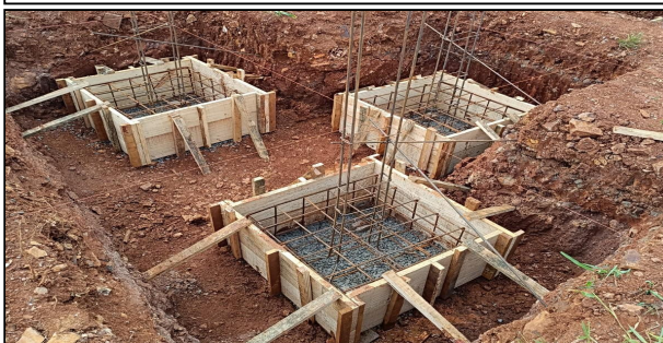
7 | CONFERENCIA DAS ARMADURAS DOS BLOCOS E FORMAS PARA CONCRETAGEM
