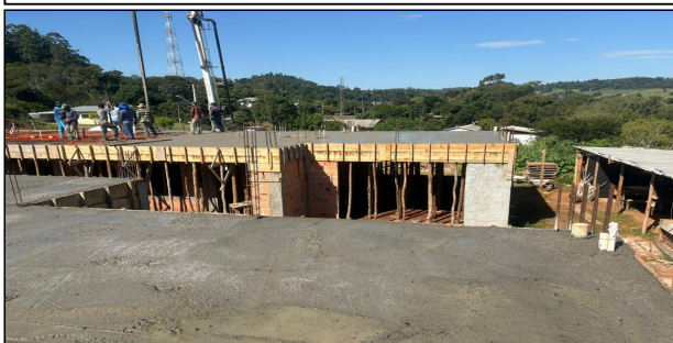
10 | LAGE E CONCRETAGEM
