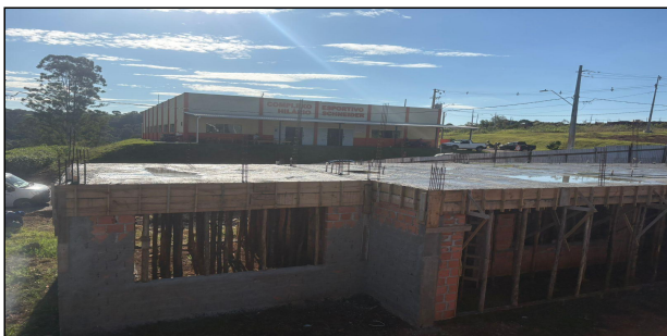
15 | LAGE E CONCRETAGEM
