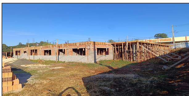
7 | LAGE E CONCRETAGEM
