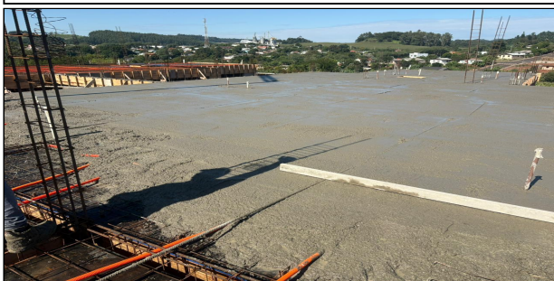
11 | LAGE E CONCRETAGEM
