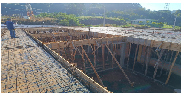
6 | LAGE E CONCRETAGEM
