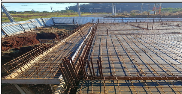
4 | LAGE E CONCRETAGEM
