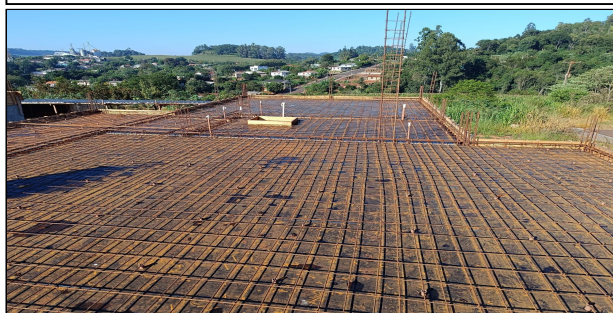
3 | LAGE E CONCRETAGEM
