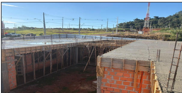
14 | LAGE E CONCRETAGEM
