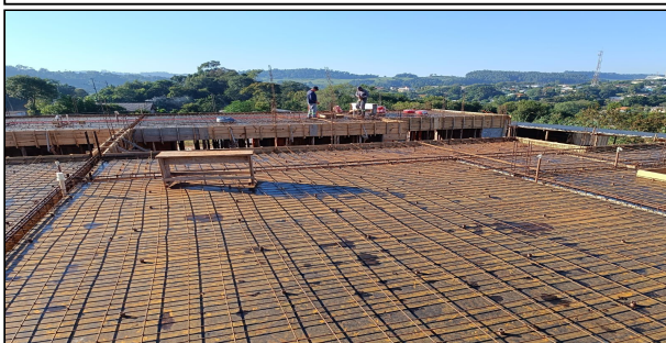
8 | LAGE E CONCRETAGEM
