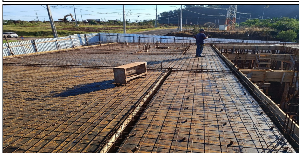
5 | LAGE E CONCRETAGEM
