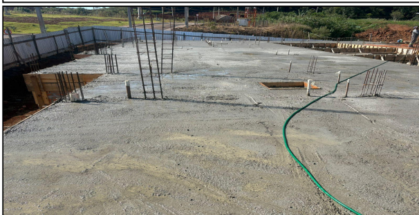
12 | LAGE E CONCRETAGEM
