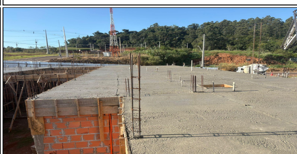
16 | LAGE E CONCRETAGEM
