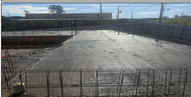
13 | LAGE E CONCRETAGEM
