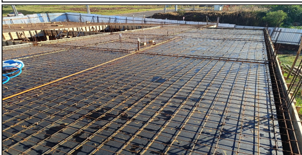
9 | LAGE E CONCRETAGEM
