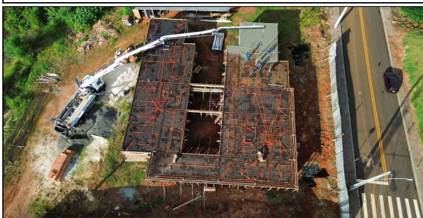
17 | LAGE E CONCRETAGEM
