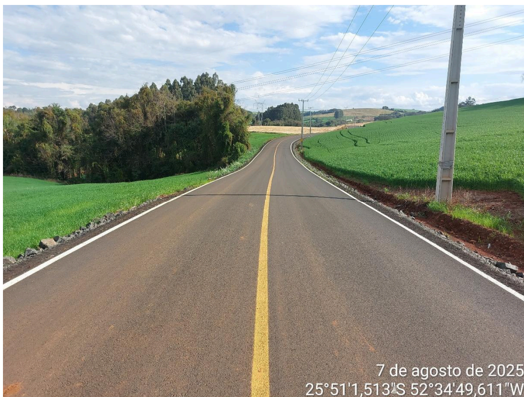
Foto 13. Serviços de pavimentação asfáltica e sinalização viária concluídos.
