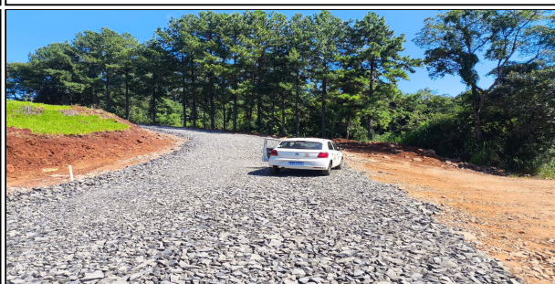
10 | SERVIÇO EXECUTADO DE BASE / SUB-BASE - ESTRADA RURAL LINHA BOM JESUS
