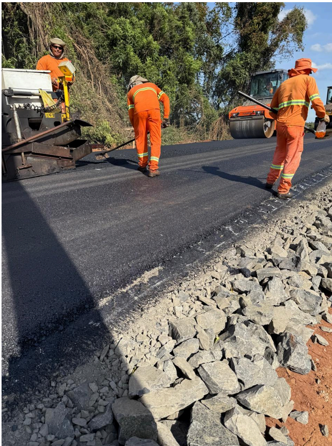
Foto 11. Execução da pavimentação asfáltica.
