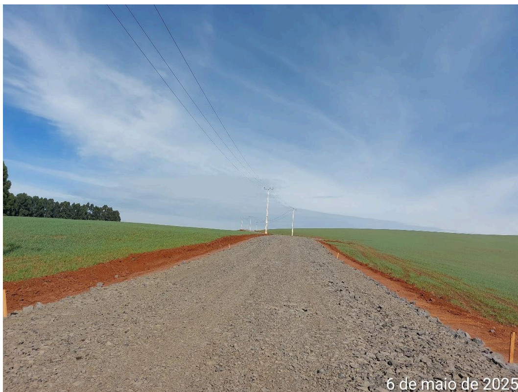
Foto 06. Execução da sub-base em macadame seco.
