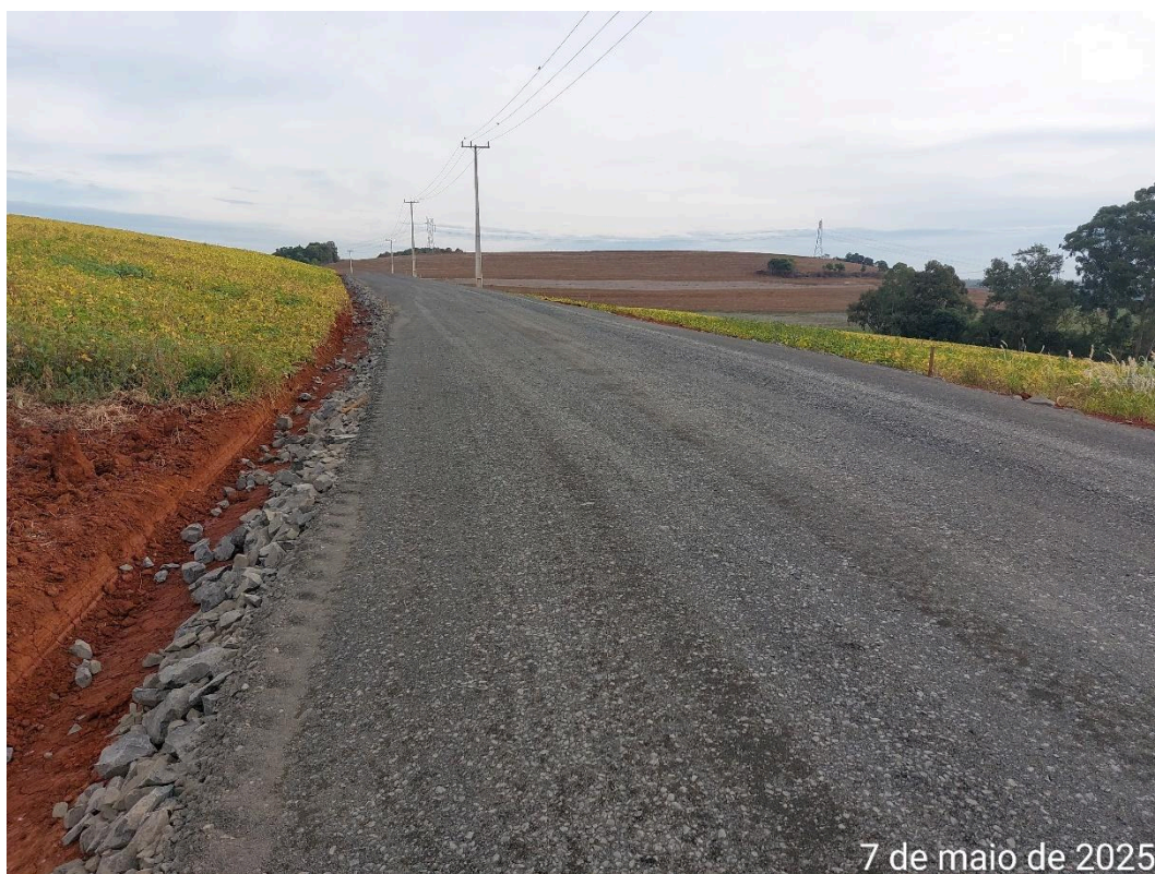
Foto 09. Execução da base em brita graduada.
