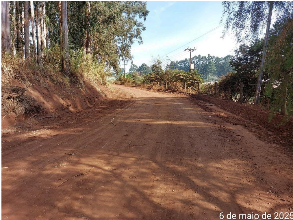
Foto 04. Execução da terraplanagem.
