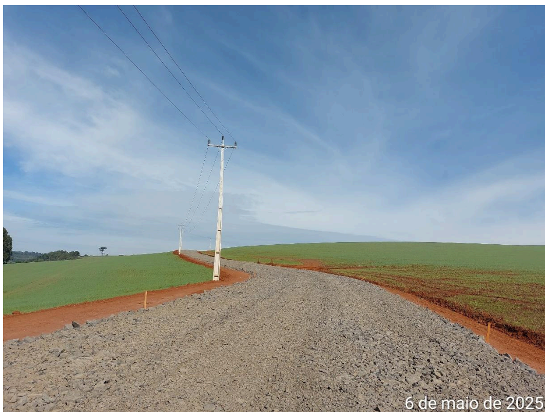
Foto 07. Execução da sub-base em macadame seco.
