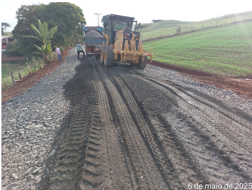
Foto 08. Execução da base em brita graduada.
