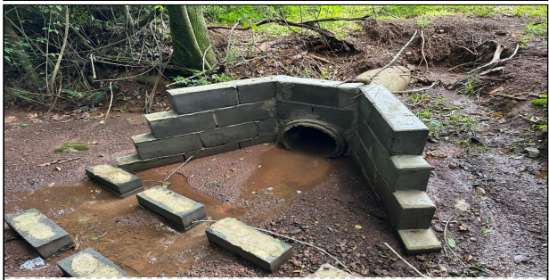
9 | RUA 02 – SERVIÇO EXECUTADO DE TERRAPLENAGEM, DRENAGEM
