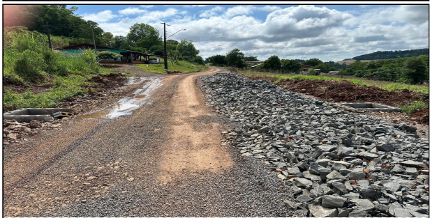
11 | RUA 04 – SERVIÇO EXECUTADO DE TERRAPLENAGEM, DRENAGEM
