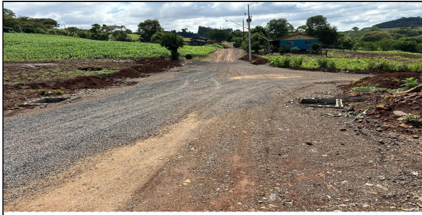
6 | RUA 02 – SERVIÇO EXECUTADO DE TERRAPLENAGEM, DRENAGEM
