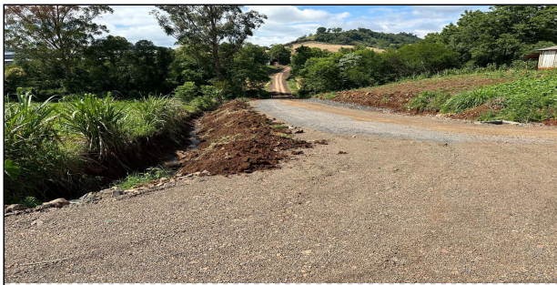
4 | RUA 01 – SERVIÇO EXECUTADO DE TERRAPLENAGEM, DRENAGEM
