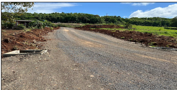
13 | RUA 03 – SERVIÇO EXECUTADO DE TERRAPLENAGEM, DRENAGEM
