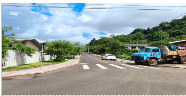
20 | RUA SANTOS DUMONT, SERVIÇO DE SINALIZAÇÃO DE TRÂNSITO EXECUTADO
