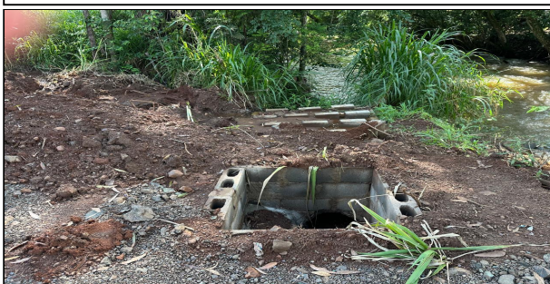
3 | RUA 01 – SERVIÇO EXECUTADO DE TERRAPLENAGEM, DRENAGEM
