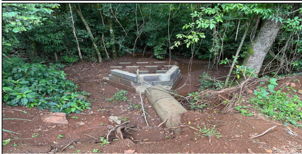
10 | RUA 02 – SERVIÇO EXECUTADO DE TERRAPLENAGEM, DRENAGEM
