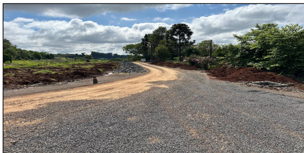
12 | RUA 03 – SERVIÇO EXECUTADO DE TERRAPLENAGEM, DRENAGEM
