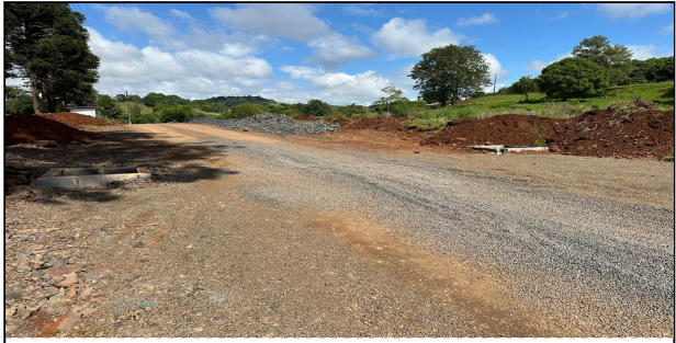
7 | RUA 02 – SERVIÇO EXECUTADO DE TERRAPLENAGEM, DRENAGEM
