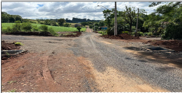
8 | RUA 02 – SERVIÇO EXECUTADO DE TERRAPLENAGEM, DRENAGEM
