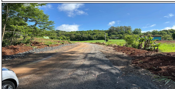
2 | RUA 01 – SERVIÇO EXECUTADO DE TERRAPLENAGEM, DRENAGEM
