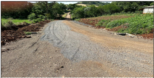
5 | RUA 01 – SERVIÇO EXECUTADO DE TERRAPLENAGEM, DRENAGEM
